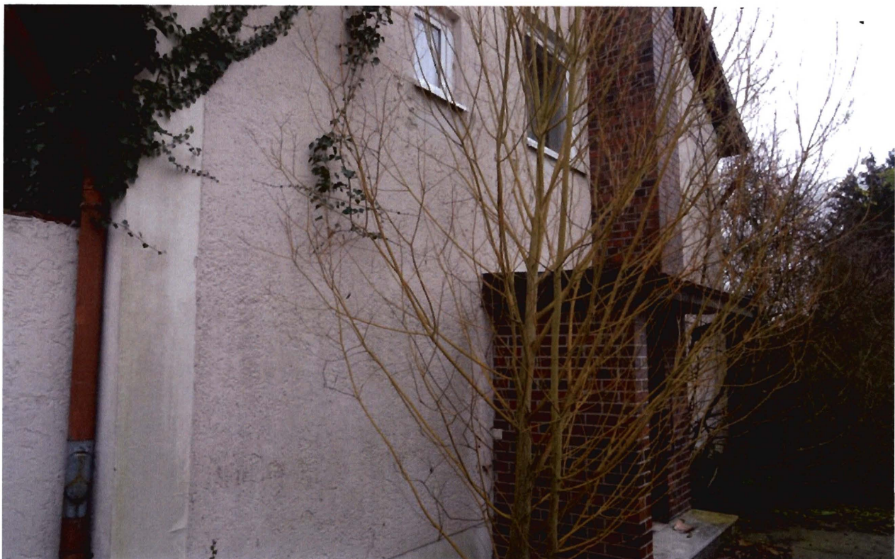
Teilansicht auf das Wohngebäude von Norden
