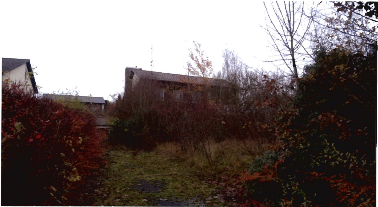
Ansicht auf das Anwesen von Südwesten
