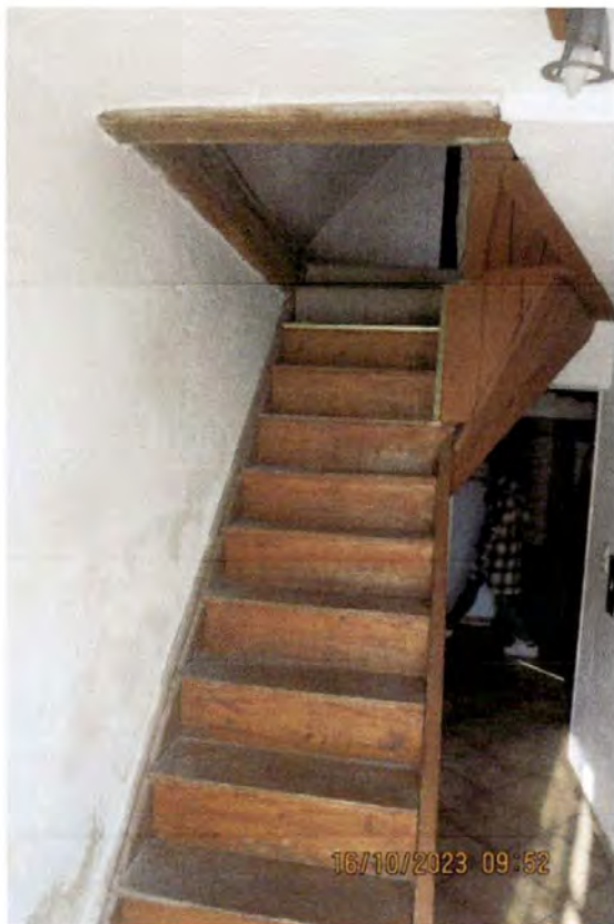
Bild 3 – Treppenaufgang zum Dachgeschoss
