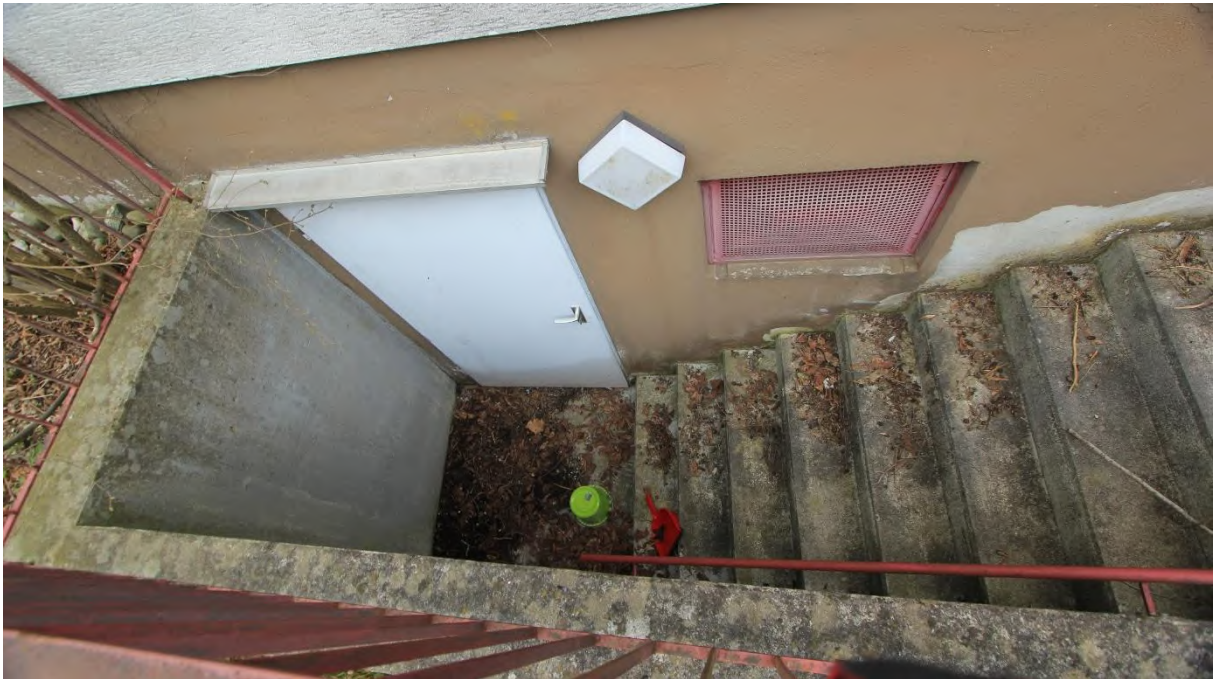
Kelleraußentreppe im Westen von oben
