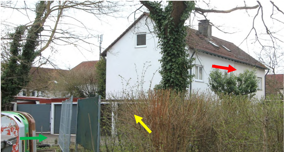
Blick von Nordosten, grün Garagenhof, gelber Pfeil Garage, rot Doppelhaushälfte
