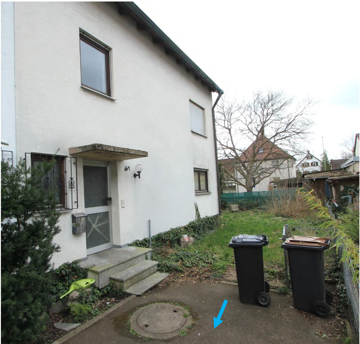
Nordseite Doppelhaushälfte mit Hauseingang, blau gemeinsamer Fußweg
