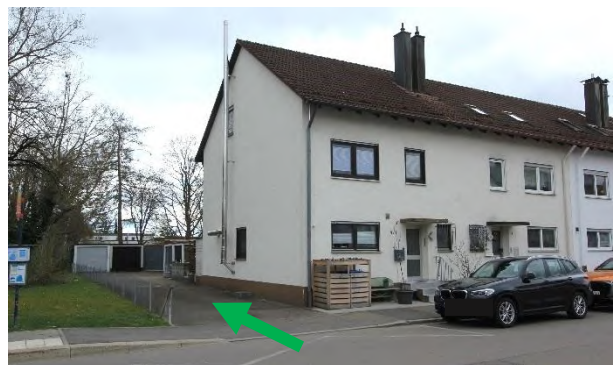
Zufahrt zum Garagenhof Flst. 862/34
