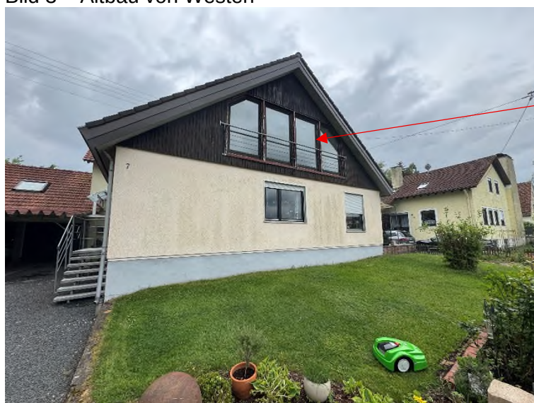
Bild 3 – Altbau von Westen
