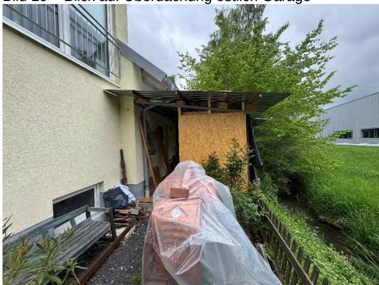
Bild 10 – Blick auf Überdachung östlich Garage
