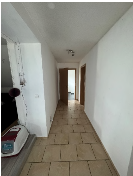
Bild 29 und Bild 30 – Flur OG
