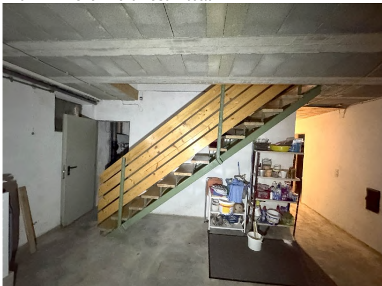
Bild 12 – Keller Northwest Altbau
