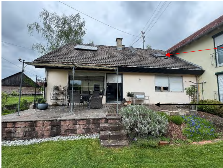
Bild 4 – Altbau von Süden
