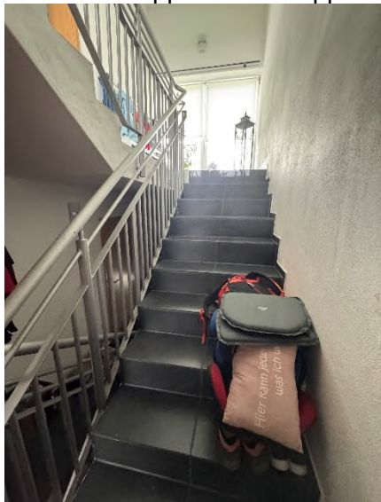
Bild 20 und Bild 21 – Flur EG
