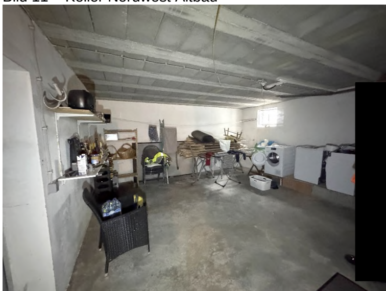
Bild 11 – Keller Northwest Altbau
