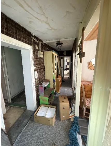
Bild 50 – Flur Wohnung 2. OG Südwest
