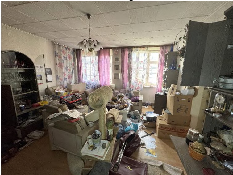
Bild 35 – Wohnzimmer Wohnung Ost 1. OG
