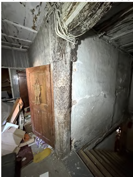
Bild 29 – Eichenholzstütze mit Schnitzereien im TRH/Flur 1. OG
