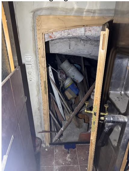
Bild 22 – Zugang Gewölbekeller EG
