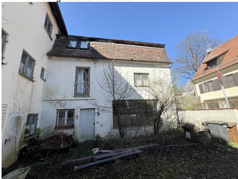
Bild 7 – Rückgebäude von Osten
