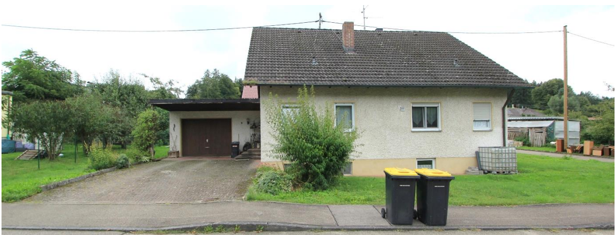
Wohnhaus mit Garage von Norden
