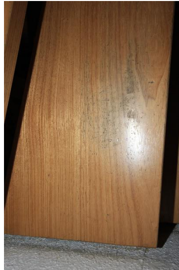
Abgenutzte Holzstufen
