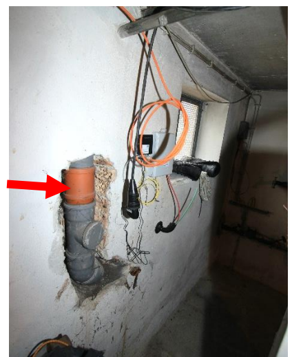
Geflicktes Abwasserrohr
