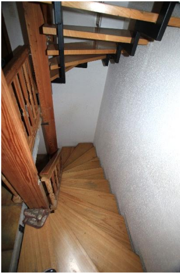
Kellertreppe von oben
