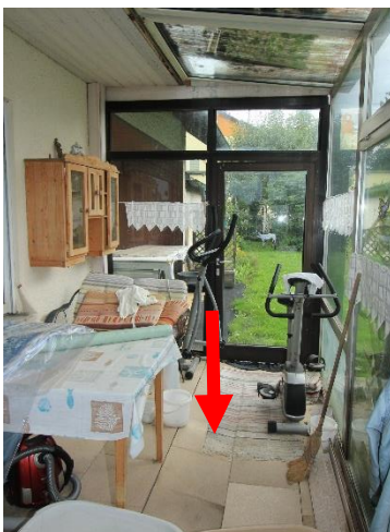
Unfachmännisch zusammengebauter Wintergarten, Pfeil Bodenabsenkungen
