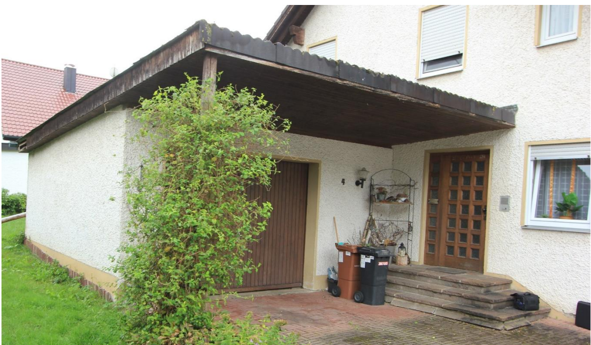
Garage und Hauseingang von Norden
