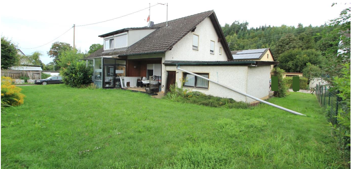
Grundstück von Südosten
