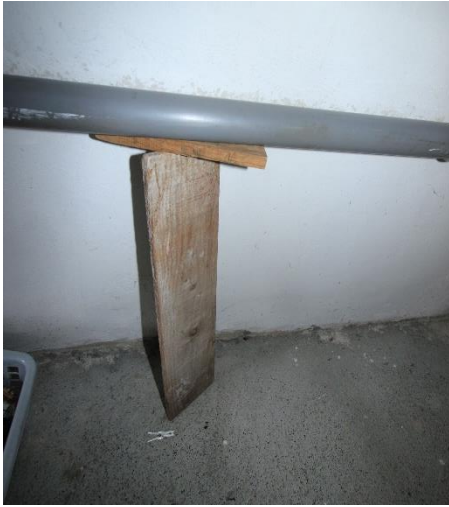
Abgestütztes Abwasserrohr
