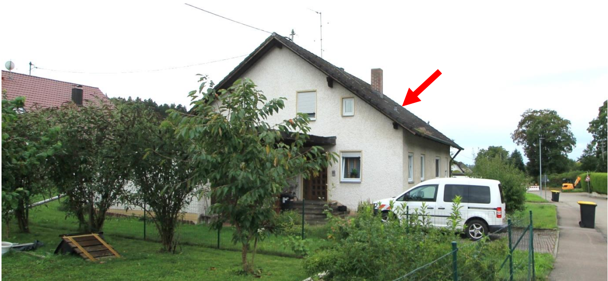
Blick von Osten, Pfeil Wohnhaus
