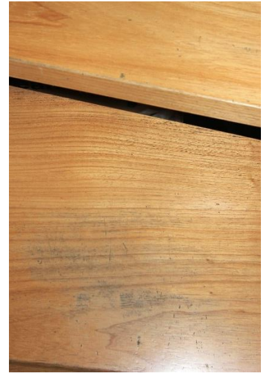
Abgenutzte Holzstufen
