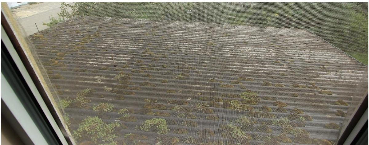
Alte Wellasbestplattendeckung
