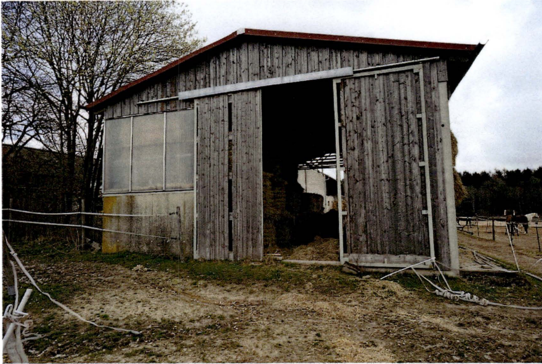
Bild 18: Die Bergehalle, Westseite mit den defekten Schiebetoren
