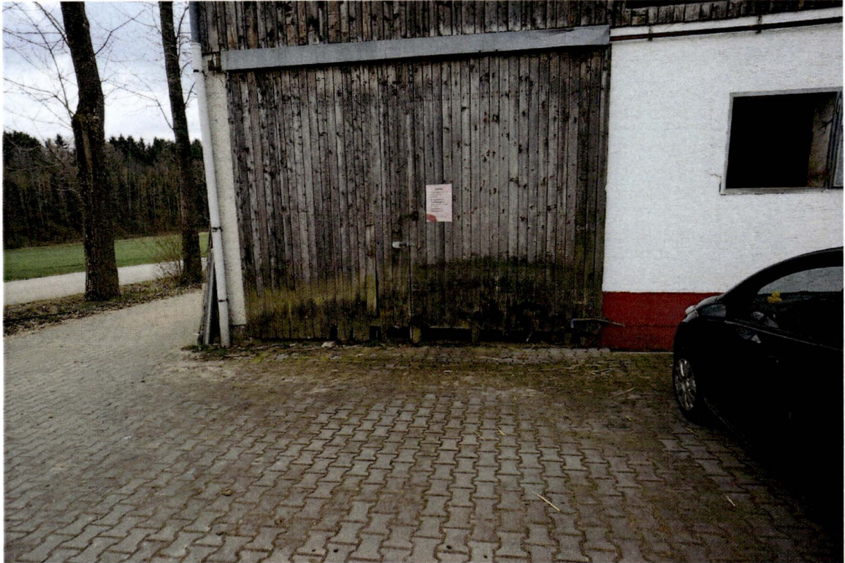
Bild 8: Das schadhafte Tor der Durchfahrt
