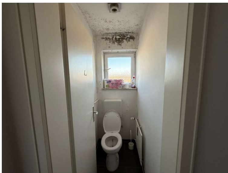
WC mit Schimmelbildung über dem Fenster
