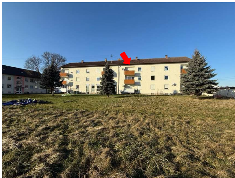
Ansicht der Wohnanlage von Südosten Pfeil: Balkon der Wohnung Nr. 10
