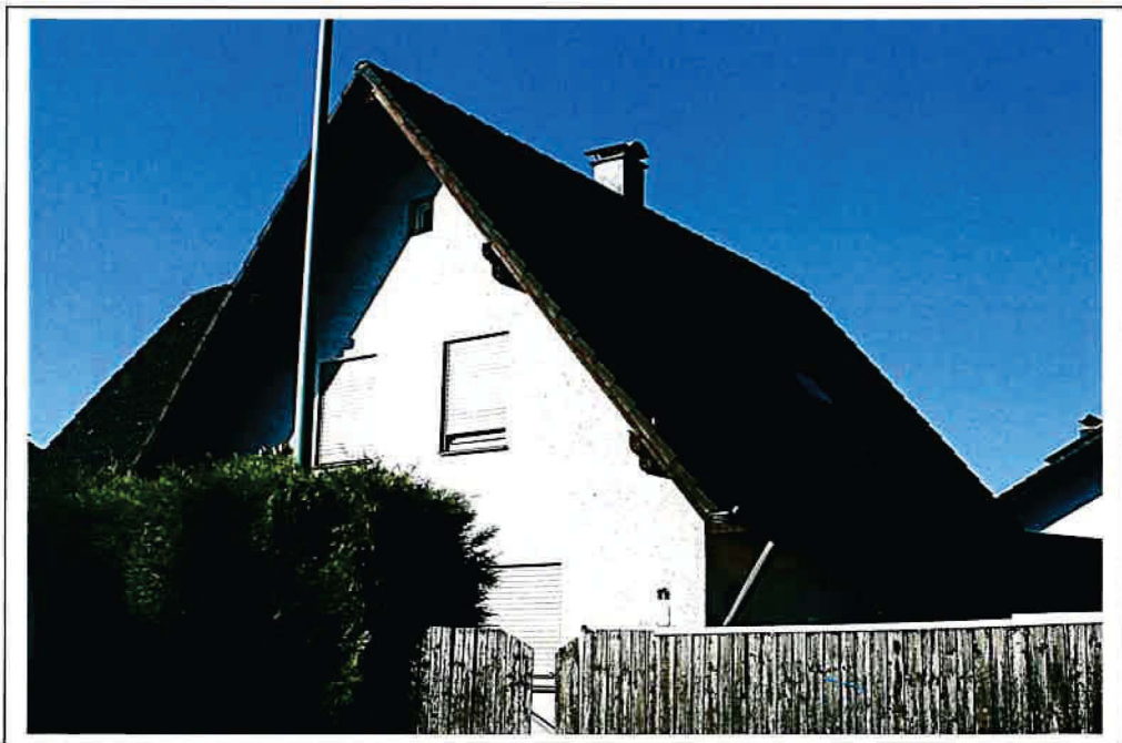
Foto 4: 89269 Vöhringen, Bayerstraße 14; Ansicht Nordost
