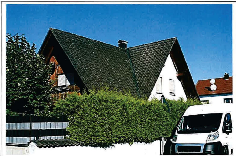
Foto 2: 89269 Vöhringen, Bayerstraße 14; Ansicht Südost
