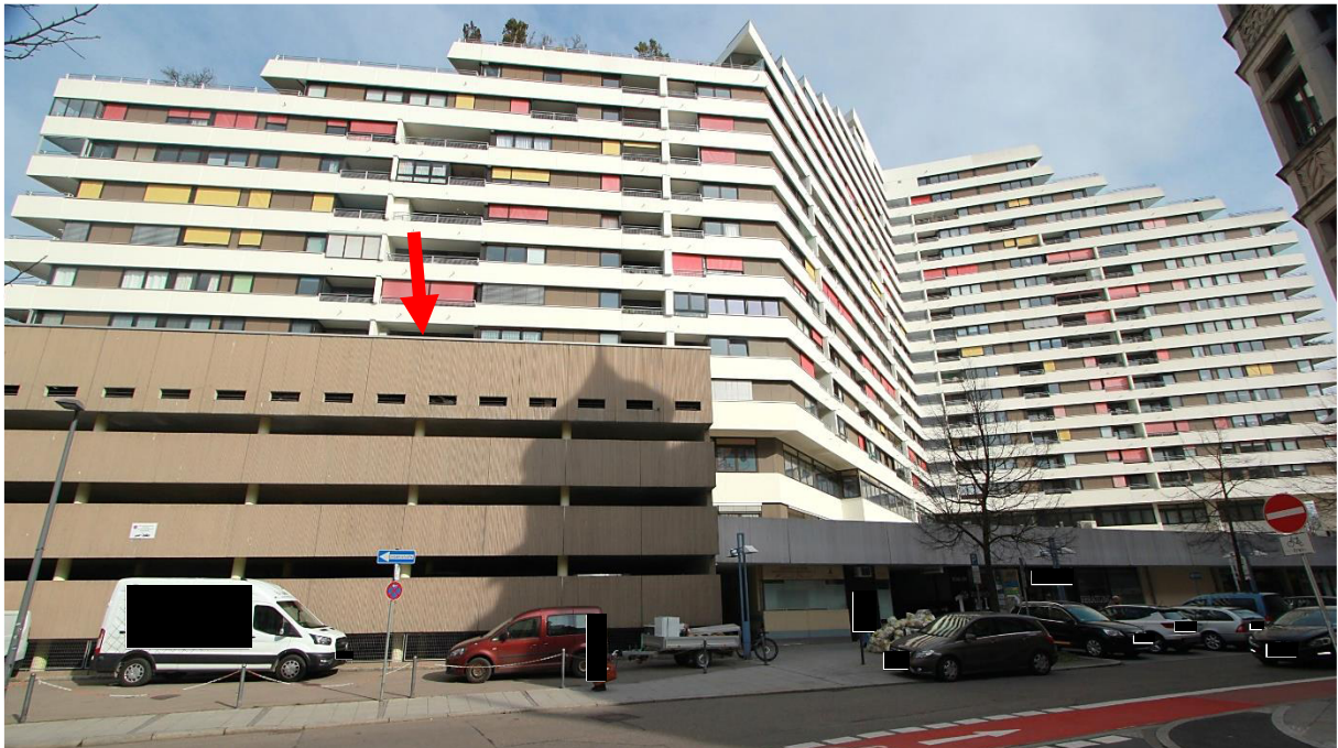
Blick von Süden zum Donaucenter, Pfeil (ein Geschoss tiefer) Wohnung ATP Nr. 315 im 3. OG
