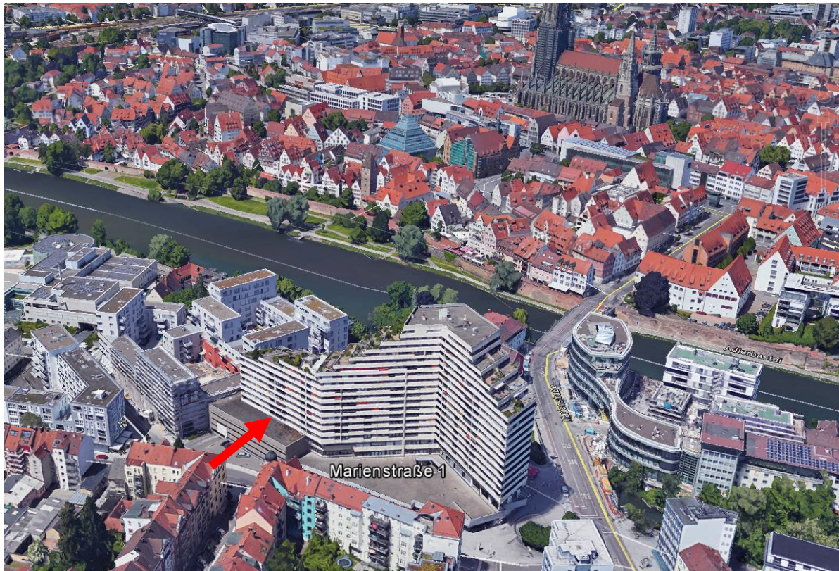
Donaueck von Südosten, Pfeil Wohnung ATP Nr. 315 im 3.OG über dem Garagendach
