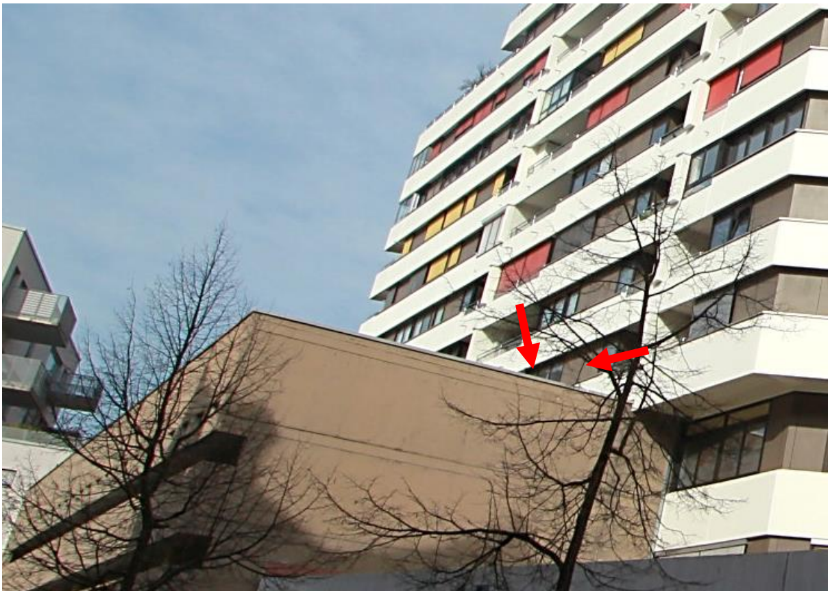
Donaucenter von Südosten, Pfeile Wohnung ATP Nr. 315 im 3. OG, darunter Parkgarage
