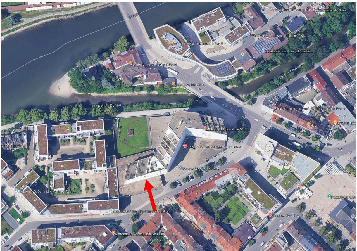
Donaucenter von oben, Pfeil Wohnung ATP Nr. 315 im 3.OG
