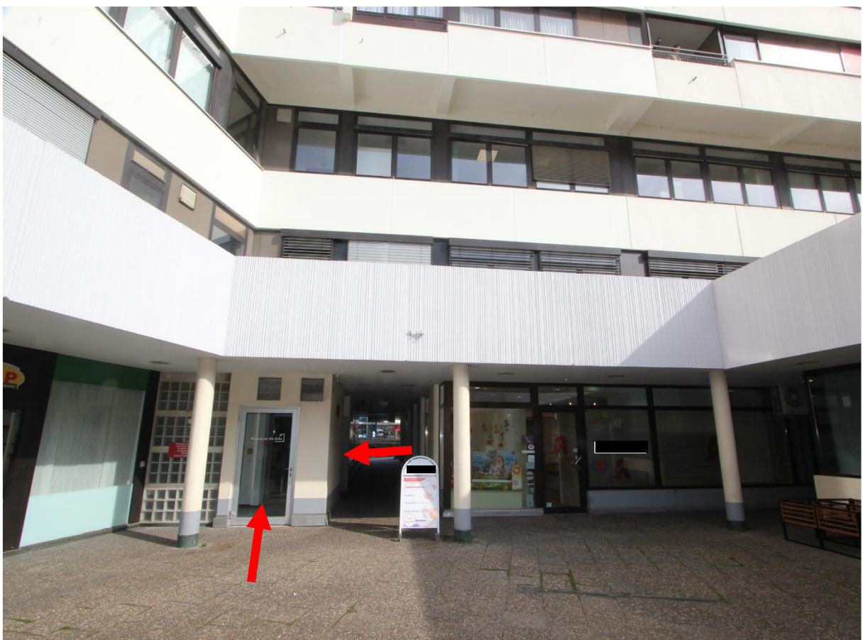
Innenhof im EG, Pfeil Ein- und Ausgang zum Treppenhaus und zu den Aufzügen
