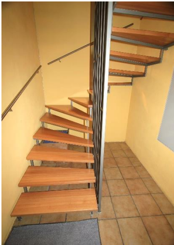
Kellertreppe im UG
