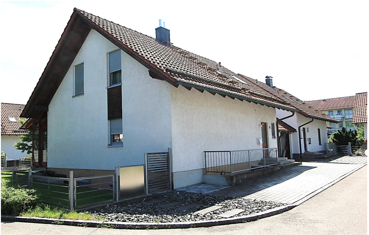
Wohnhaus von Nordosten
