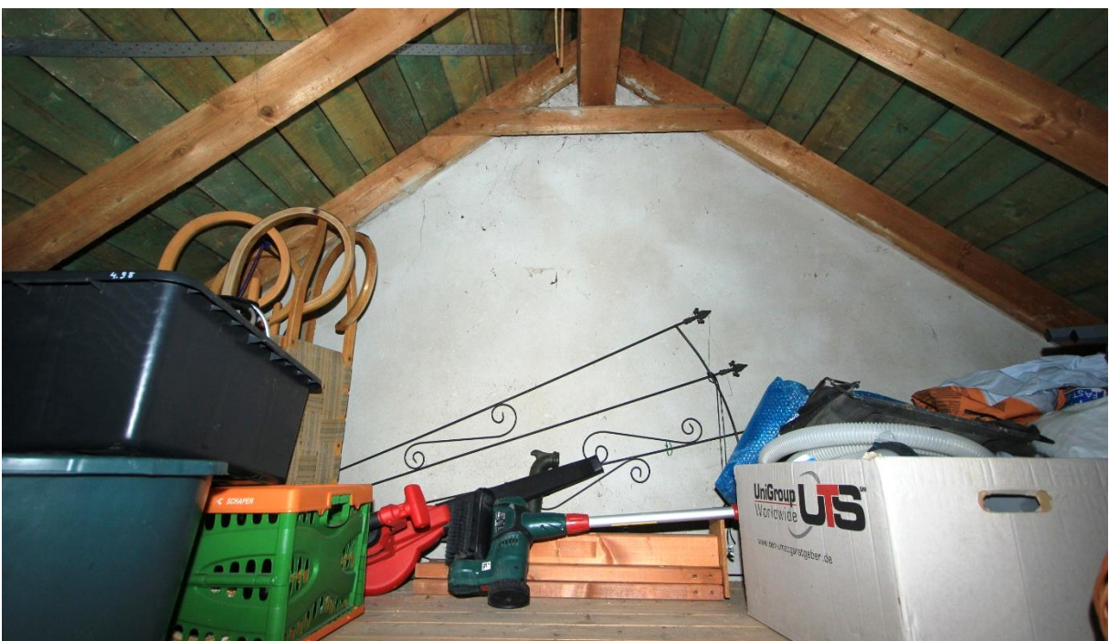
Bühne im Dach der Garage
