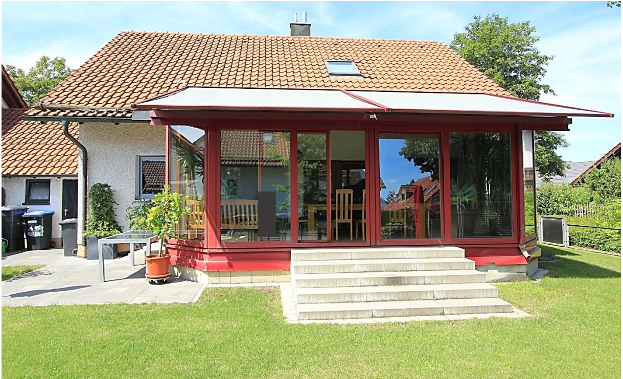
Südseite Wohnhaus mit Treppenaufgang zum Wintergarten
