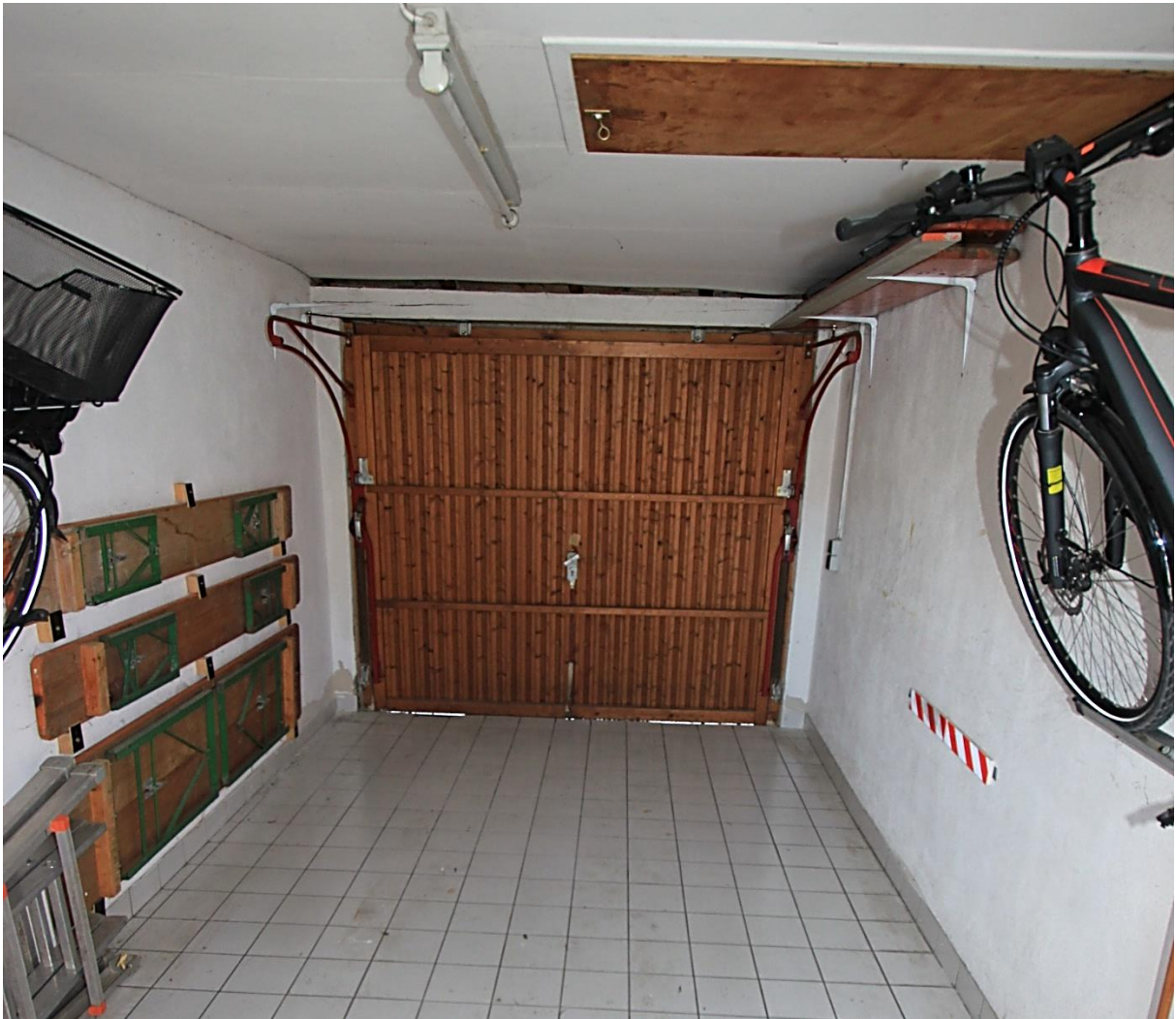
Garage von innen mit Garagentor und Luke zum Dach
