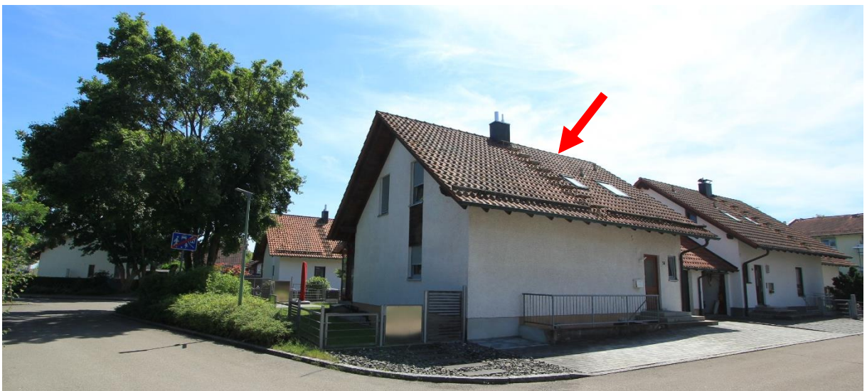
Grundstück mit Vorplatz im Norden von Nordosten, Pfeil Wohnhaus
