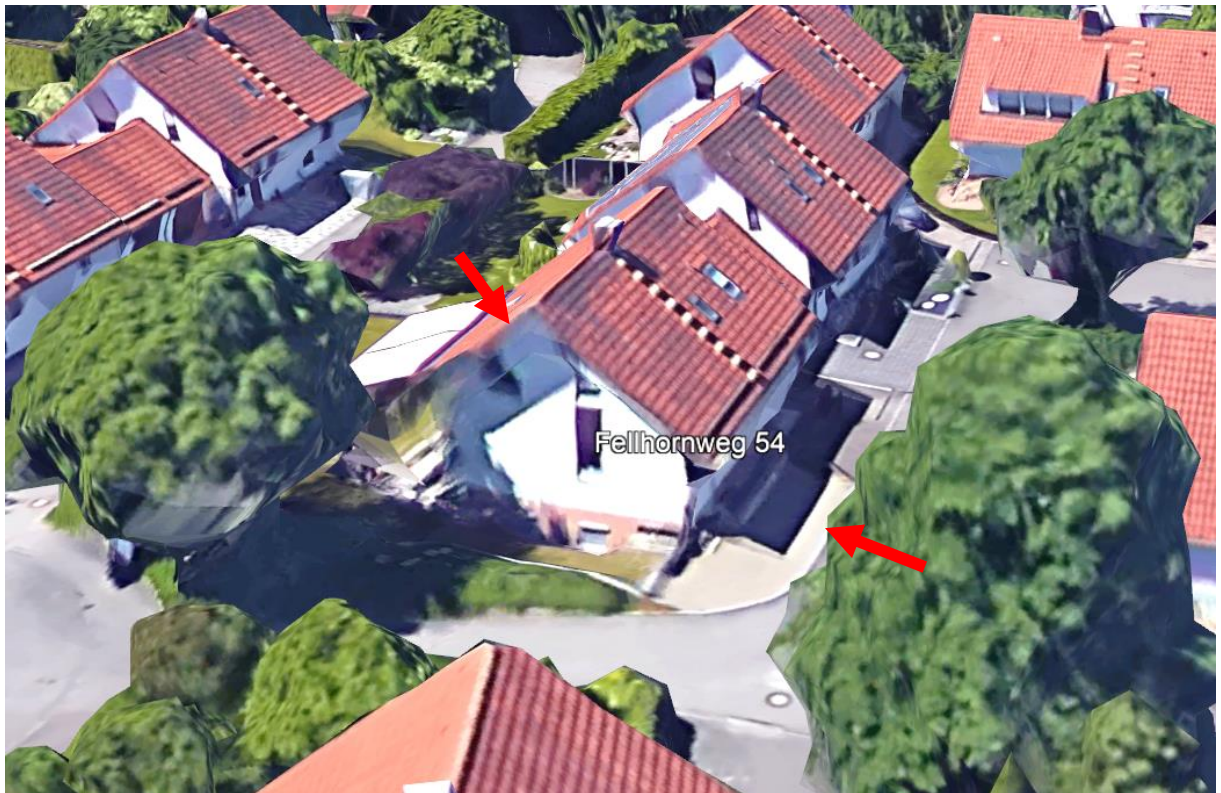
Blick von Osten, rote Pfeile Grundstück
