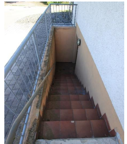
Kelleraußentreppe im Norden
