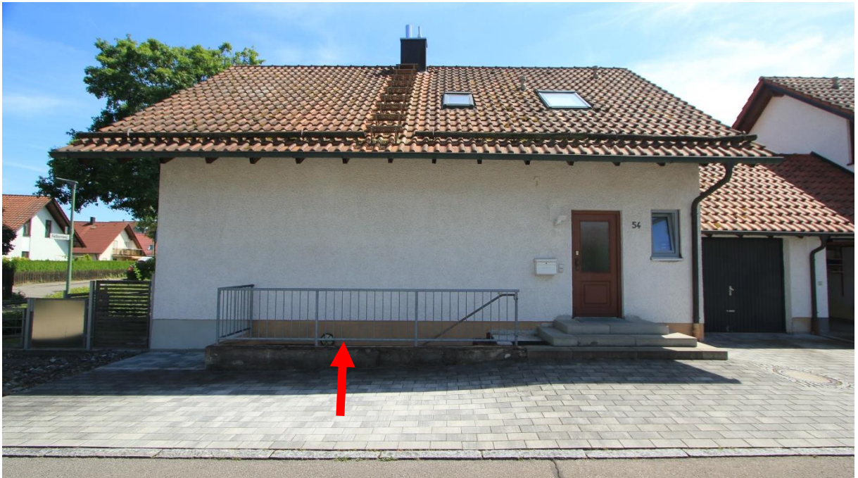
Nordseite Wohnhaus, Pfeil Kelleraußentreppe, rechts Garagenanbau
