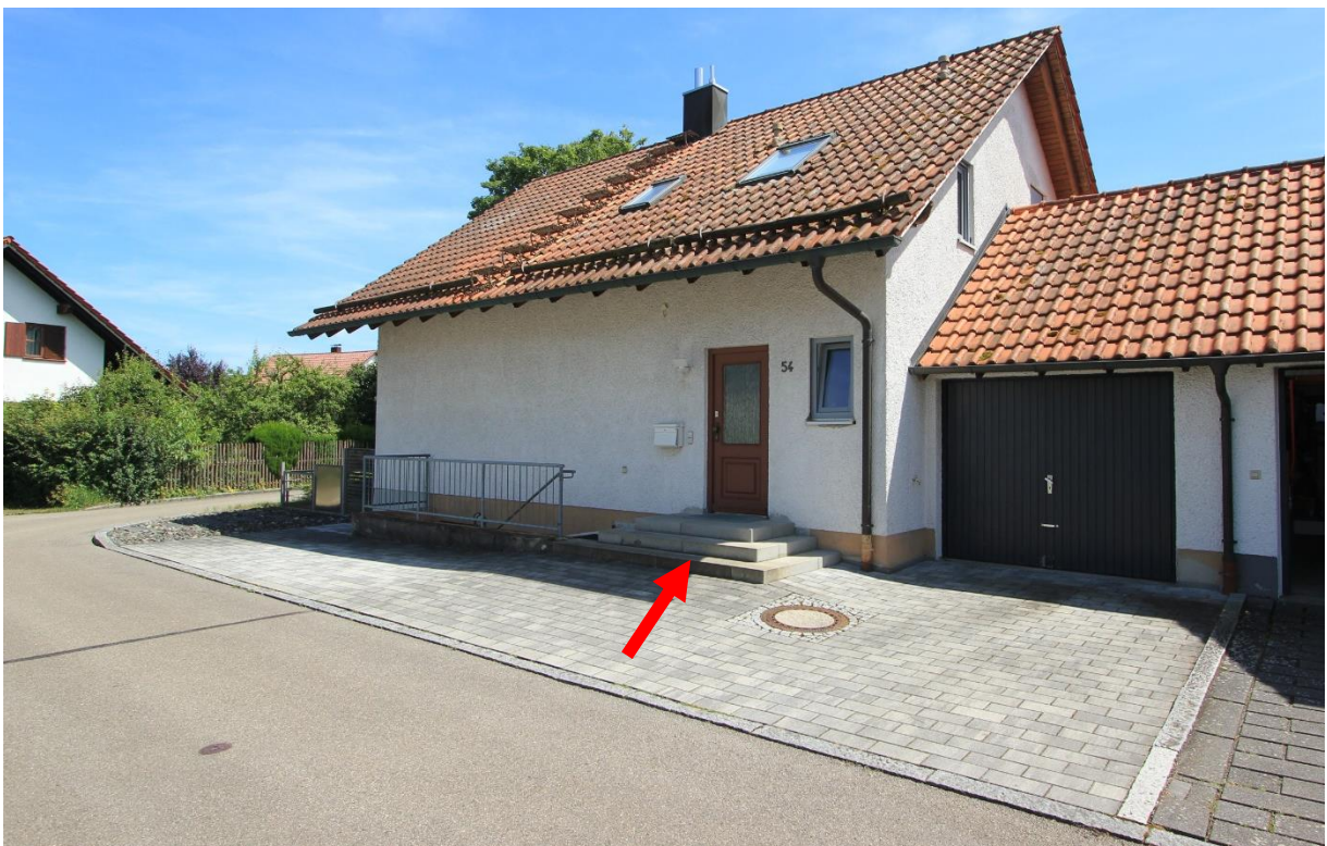
Wohnhaus mit Garage von Nordwesten, Pfeil Hauseingang
