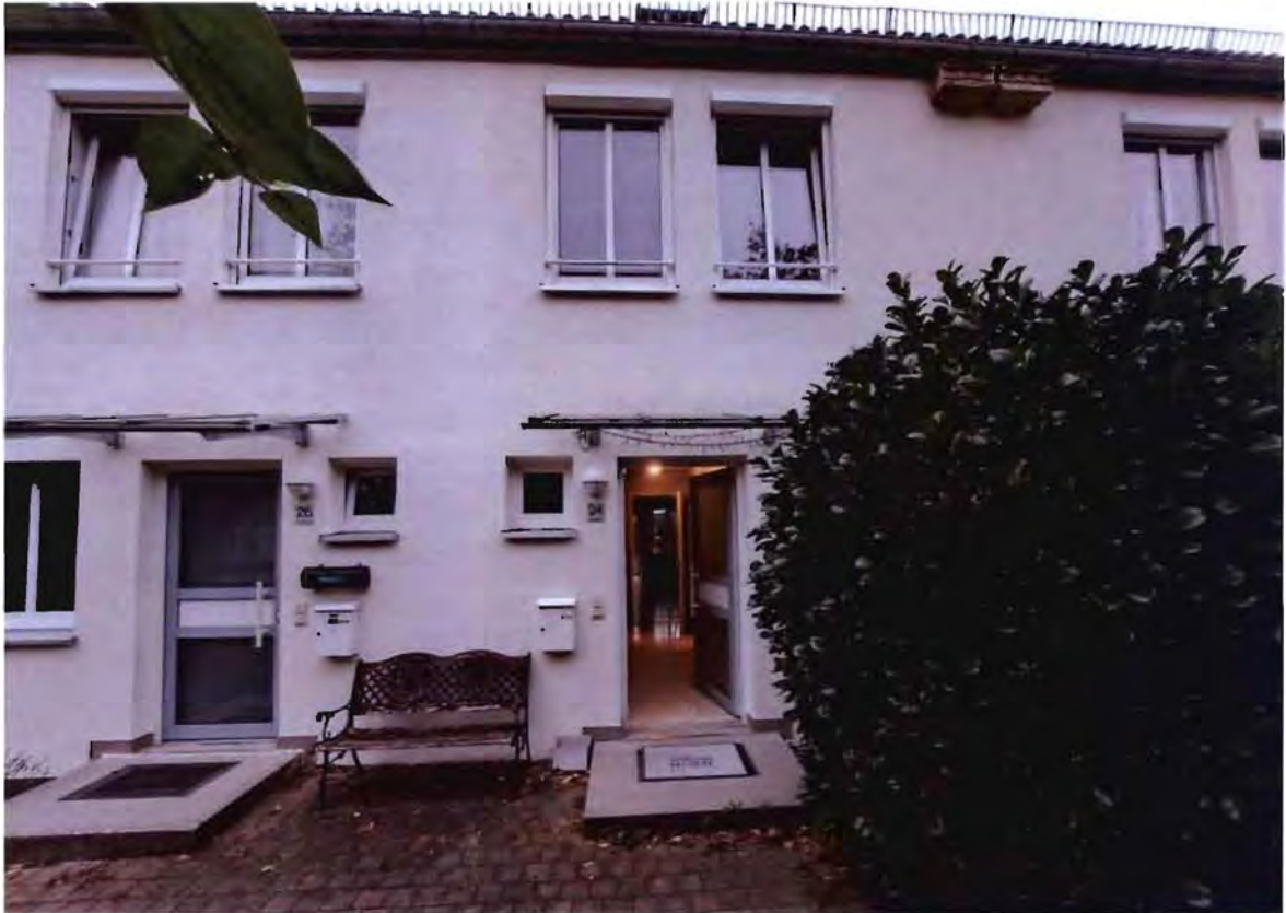
1 Außenansicht Ost, Eingangsbereich
