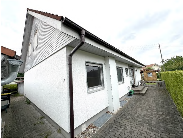
Bild 2 – Blick auf Hauseingang
