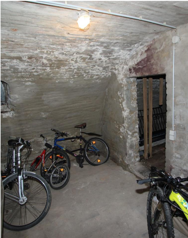
Flur UG mit Durchgang zum Gewölbekeller
