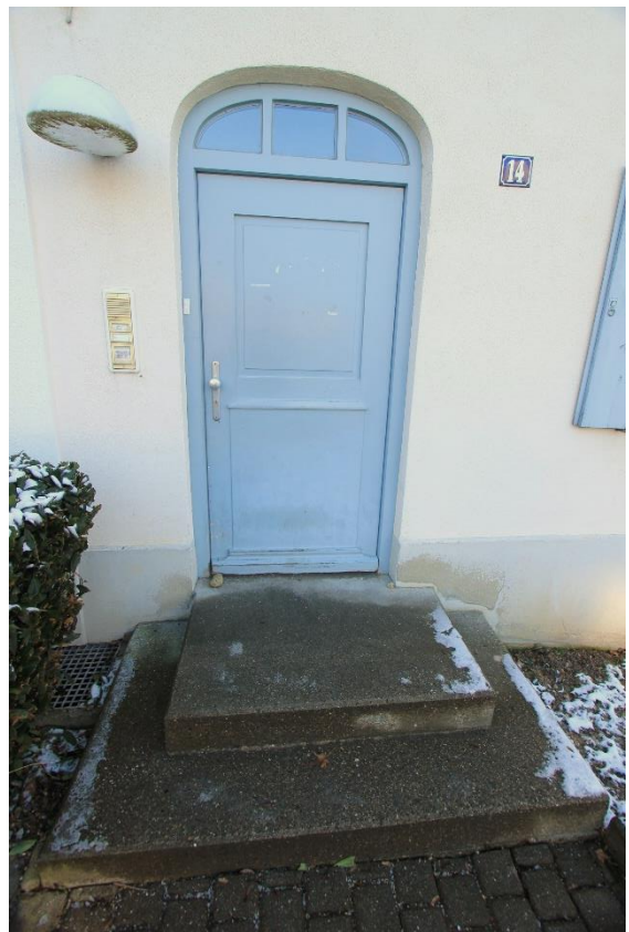
Hauseingang Nordost zu MFH 14
