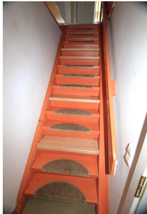
Interner Treppenaufgang im OG zu Whg 9 DG
