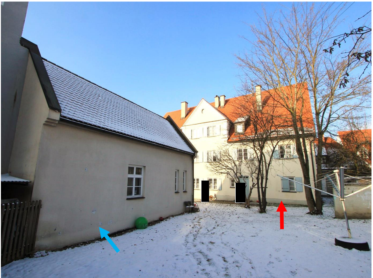
Blick vom südöstlichen Garten nach Norden, links Bürogebäude 1, hinten Mehrfamilienhaus 14
