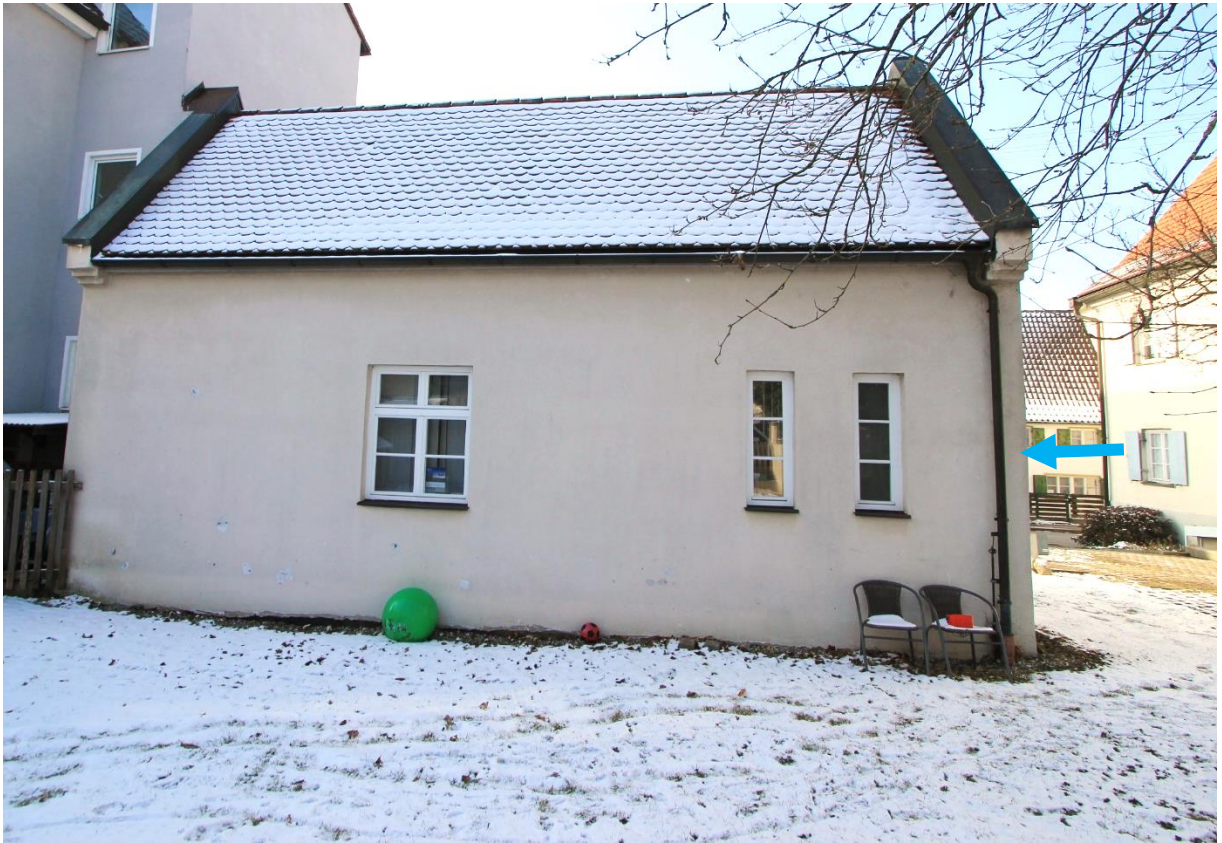
Ostseite Bürogebäude 1 (Hinterseite zum Garten)
