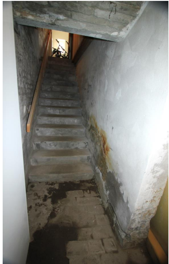
Kellertreppe West von unten
