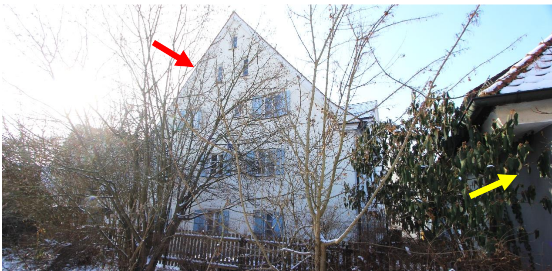
Mehrfamilienhaus 14 von Nordosten, rechts Wohn/Geschäftshaus 1
