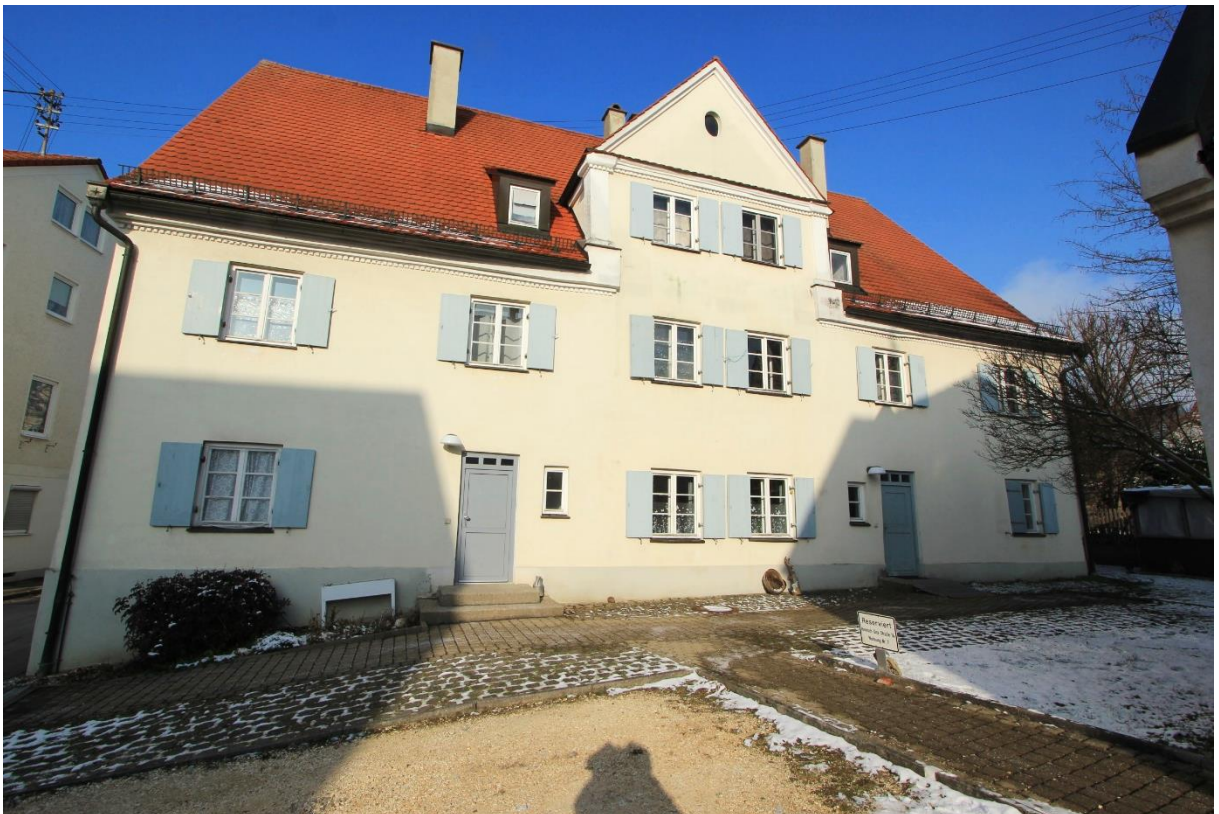
Südseite Mehrfamilienhaus 14 mit 2 Hinterausgängen
