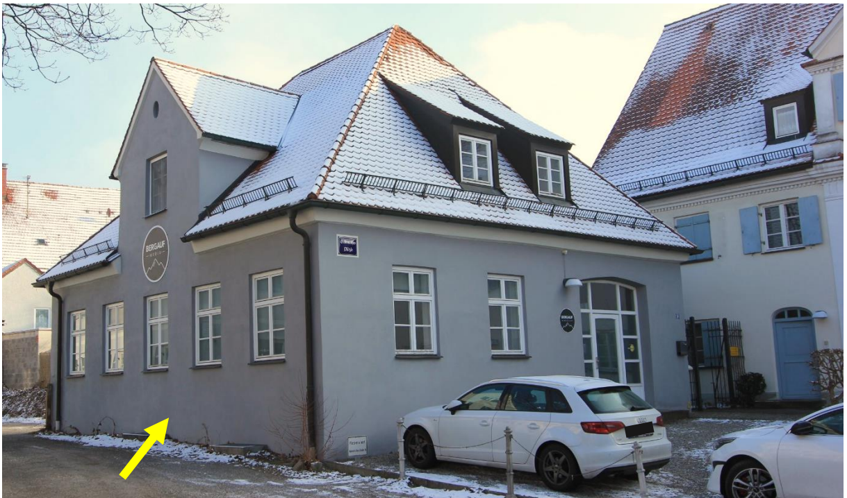
Wohn/Geschäftshaus 16 von Nordwesten, unten Büroeinheit EG, oben Wohnung im DG
