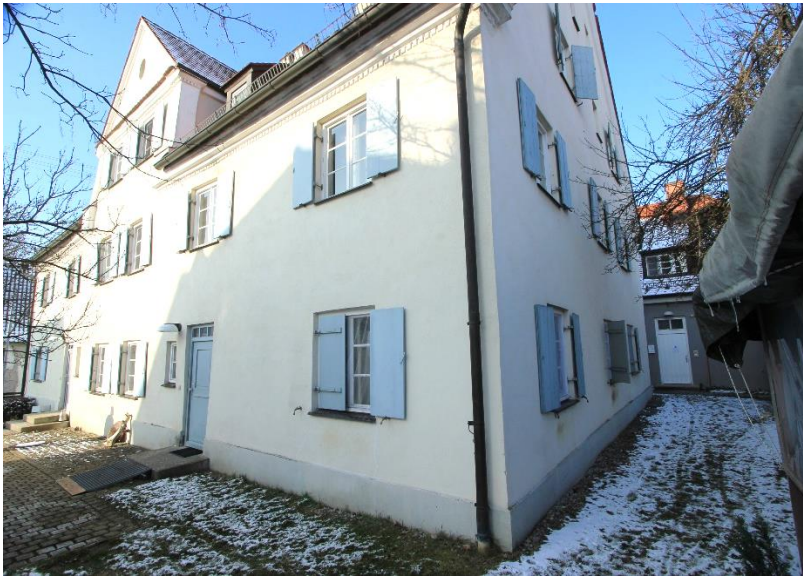
Mehrfamilienhaus 14 von Südosten
