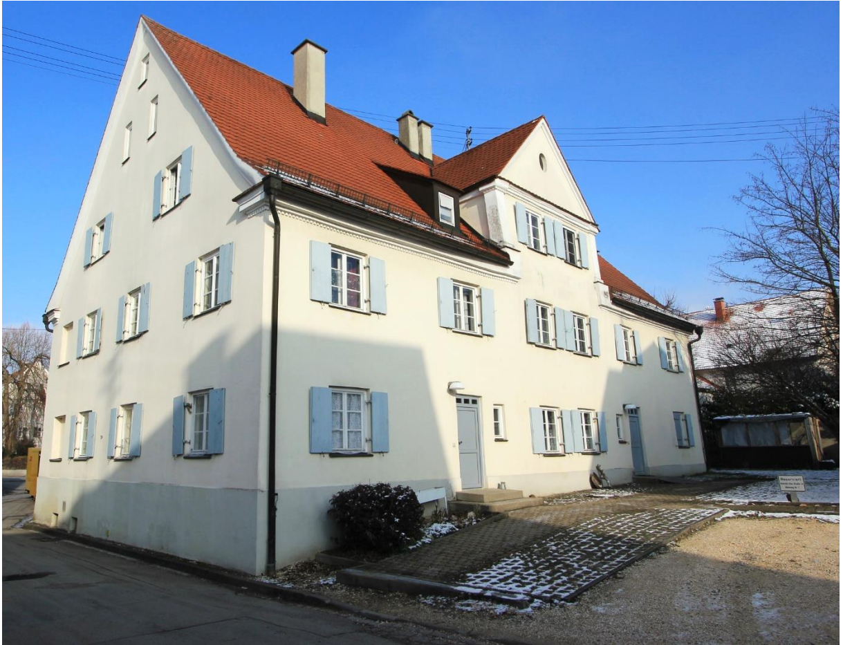
Mehrfamilienhaus 14 mit 2 Hinterausgängen von Südwesten
