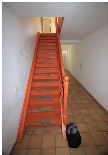
Treppe vom EG zum OG
