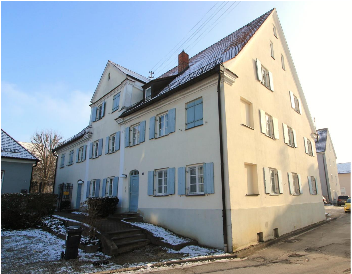
Mehrfamilienhaus 14 mit 2 Hauseingängen von Nordwesten
