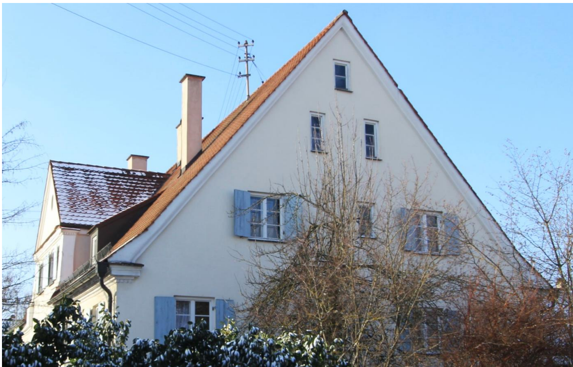
Ostgiebel Mehrfamilienhaus 14, links südlicher Quergiebel
