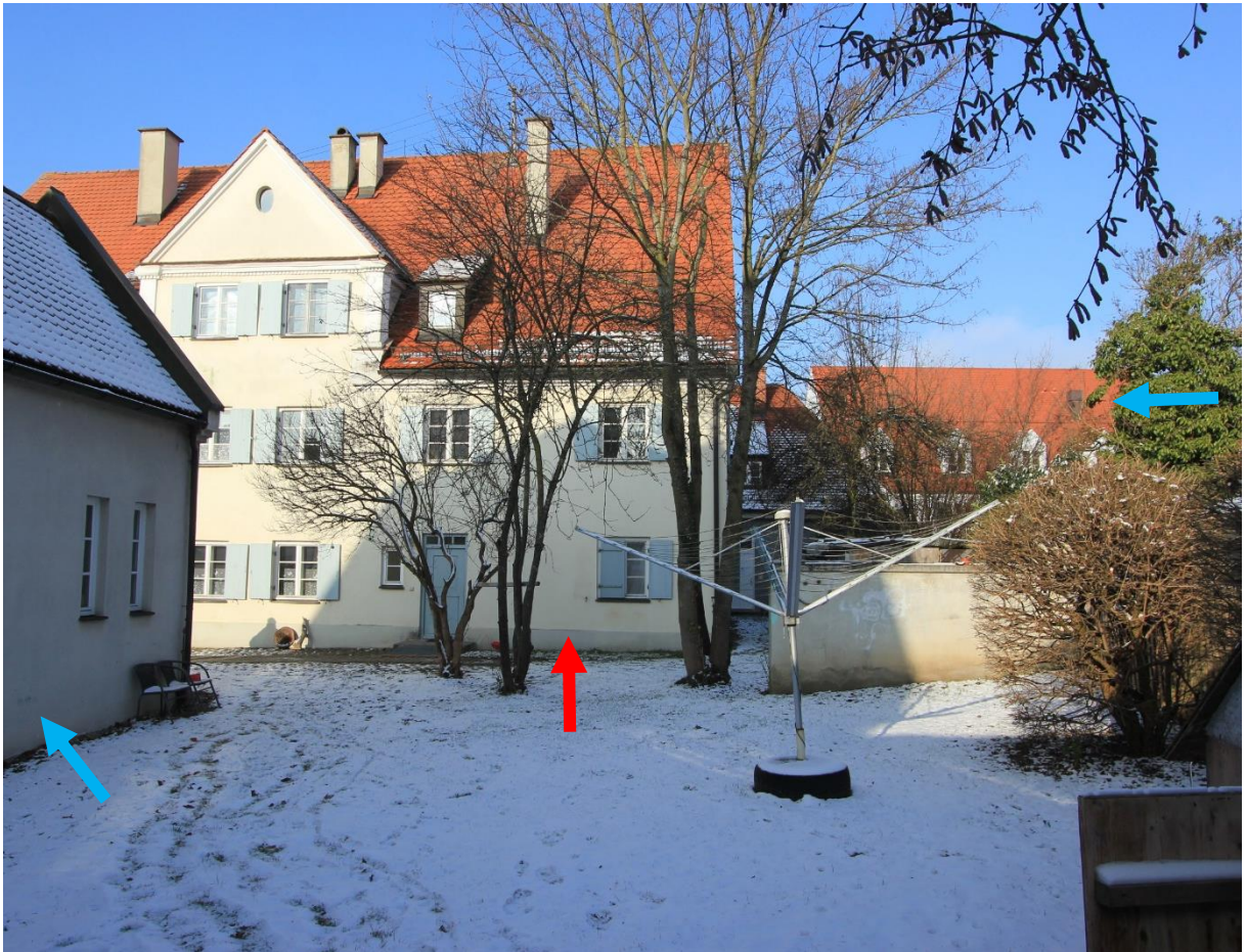
Blick vom südöstlichen Garten nach Norden, links Bürogebäude 1, hinten Mehrfamilienhaus 14
