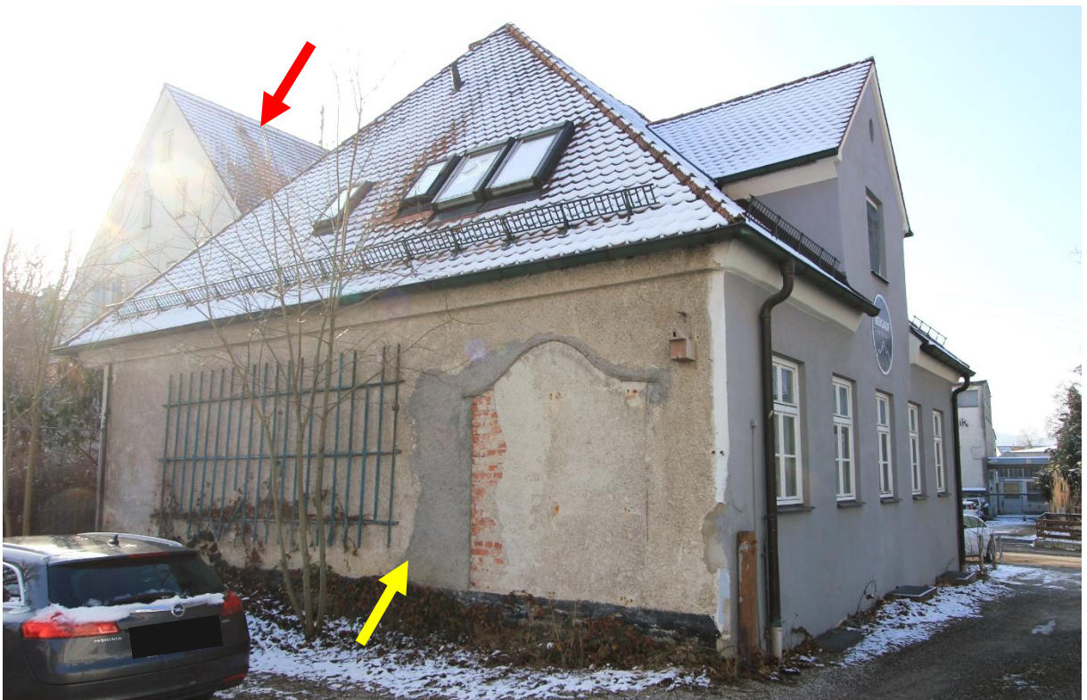
Wohn/Geschäftshaus 16 mit altem Putz von Nordosten, roter Pfeil Mehrfamilienhaus 14
