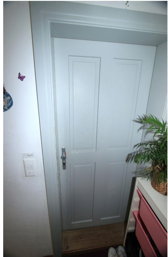
Eingangstür zu Wohnung 7 OG West
