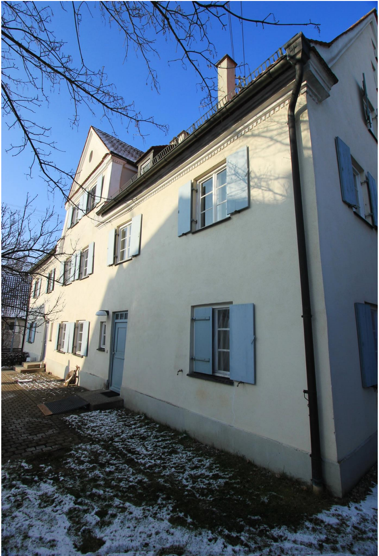
Südseite Mehrfamilienhaus 14 mit Hinterausgängen
