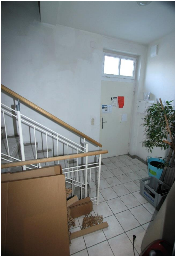
Treppenhaus mit Eingangstür
