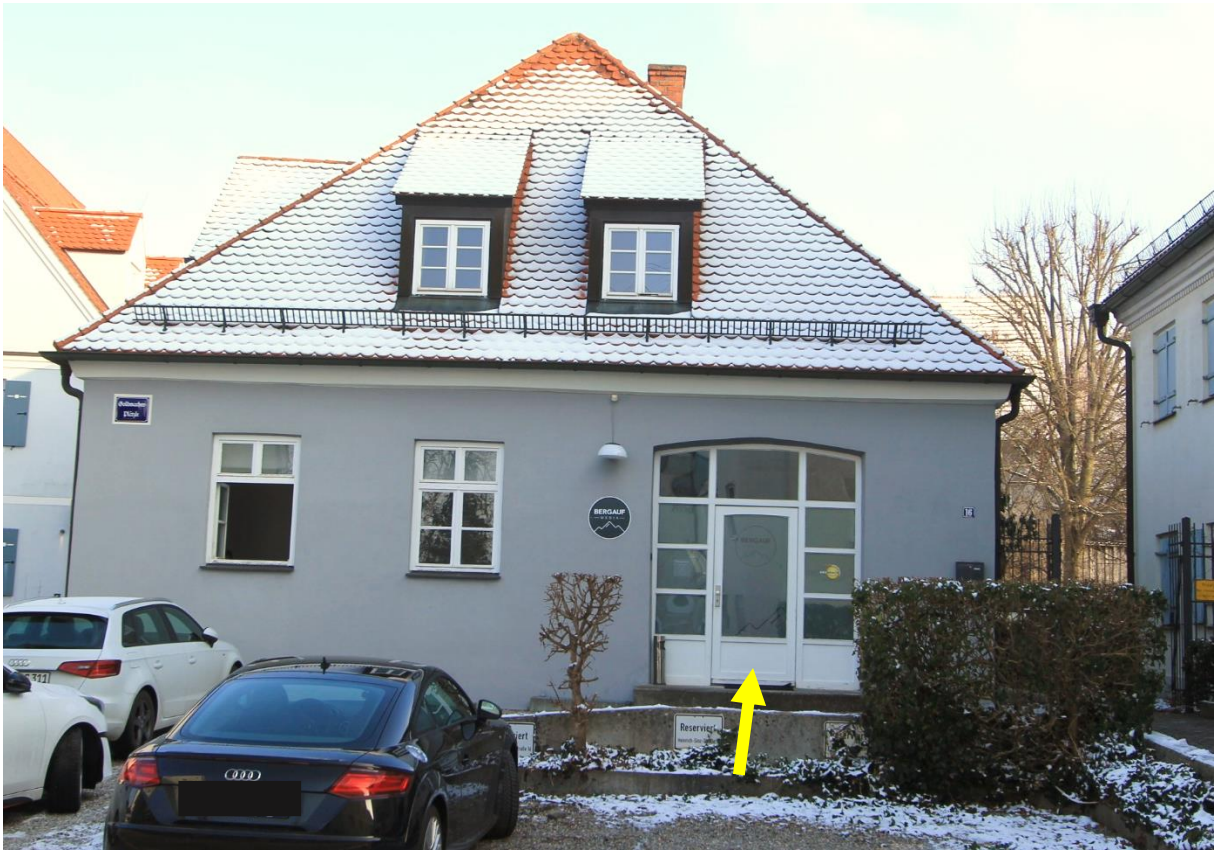
Westseite Wohn/Geschäftshaus 16 mit Eingang zur im Büroeinheit EG, oben Wohnung im DG
