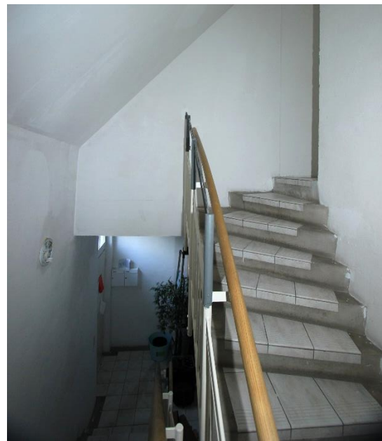
Treppe zum DG
