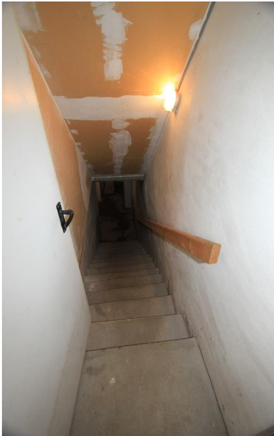
Kellertreppe West von oben
