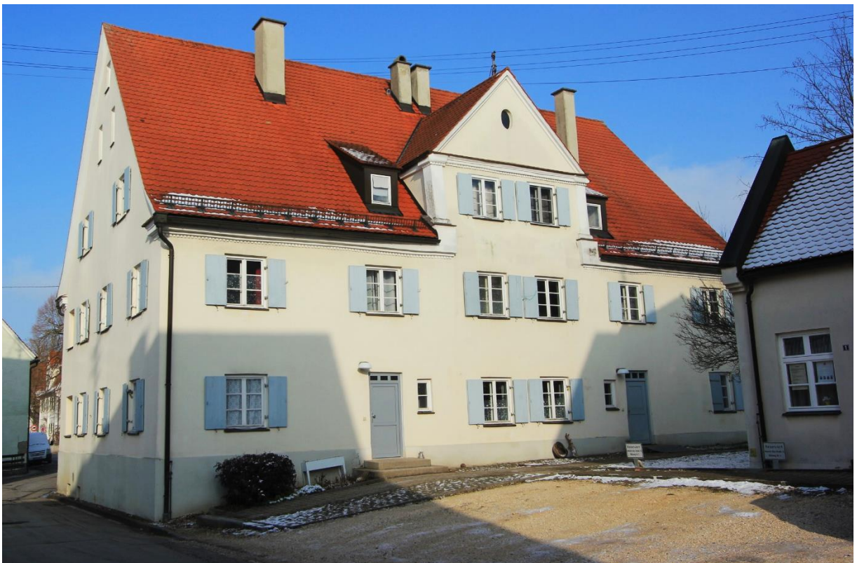
Mehrfamilienhaus 14 mit 2 Hinterausgängen von Südwesten, rechts Bürogebäude 1
