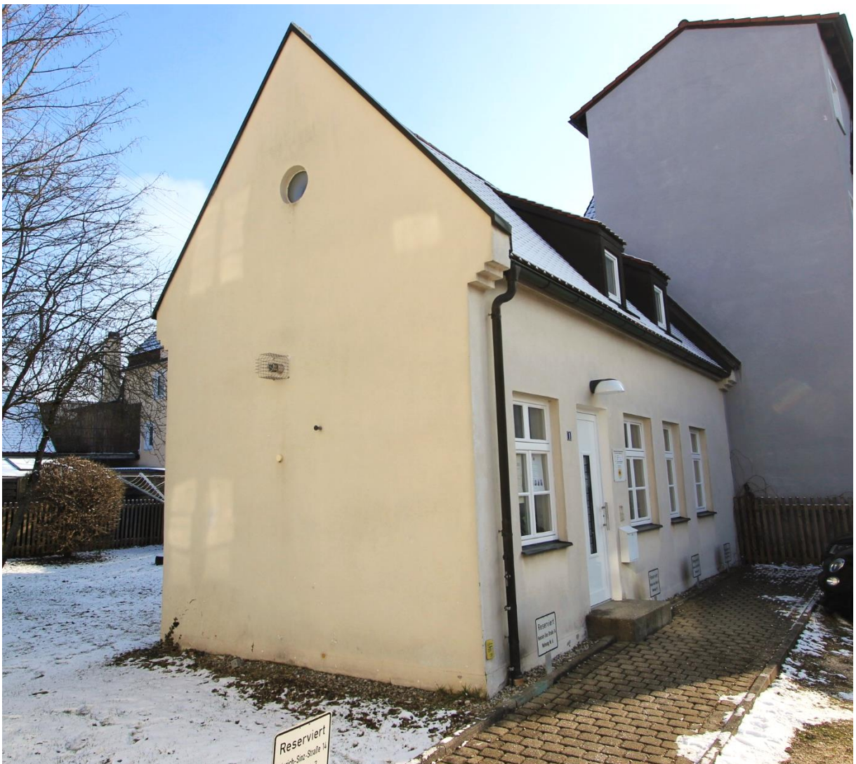
Bürogebäude 1 von Nordwesten mit Hauszugang
