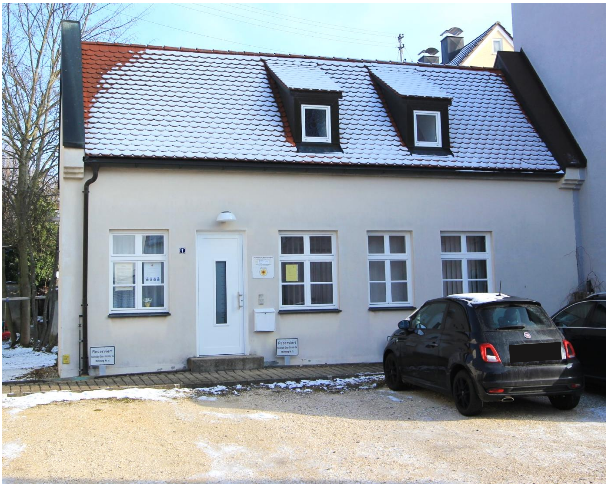
Westseite Bürogebäude 1 mit Zugang
