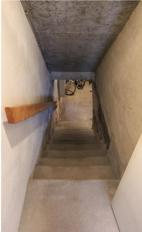
Kellertreppe Ost von oben
