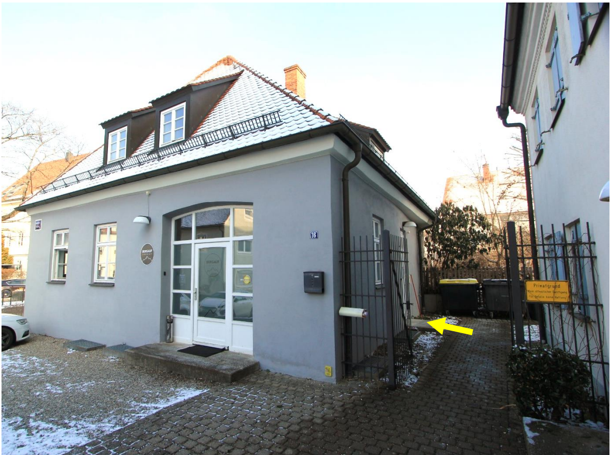
Wohn/Geschäftshaus 16 von Südwesten, rechts Hauseingang zur Wohnung im DG
