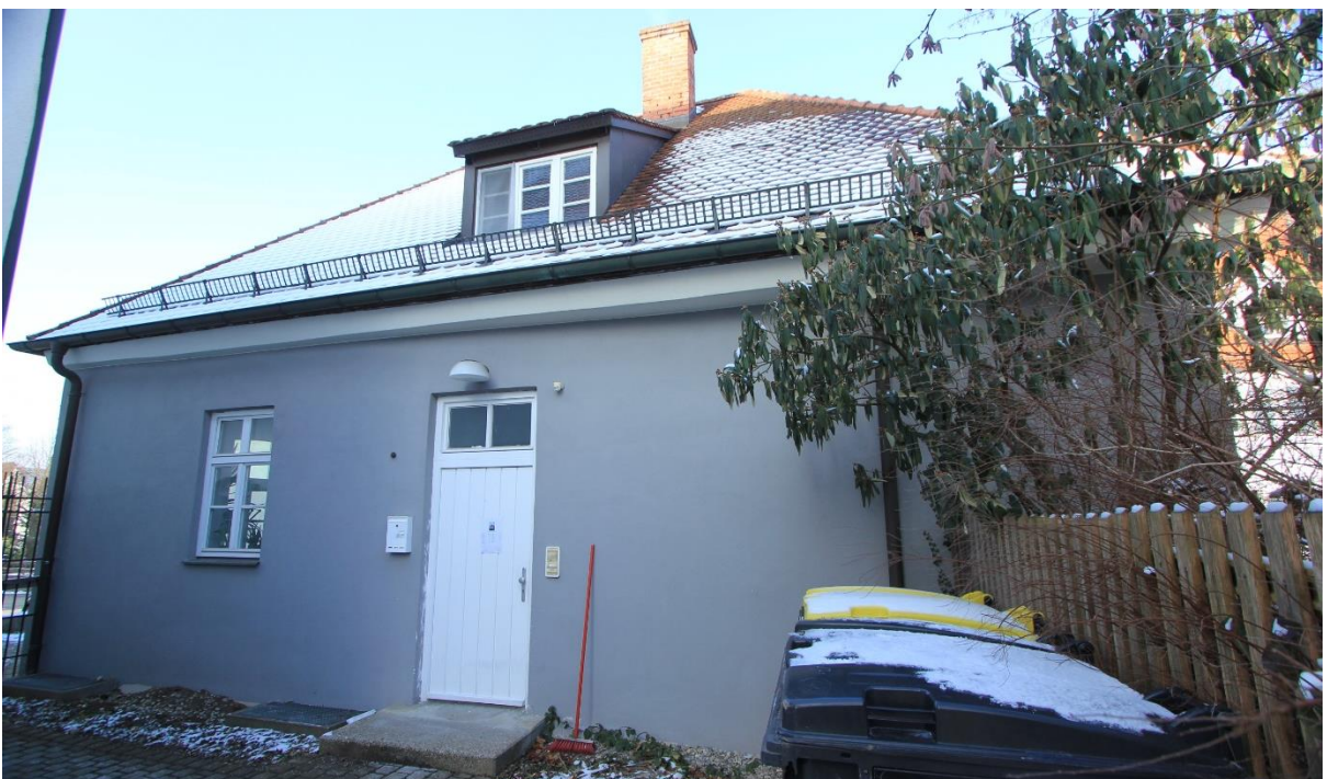
Südseite Wohn/Geschäftshaus 1 mit Haustür zum Treppenhaus
