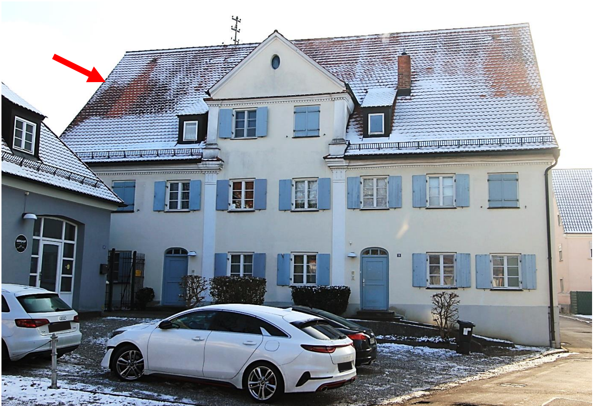
Nordseite Mehrfamilienhaus 14 mit 2 Hauseingängen, links Nr. 16, davor Parkplatz
