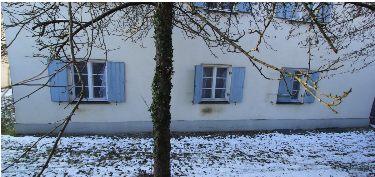
Ostseite EG Mehrfamilienhaus 14
