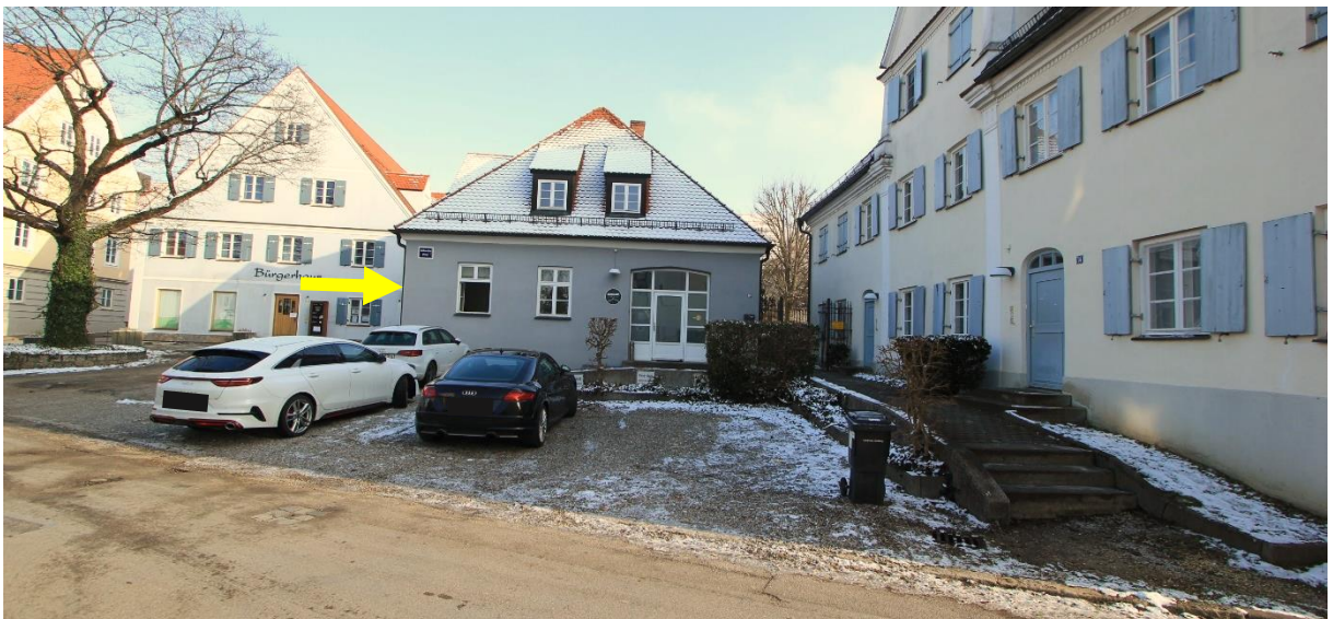
Parkplatz vor Wohn/Geschäftshaus 16 (Pfeil) von Westen, rechts MFH 14
