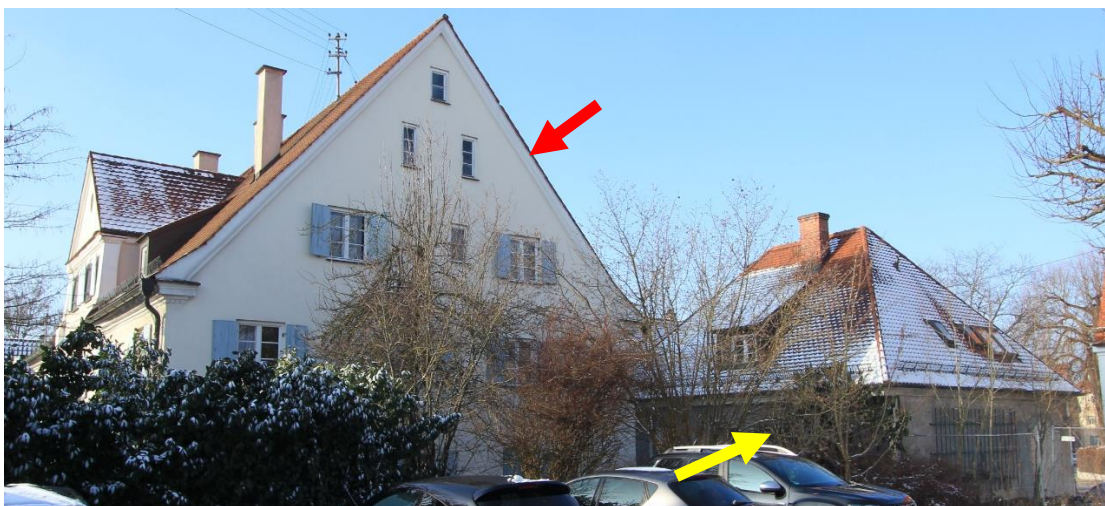
Mehrfamilienhaus 14 (rot) und Wohn/Geschäftshaus 1 (gelb) von Südosten
