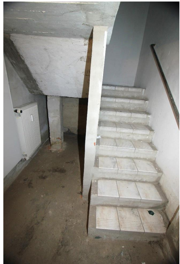
Kellertreppe mit Fliesenbelag
