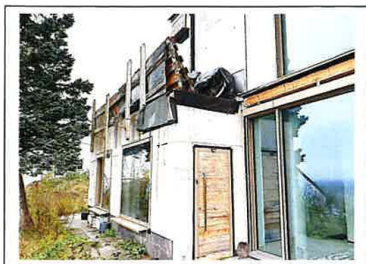
Foto 7: Wohnhaus Südost UG
