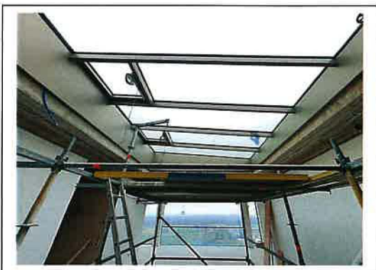
Foto 21: Nicht ausgebaute Räume
