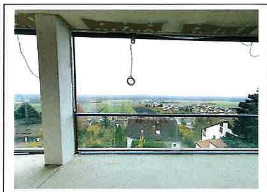
Foto 24: nicht ausgebaute Räume
