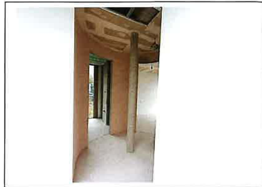
Foto 20: nicht ausgebaute Räume
