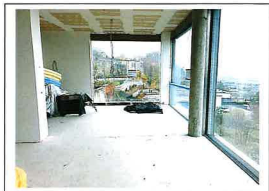
Foto 18: nicht ausgebaute Räume
