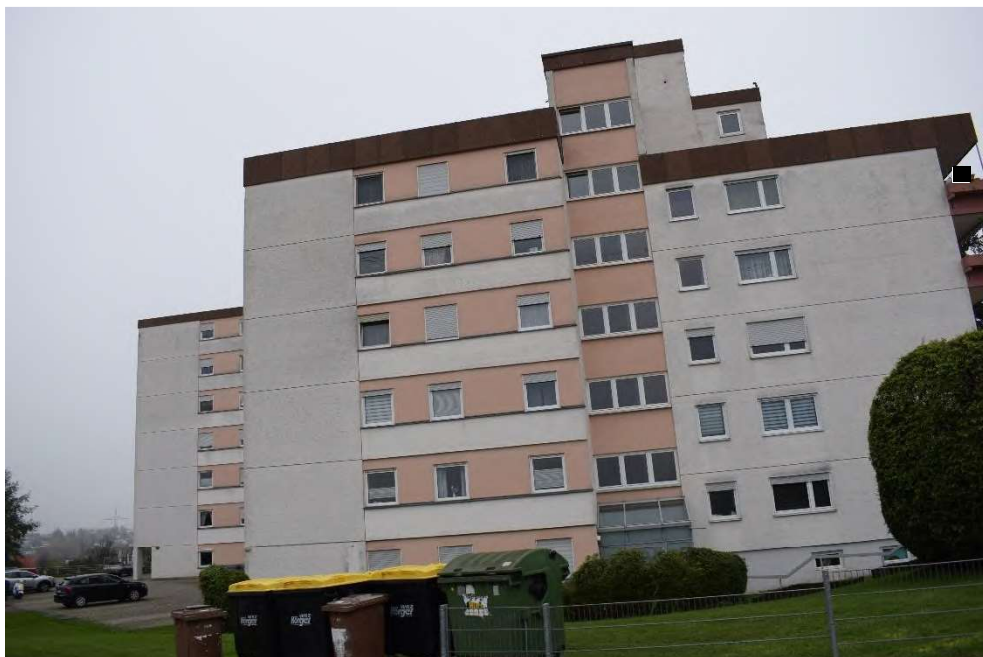
Innenansicht: Mehrfamilienhaus von Südosten
