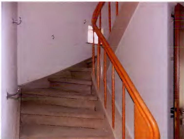
EG: Treppe ins OG
