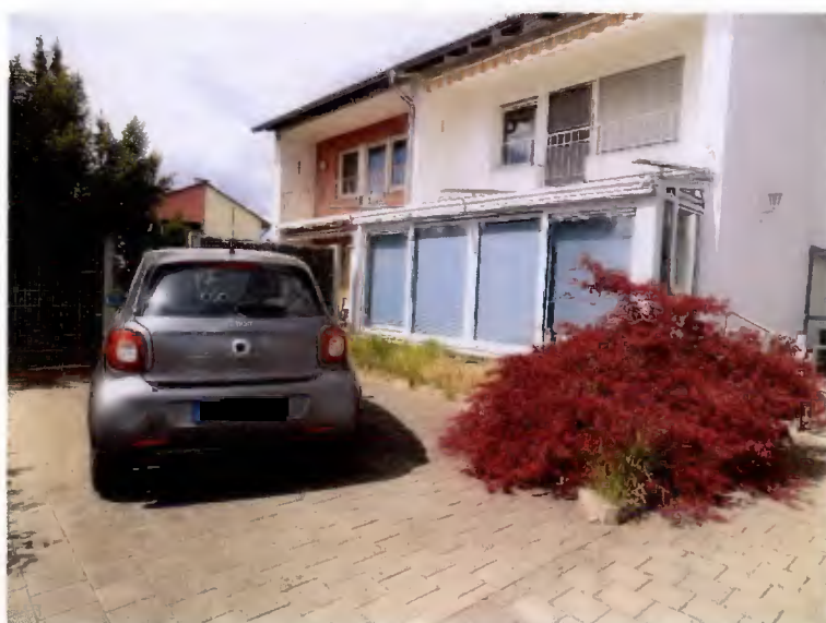
Ansicht von Südosten, Vorgarten als Parkplatz befestigt
