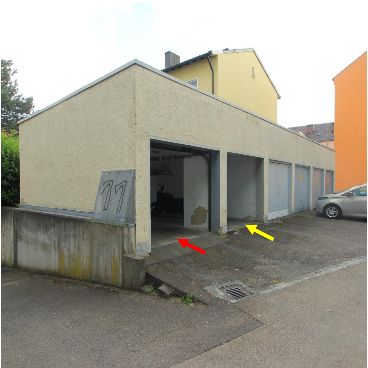
Reihengaragen von Norden, roter Pfeil Garage ATP Nr. 6, gelber Pfeil Garage ATP Nr. 5
