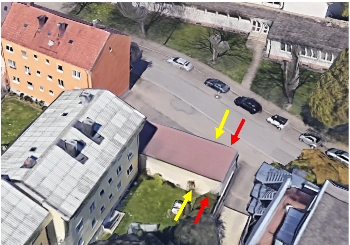
Blick von Südosten, rote Pfeile Garage ATP Nr. 6, gelbe Pfeile Garage ATP Nr. 5
