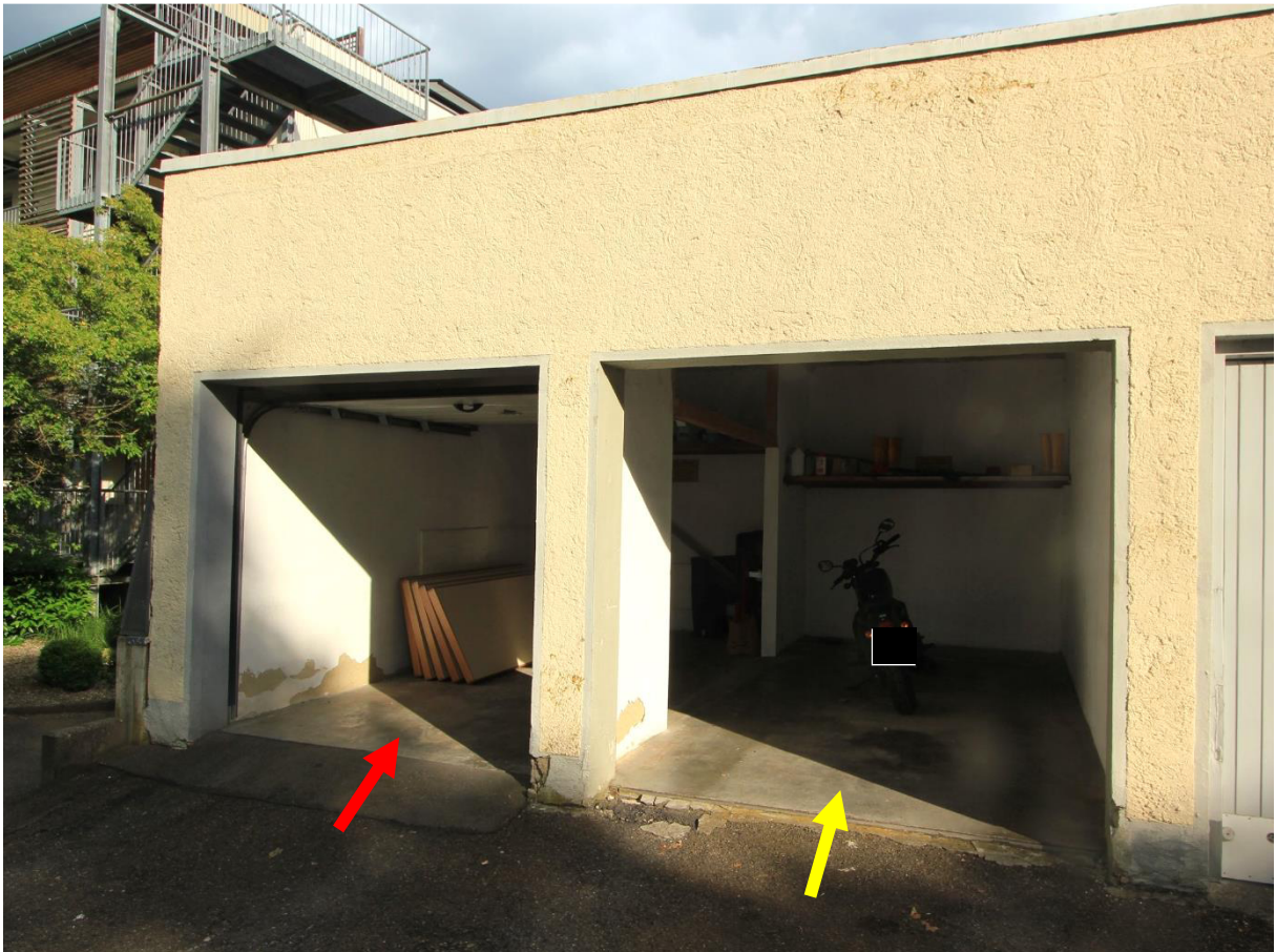
Links Garage ATP Nr. 6 mit Sektionaltor, rechts Garage ATP Nr. 5 ohne Garagentor
