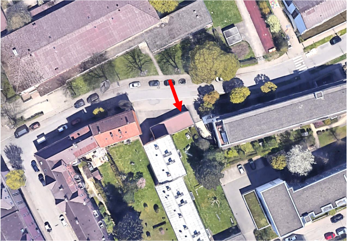
Garagengrundstück von oben, Pfeil Garage ATP Nr. 6
