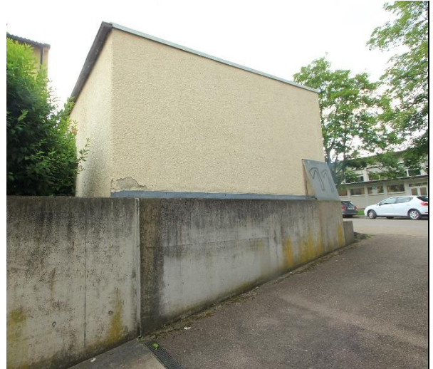
Nordostseite Garagen (Nr. G6)
