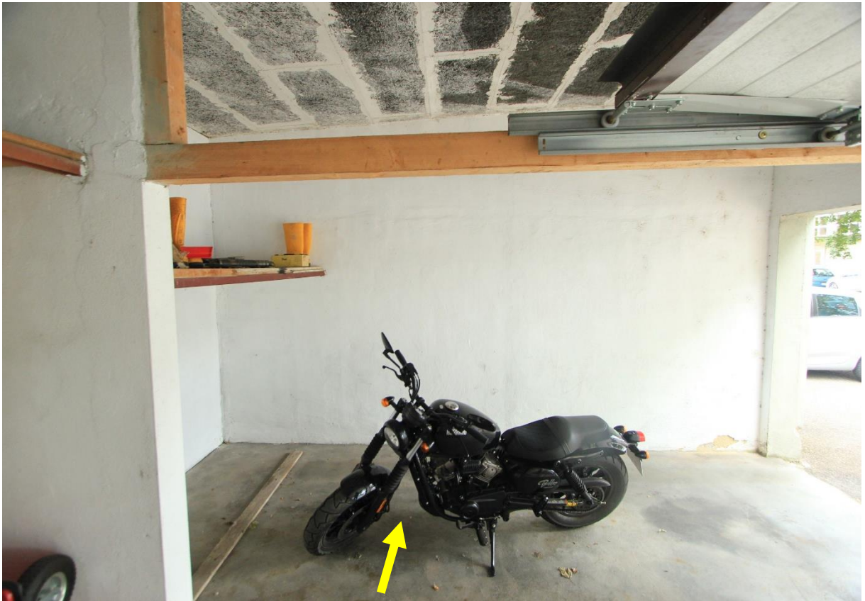
Blick in Garage ATP Nr. 5 ohne Garagentor und ohne Zwischenwand, oben unverputzte Decke
