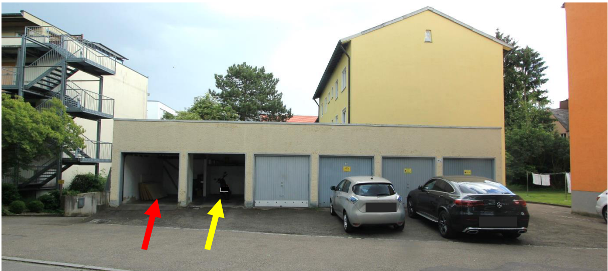
Nordwestseite Reihengaragen, roter Pfeil Garage ATP Nr. 6, gelber Pfeil Garage ATP Nr. 5
