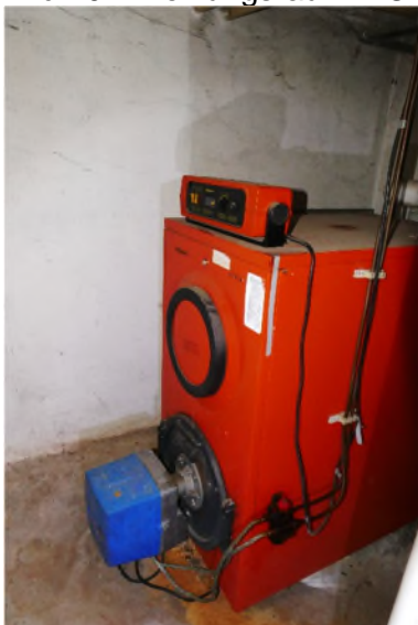
Bild 10 – Heizungsraum – Ölkessel
