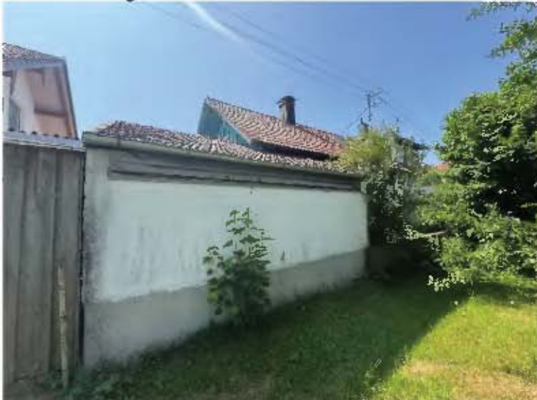
Bild 3 – Garage von Norden
