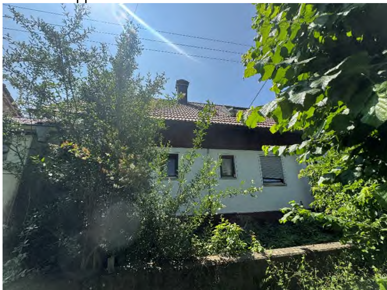
Bild 5 – Doppelhaushälfte von Norden
