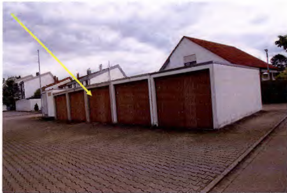
Außenansicht: Garagrundstück Flurstück Nr. 185/15
