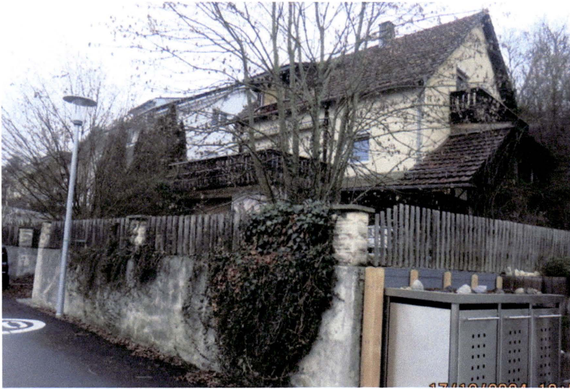
Foto 3: Südostansicht mit Stützmauer
