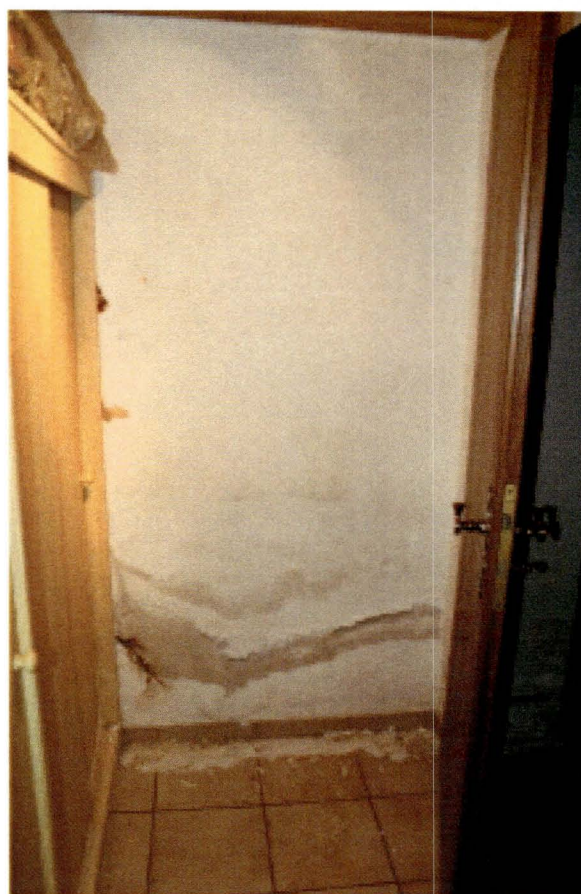
Bild 45: Garage: KG: Vorraum mit Feuchte- und Haus- schwammschäden
