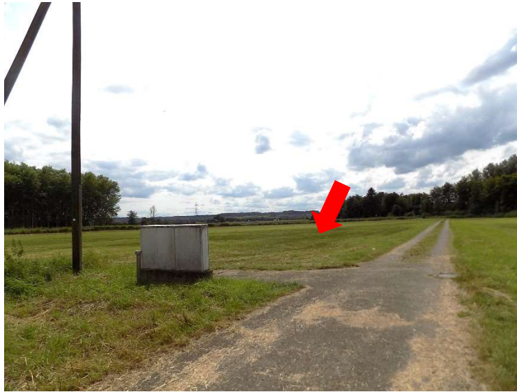
Pfeil: Flst. Nr. 762, Blickrichtung Westen, im Vordergrund: Trafostation auf dem Grundstück
