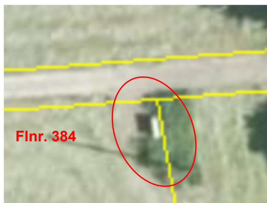
Luftbild mit Flurstücksgrenzen. Pfeil: Trafostation
