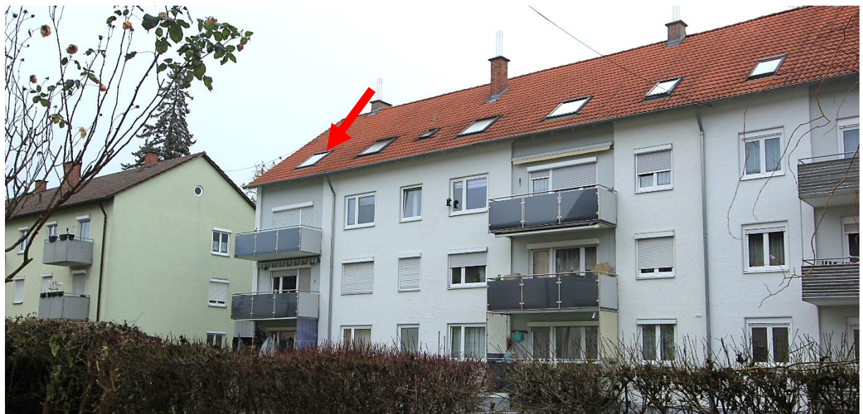
Mehrfamilienhaus Harderstraße 21 von Südwesten, Pfeil Wohnung ATP Nr. 12 im DG
