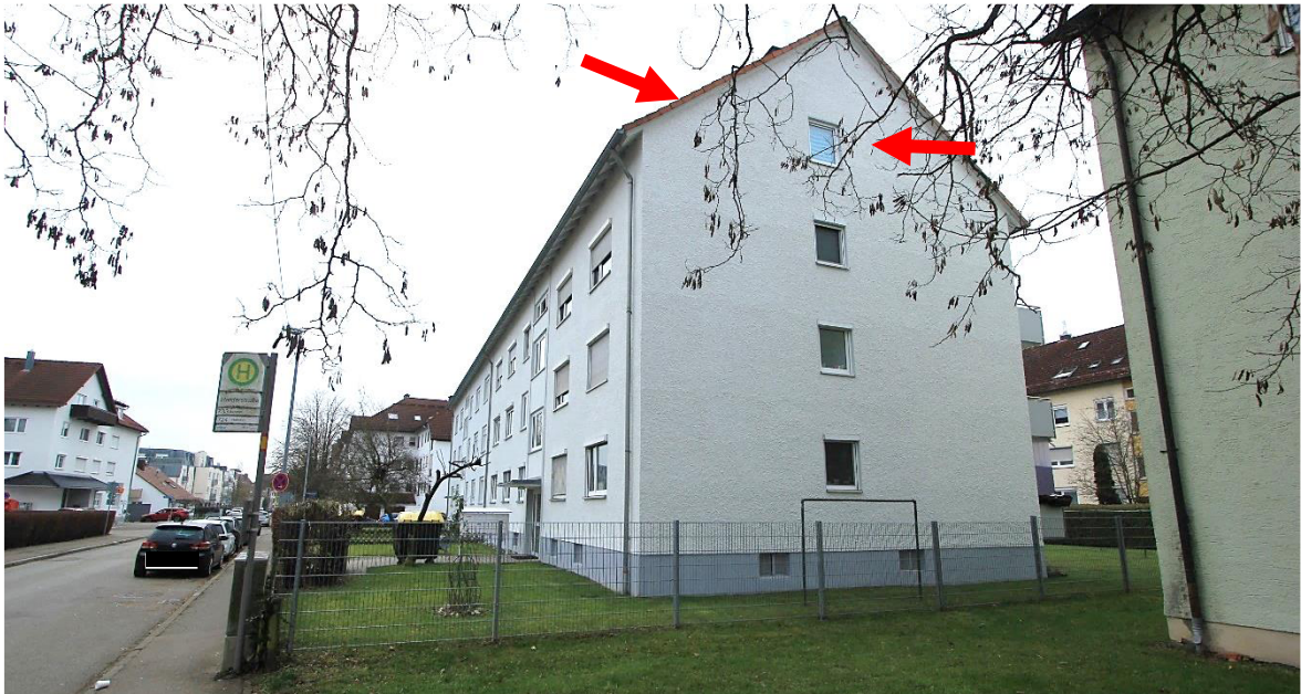
Mehrfamilienhäuser Harderstraße 19 + 21 von Norden, Pfeile Wohnung ATP Nr. 12 im DG
