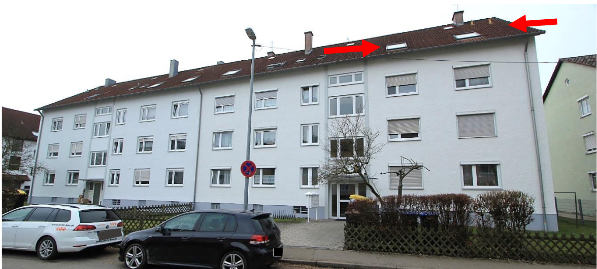
Nordostseite MFH 21, Pfeile Wohnung Nr. 12 im DG, links angebaut Nachbarhaus 19
