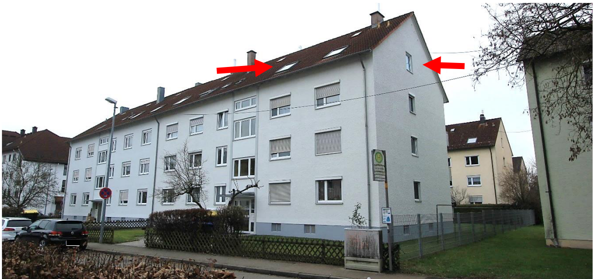
Mehrfamilienhäuser Harderstraße 19 + 21 von Nordosten, Pfeile Wohnung ATP Nr. 12 im DG
