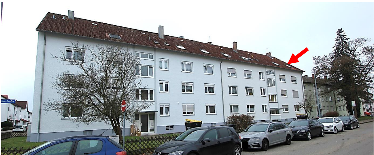
Mehrfamilienhaus Harderstraße 19 + 21 von Osten, Pfeile Wohnung ATP Nr. 12 im DG
