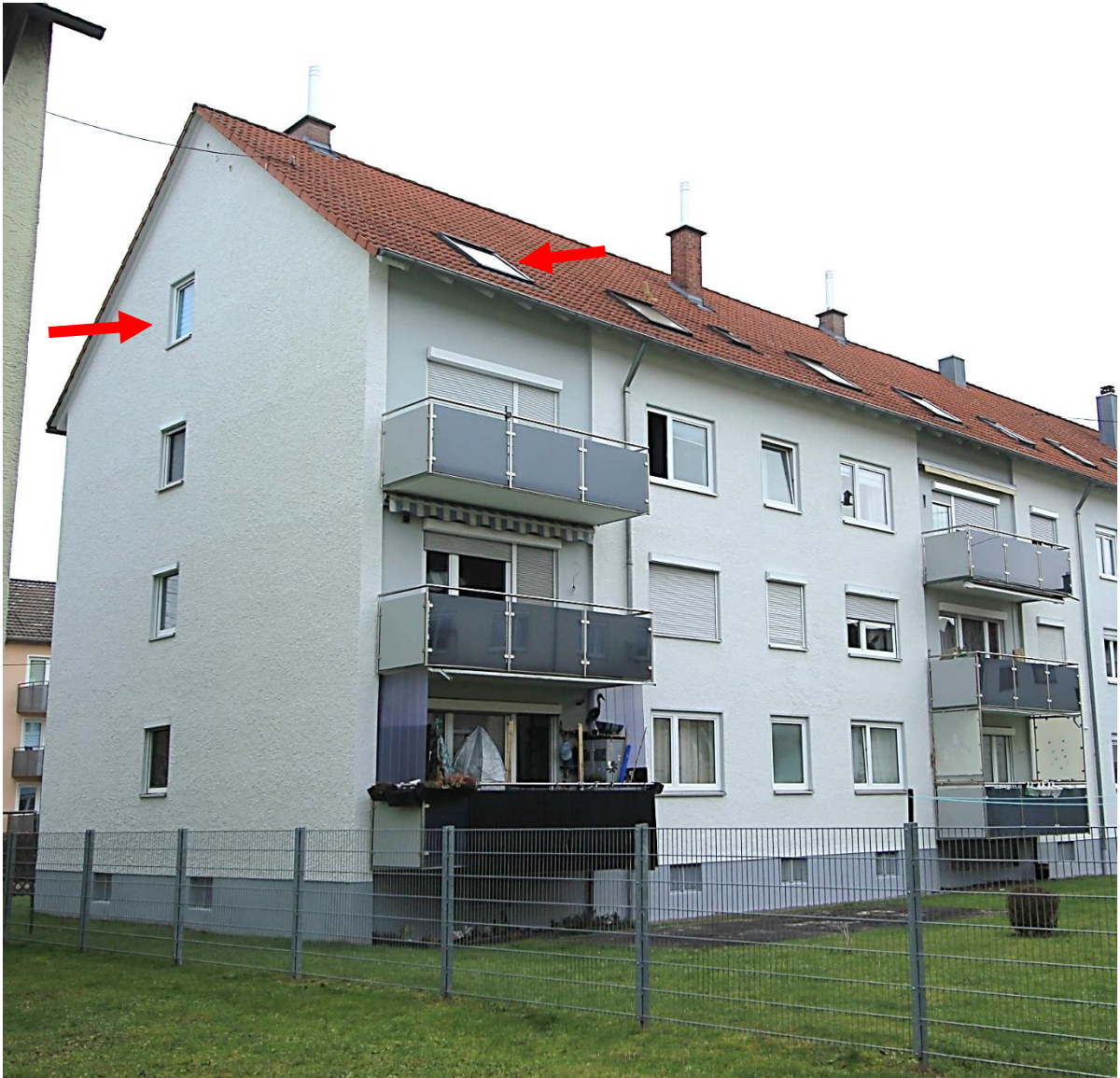
Mehrfamilienhaus Harderstraße 21 von Westen, Pfeile Wohnung ATP Nr. 12 im DG
