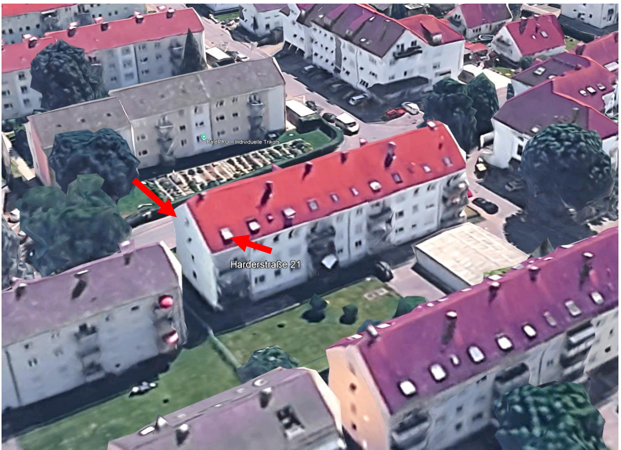
Eigentumsanlage von Westen, Pfeile Wohnung ATP Nr. 12 im DG
