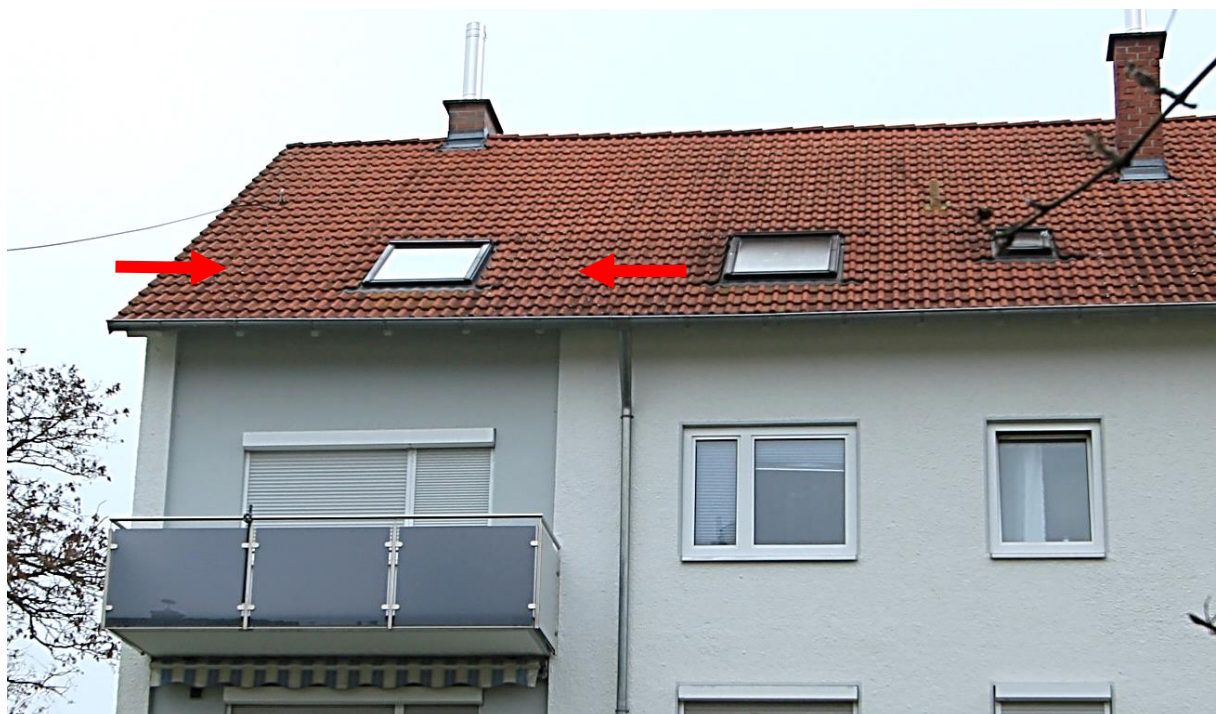
Dach Harderstraße 21 von Südwesten, Pfeile Wohnzimmer mit Dachfenster Nr. 12
