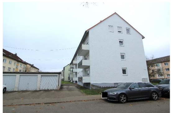
Nachbarhaus Harderstraße 19 von Süden
