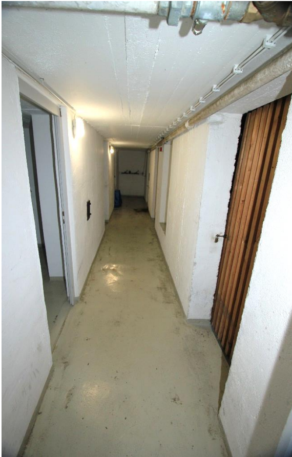
Flur im UG zu den Kellerräumen
