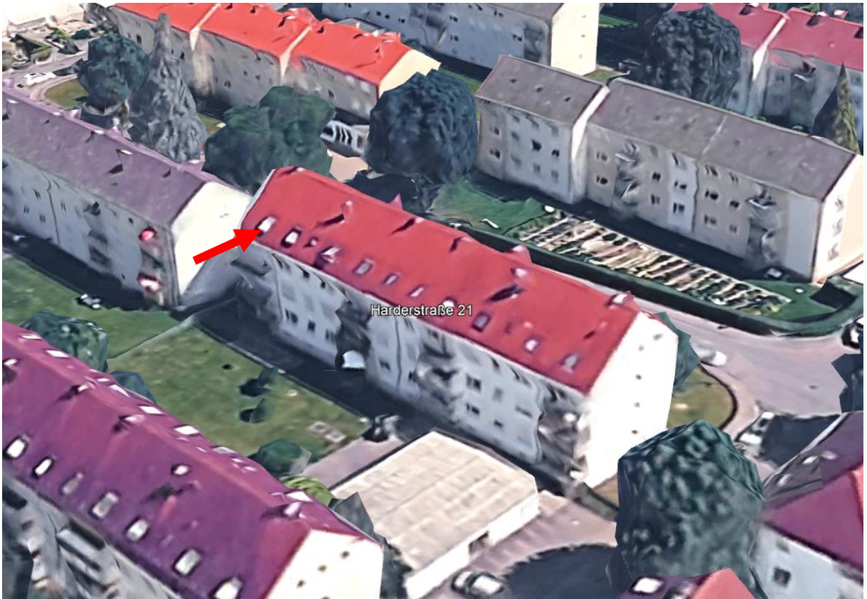
Eigentumsanlage Harderstr. 21 von Süden, Pfeil Wohnung ATP Nr. 12
