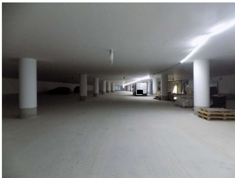
Tiefgarage im Bau: 2. Untergeschoss
