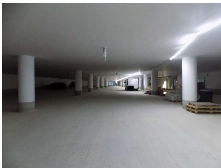
Tiefgarage im Bau: 2. Untergeschoss
