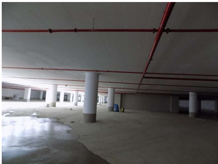
Tiefgarage im Bau: 3. Untergeschoss
