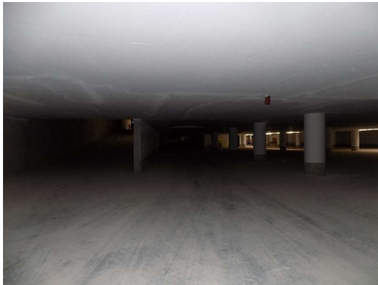
Tiefgarage im Bau: 2. Untergeschoss
