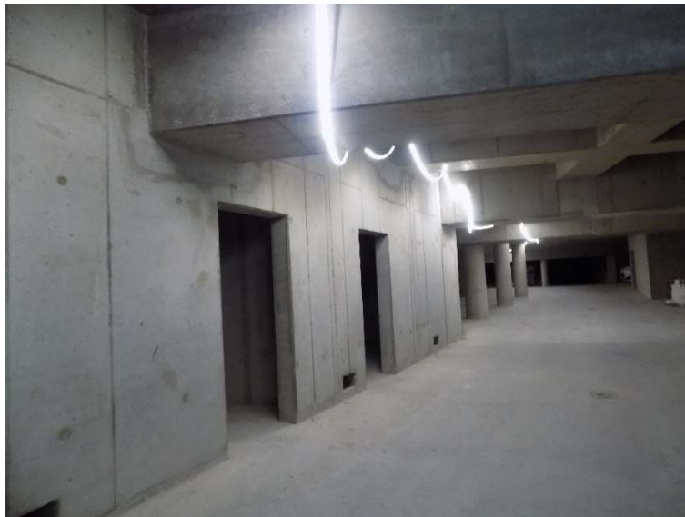
Tiefgarage im Bau: 2. Untergeschoss
