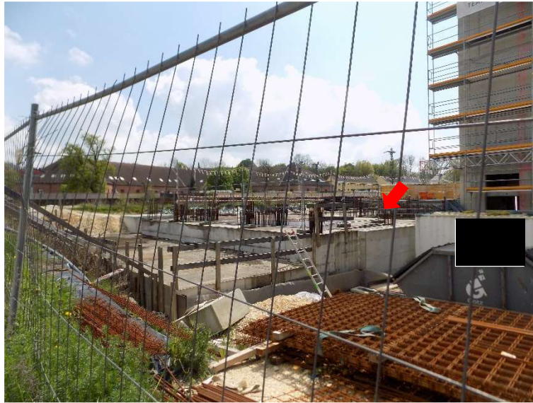
Pfeil: Bürohausgrundstück Flnr. 245/334 von Nordosten, Bau derzeit eingestellt
