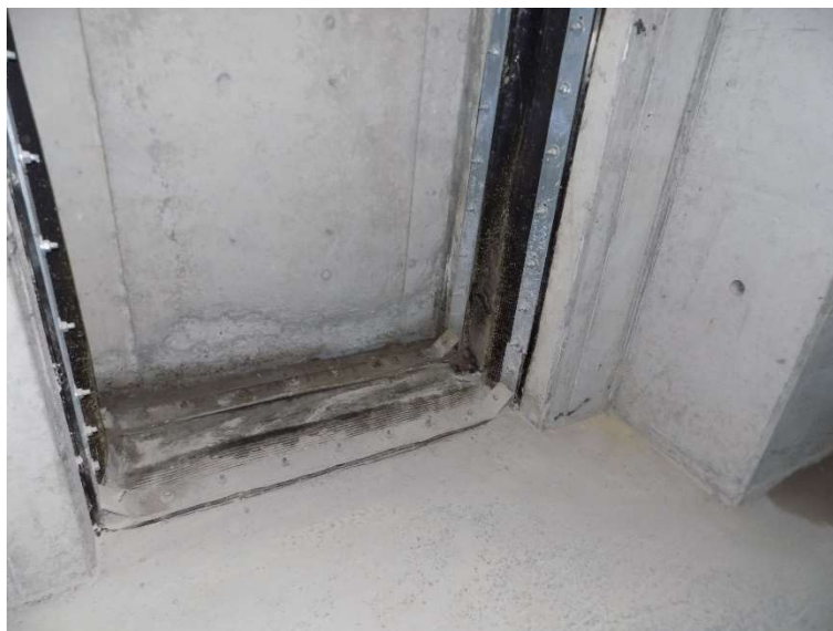
Bürohausgrundstück Flnr. 245/334, 2. Untergeschoss Bauwerksfuge zur anschließenden Tiefgarage
