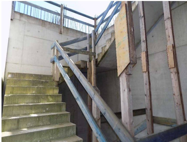
Bürohausgrundstück Flnr. 245/334, Pfeil: Treppenhaus
