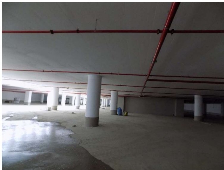
Tiefgarage im Bau: 3. Untergeschoss
