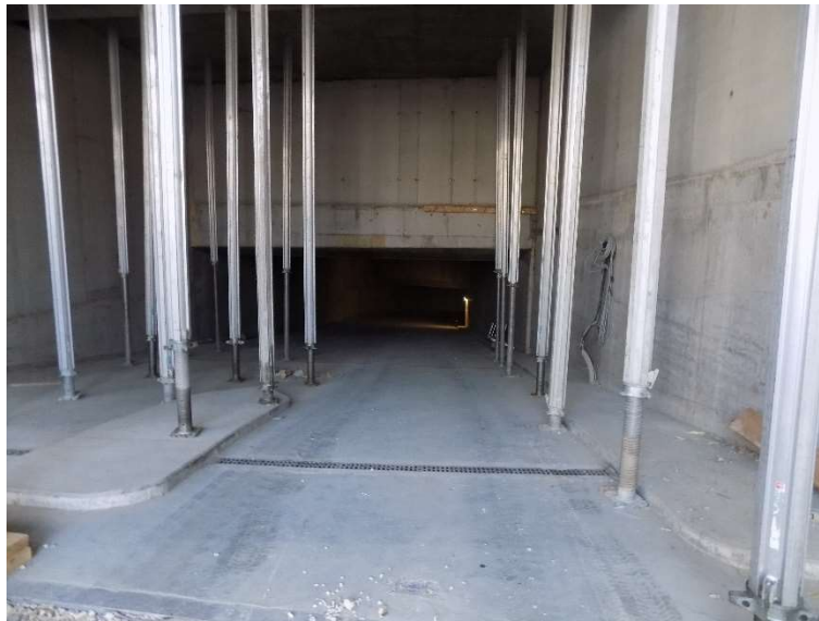
Tiefgarage im Bau: Tiefgarageneinfahrt
