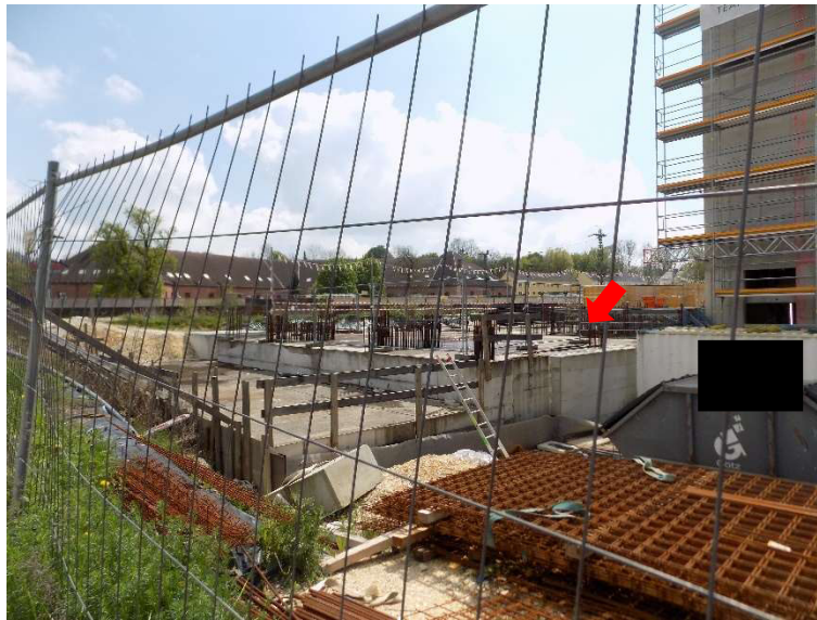
Pfeil: Bürohausgrundstück Flnr. 245/334 von Nordosten, Bau derzeit eingestellt
