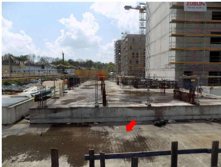
Pfeil: Bürohausgrundstück Flnr. 245/334 von Osten im Hintergrund: Wohnanlage mit Tiefgarage im Bau befindlich
