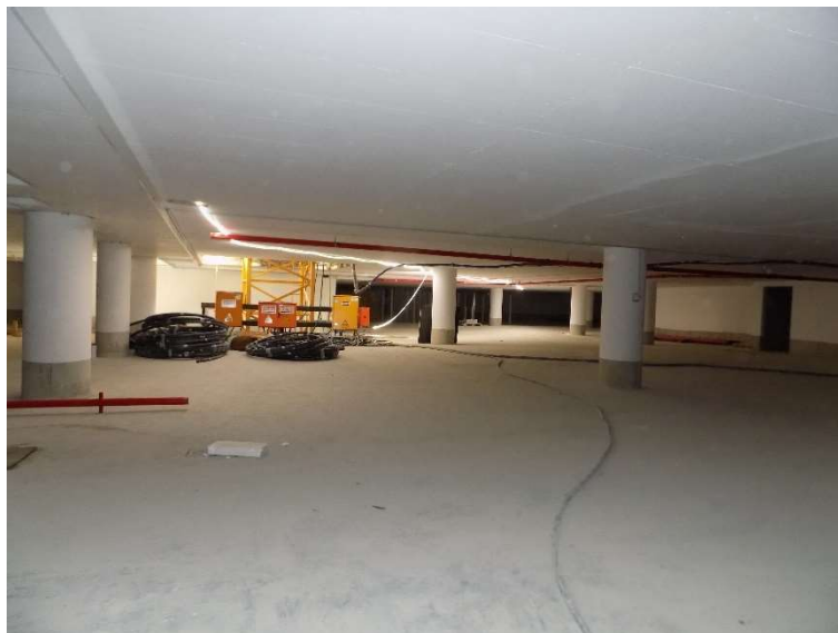
Tiefgarage im Bau: 3. Untergeschoss
