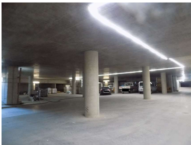
Tiefgarage im Bau: 2. Untergeschoss
