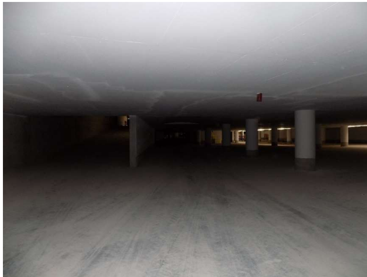
Tiefgarage im Bau: 2. Untergeschoss
