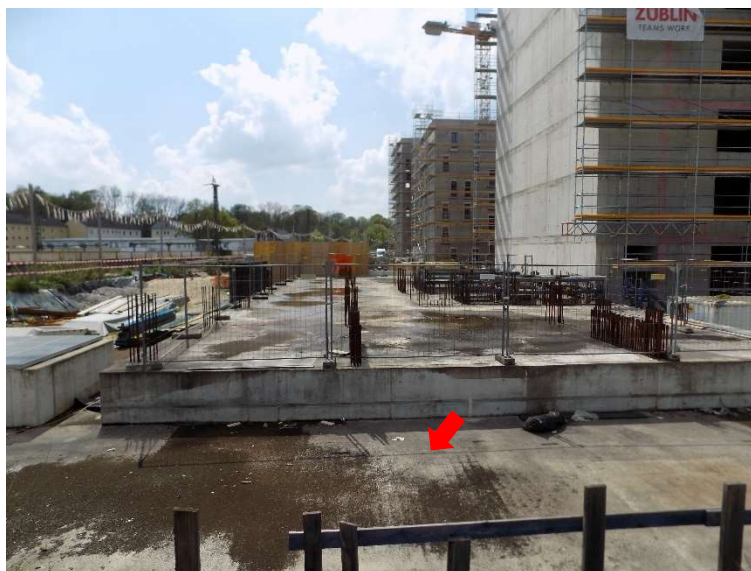
Pfeil: Bürohausgrundstück Flnr. 245/334 von Osten im Hintergrund: Wohnanlage mit Tiefgarage im Bau befindlich
