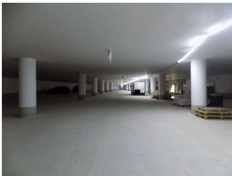
Tiefgarage im Bau: 2. Untergeschoss
