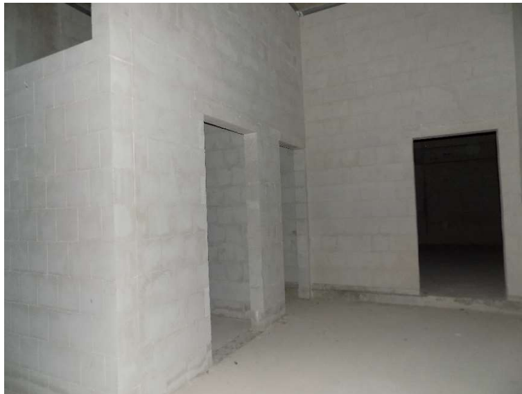
Bürohausgrundstück Flnr. 245/334, 1. Untergeschoss
