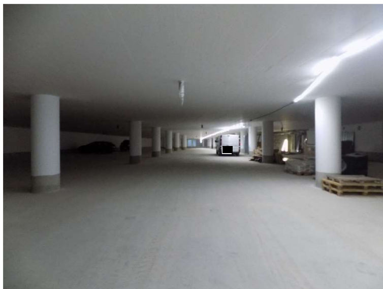
Tiefgarage im Bau: 2. Untergeschoss
