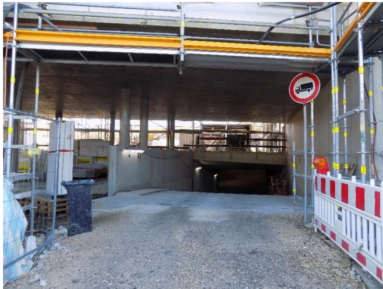
Tiefgarage im Bau: Tiefgarageneinfahrt
