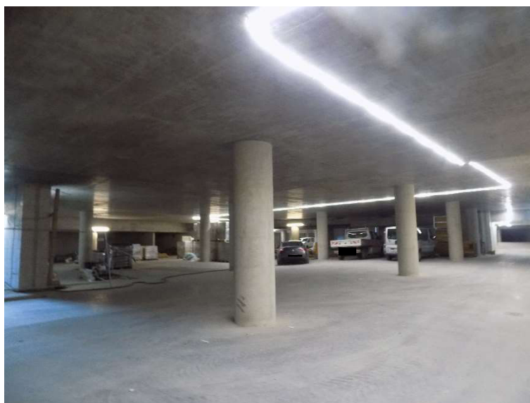
Tiefgarage im Bau: 2. Untergeschoss
