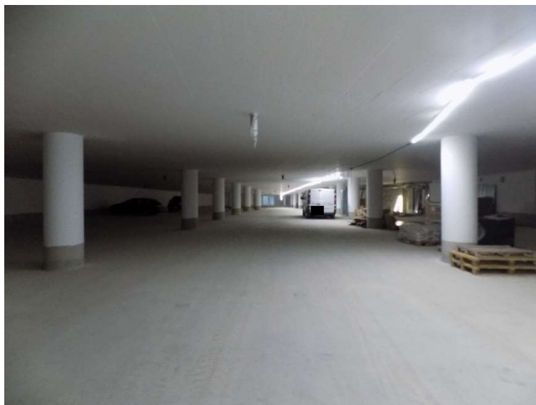
Tiefgarage im Bau: 2. Untergeschoss
