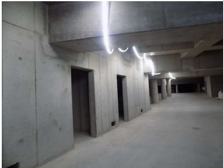
Tiefgarage im Bau: 2. Untergeschoss
