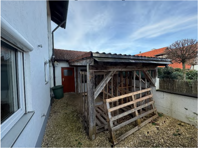
Bild 46 – Überdachung östlich Garage
