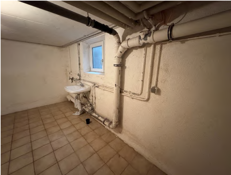
Bild 12 und Bild 13 – Keller Südost
