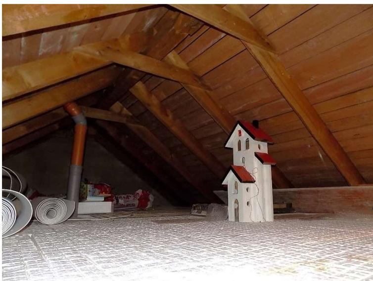
Dachspitz, Kehlbalkendecke gedämmt
