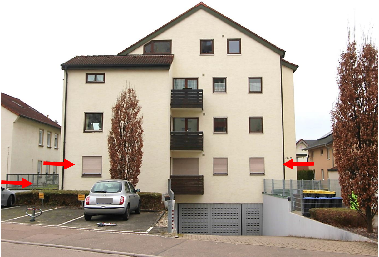
Ostseite Mehrfamilienhaus 32a, Pfeile Wohnung ATP Nr. 8 im EG
