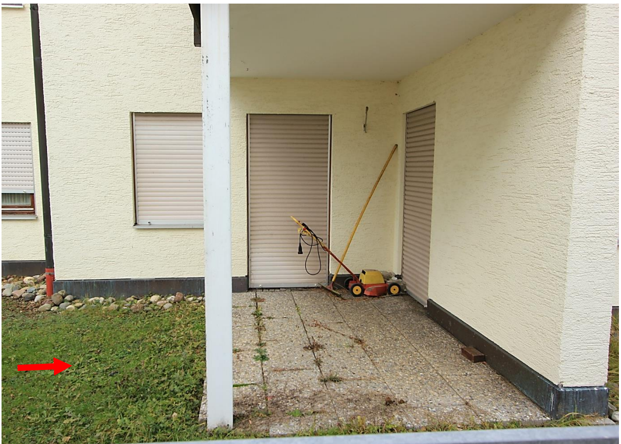
Terrasse im Süden der Wohnung Nr. 8 im EG, Pfeil links Garten
