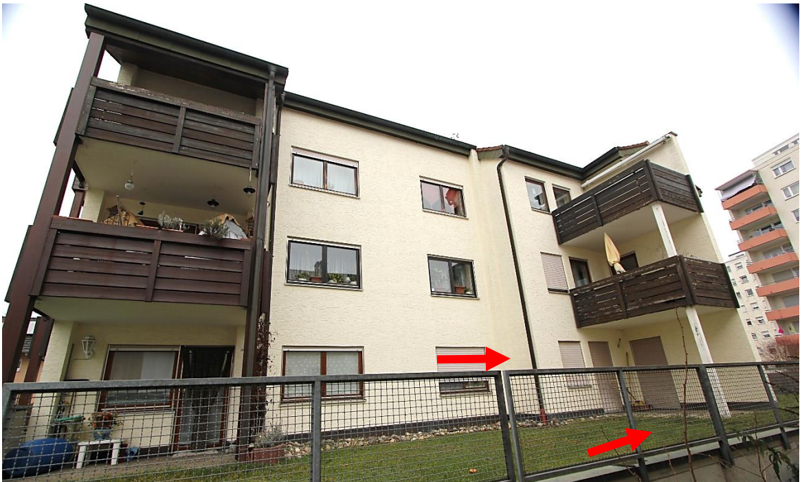
Südseite Mehrfamilienhaus 32a, Pfeile Wohnung ATP Nr. 8 im EG mit Garten
