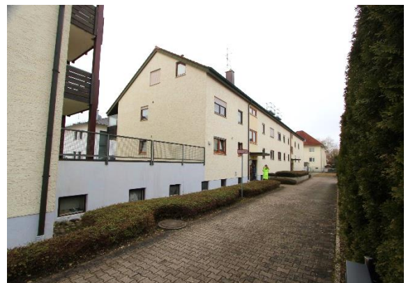
Zufahrt im Norden, hinten Häuser 32b +32c
