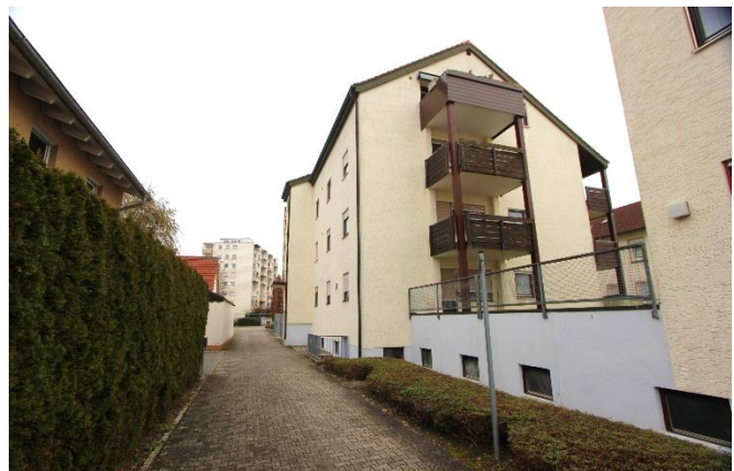
Weg von Westen, rechts Tiefgarage, hinten 32a
