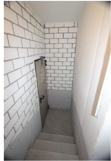
Schleuse zur Tiefgarage
