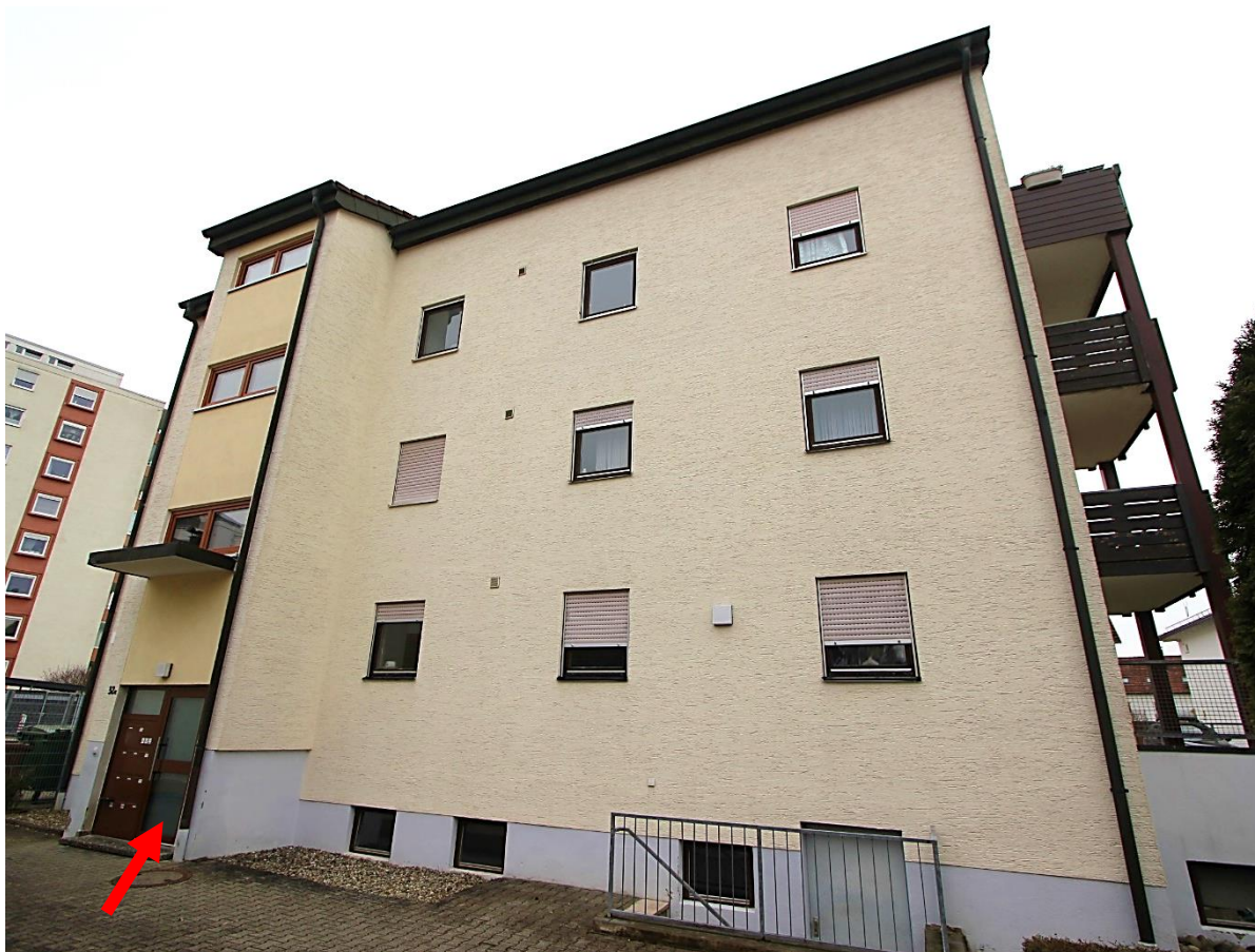
Nordseite Mehrfamilienhaus 32a, Pfeil Hauseingang
