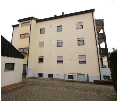
Nordseite Mehrfamilienhaus 32a
