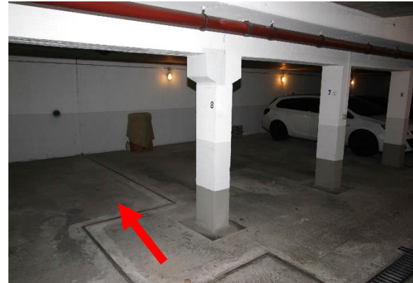
Tiefgarage, Pfeil Stellplatz Nr. 8
