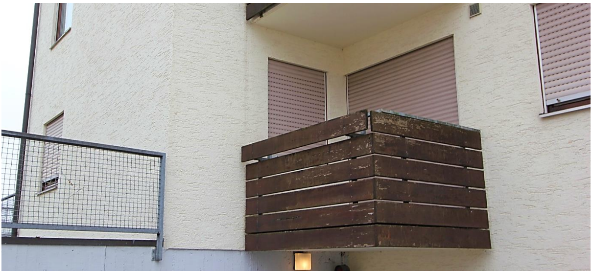
Eckbalkon der Wohnung ATP Nr. 8 im EG über der Tiefgarageneinfahrt
