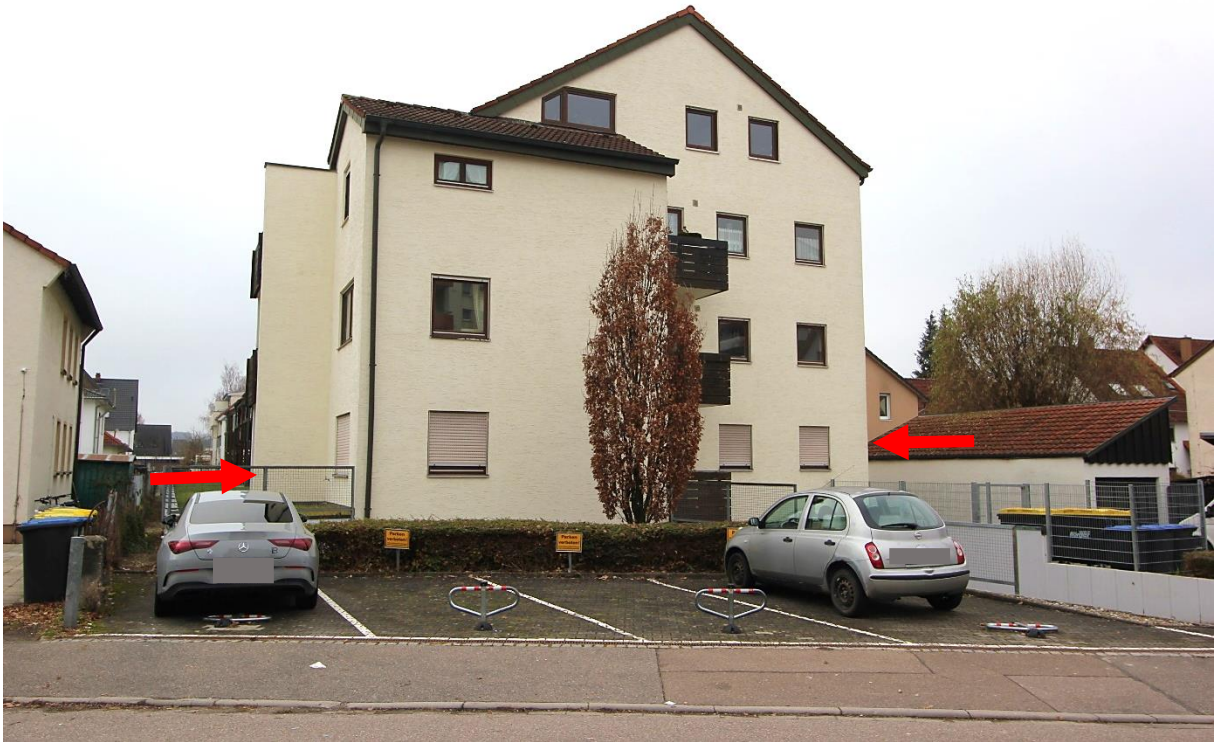
Ostseite Mehrfamilienhaus 32a, Pfeile Wohnung ATP Nr. 8 im EG
