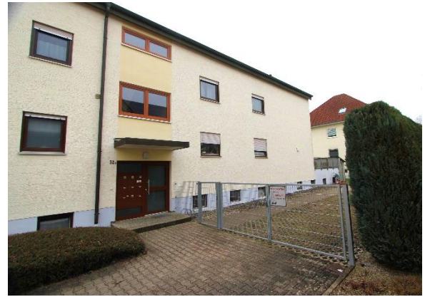
Nordseite Mehrfamilienhaus 32c ganz hinten
