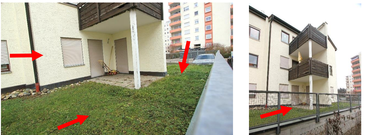
Terrasse und Sondernutzungsrecht am Garten auf dem Tiefgaragendach
