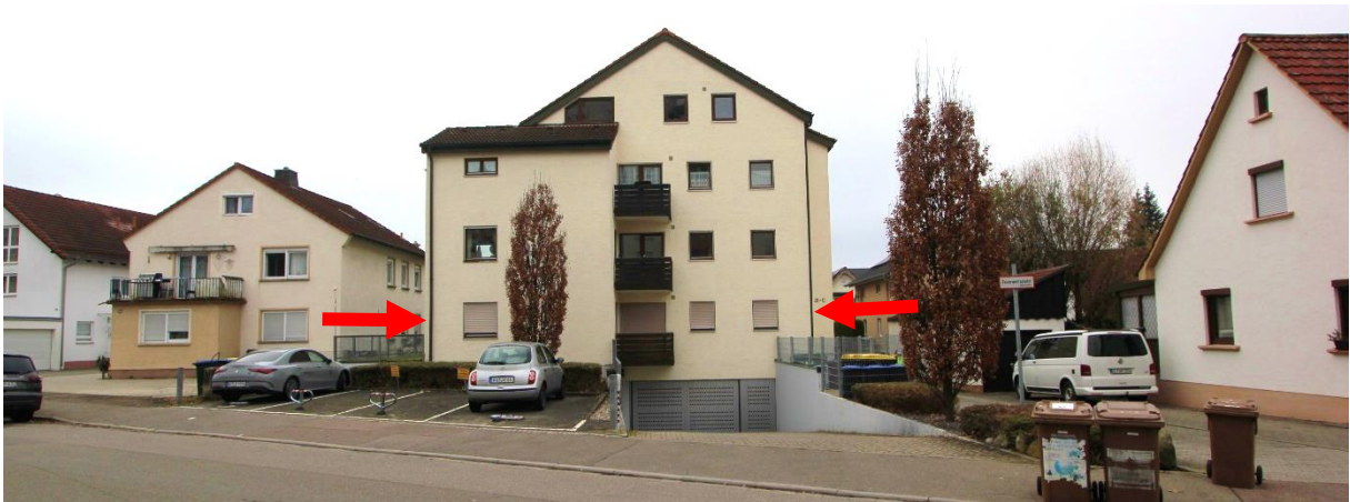
Ostseite Mehrfamilienhaus 32a, Pfeile Wohnung ATP Nr. 8 im EG, unten TG-Zufahrt
