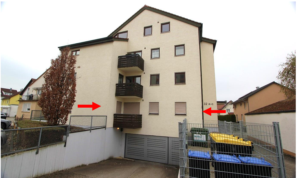
Mehrfamilienhaus 32a von Nordosten, unten Tiefgarage, Pfeile Wohnung ATP Nr. 8 im EG
