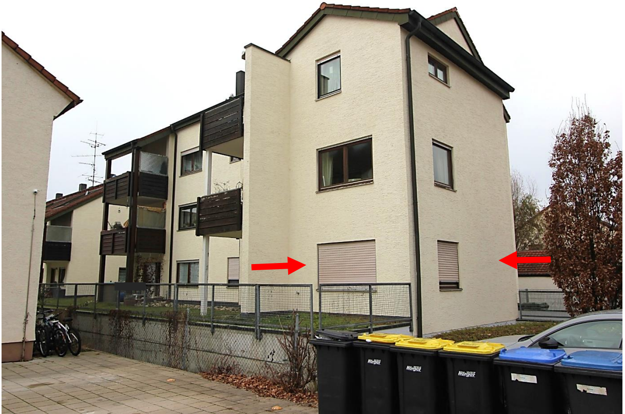
Mehrfamilienhaus 32a von Südosten, Pfeil Wohnung ATP Nr. 8 im EG
