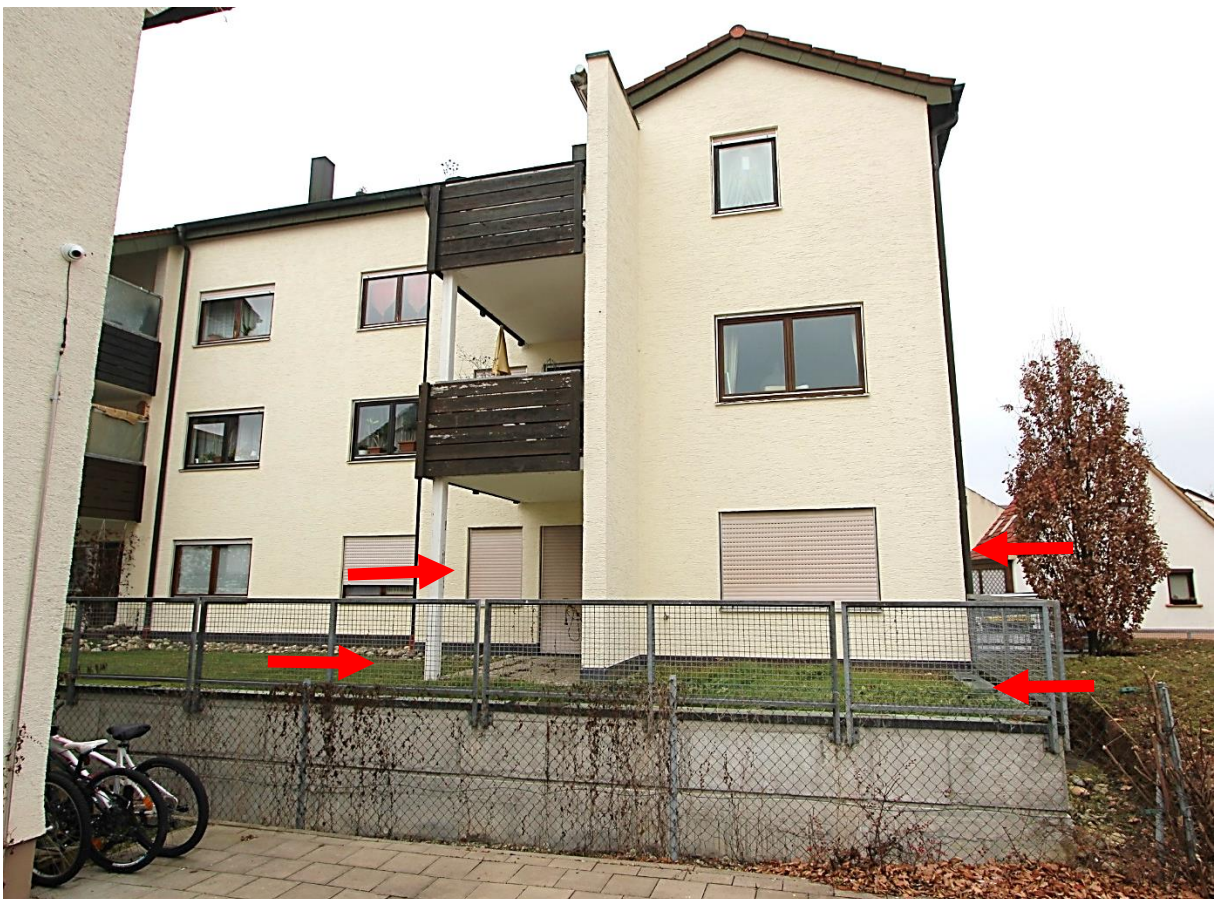
Südseite Mehrfamilienhaus 32a, Pfeile Wohnung ATP Nr. 8 im EG mit Garten
