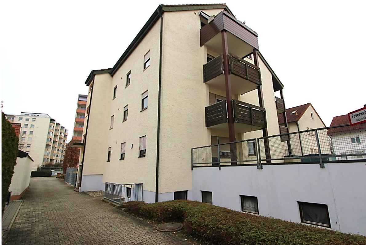
Mehrfamilienhaus 32a von Nordosten, rechts Tiefgarage
