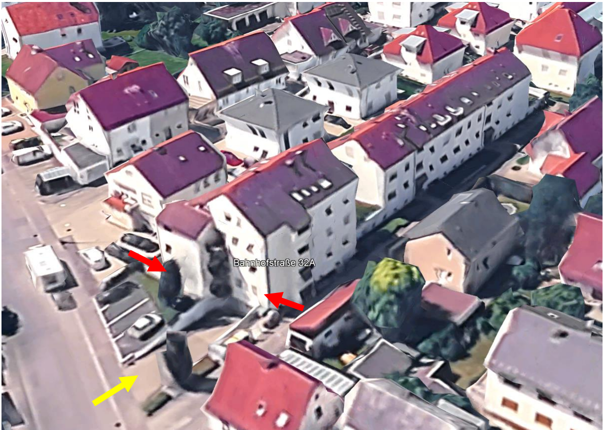
Blick von Norden, Pfeil rot Wohnung ATP Nr. 8 im EG, Pfeil gelb Tiefgarageneinfahrt
