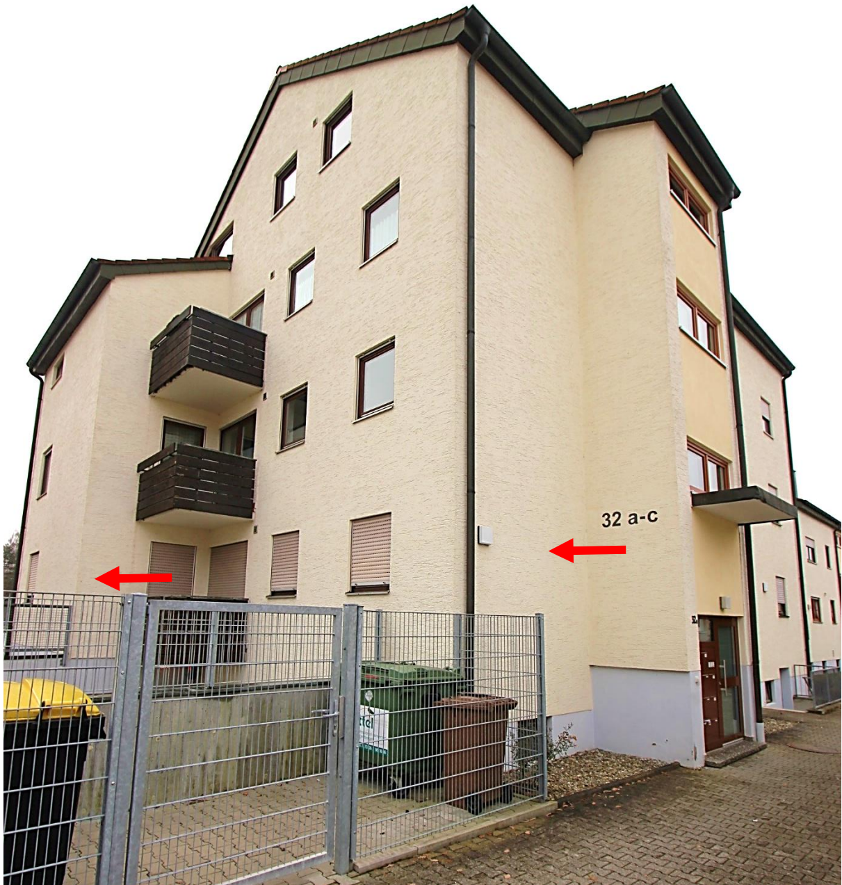
Mehrfamilienhaus 32a von Nordosten, Pfeile Wohnung ATP Nr. 8 im EG, rechts Hauseingang
