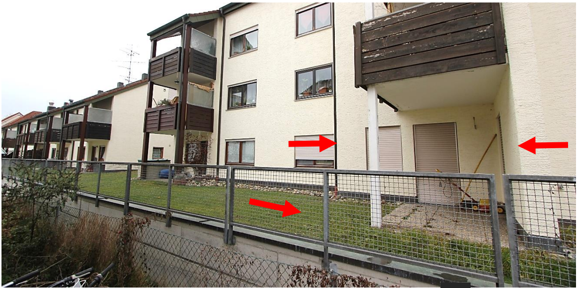
Südseite Mehrfamilienhäuser, Pfeile Wohnung ATP Nr. 8 im EG mit Garten
