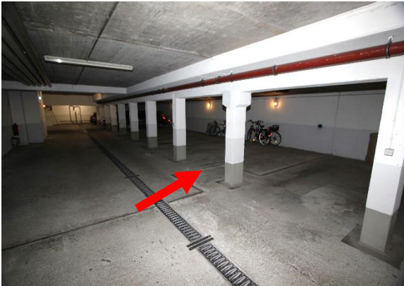
Tiefgarage, Pfeil Stellplatz Nr. 8
