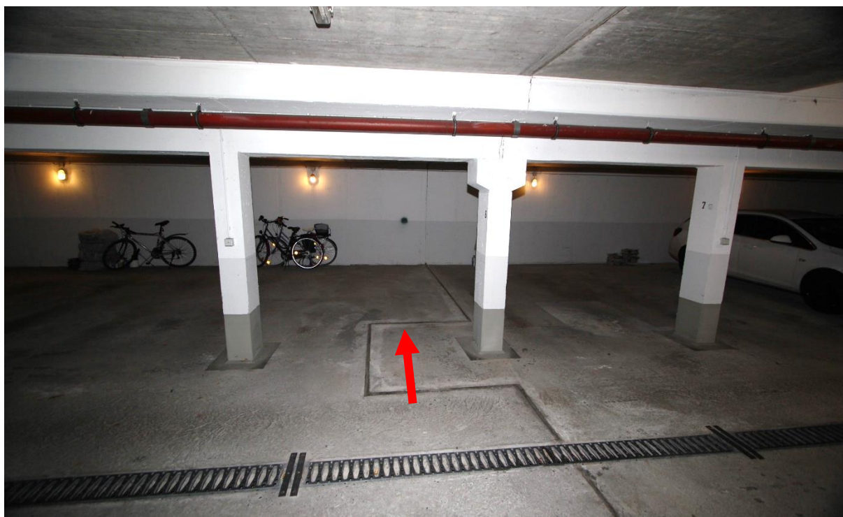
Tiefgarage, Pfeil Stellplatz Nr. 8
