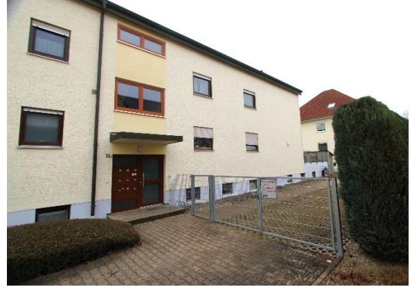
Nordseite Mehrfamilienhaus 32c ganz hinten
