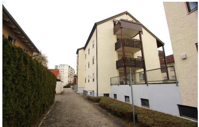
Weg von Westen, rechts Tiefgarage, hinten 32a
