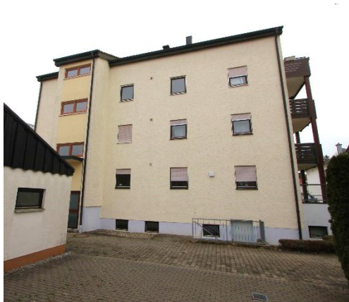
Nordseite Mehrfamilienhaus 32a
