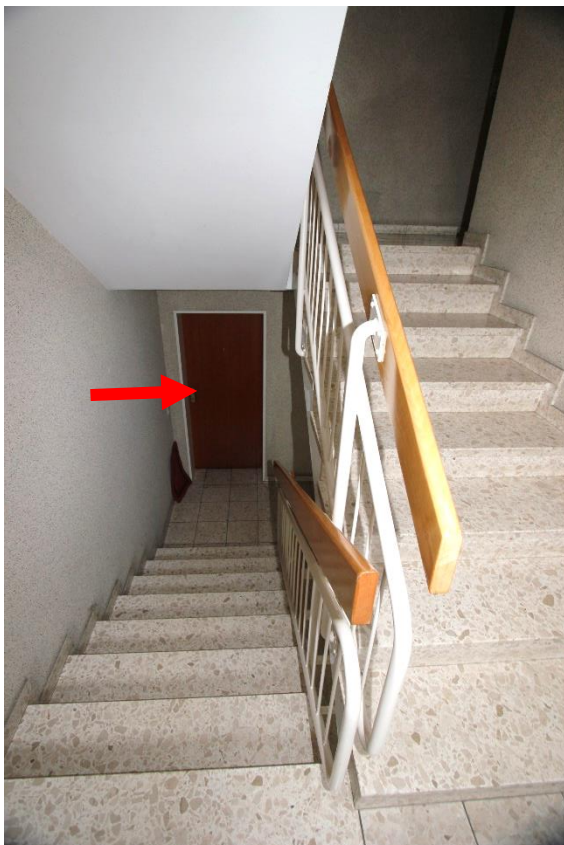
Treppenhaus EG/1. OG, Pfeil Wohnung Nr. 8
