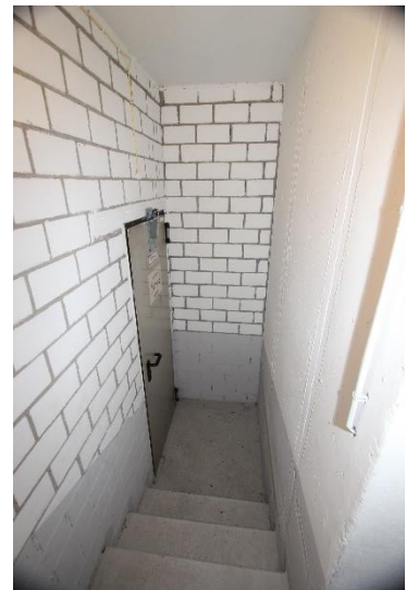
Schleuse zur Tiefgarage
