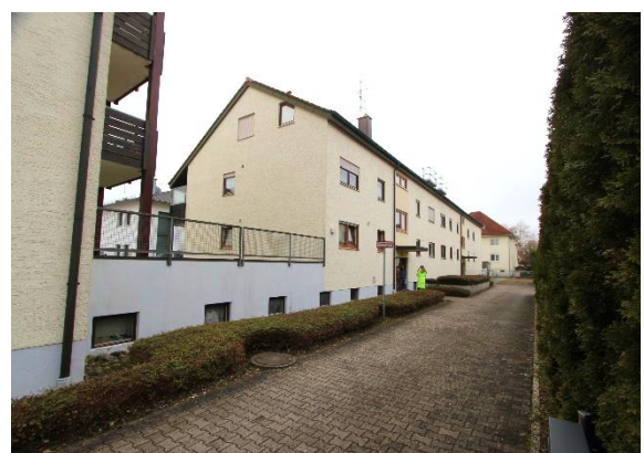
Zufahrt im Norden, hinten Häuser 32b +32c
