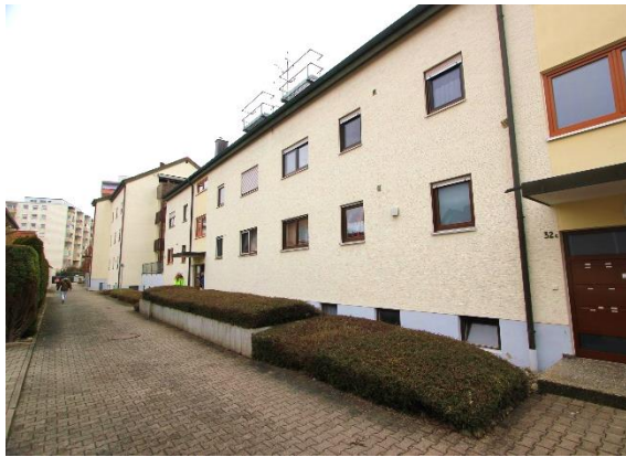
Nordseite Mehrfamilienhaus 32b
