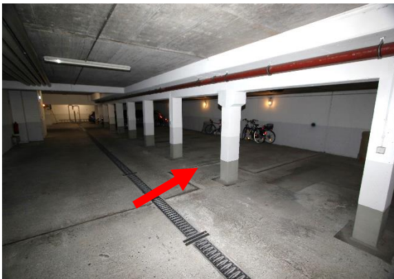
Tiefgarage, Pfeil Stellplatz Nr. 8
