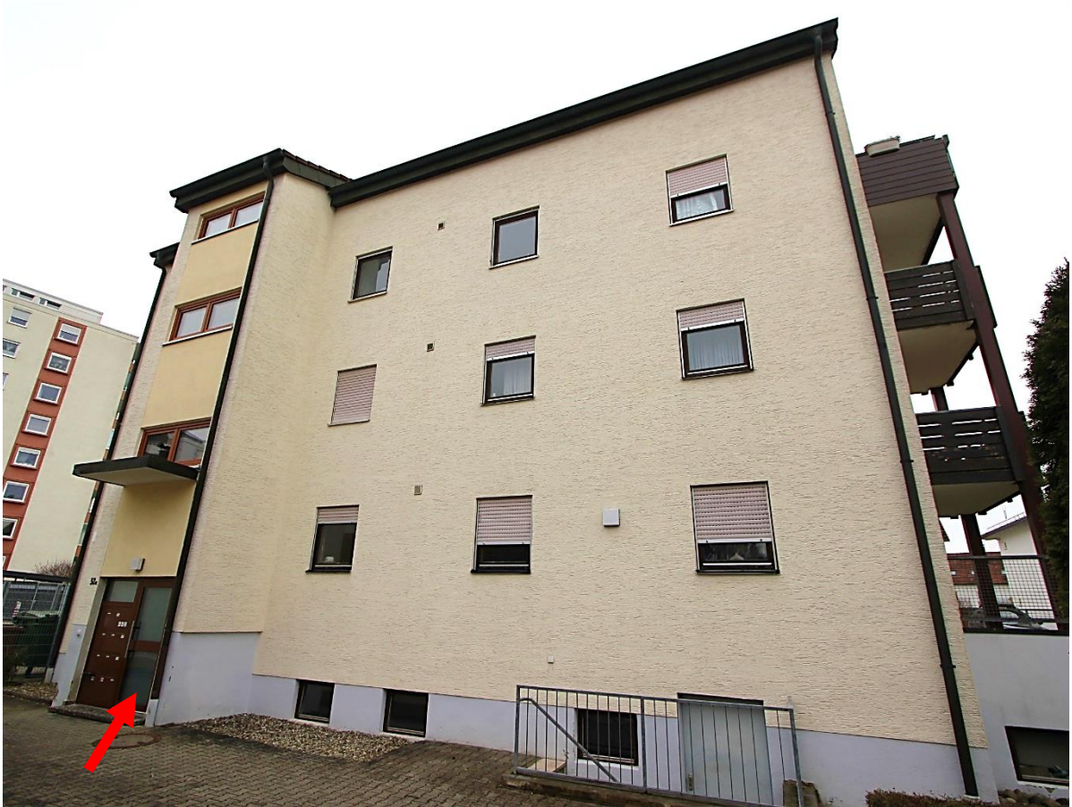
Nordseite Mehrfamilienhaus 32a, Pfeil Hauseingang
