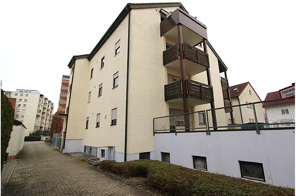
Mehrfamilienhaus 32a von Nordosten, rechts Tiefgarage
