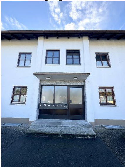
Bild 2 – Norden, Blick auf Hauseingang
