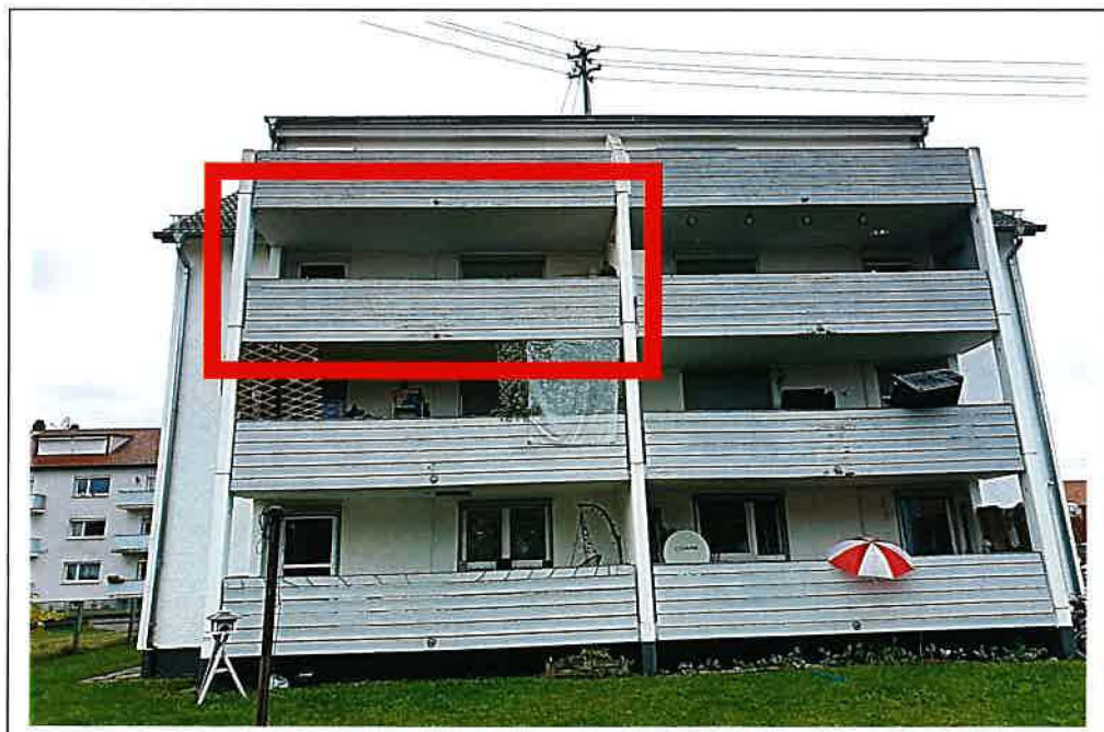
Foto 6: 89250 Senden, Ruländerstraße 17, Ansicht Süd
