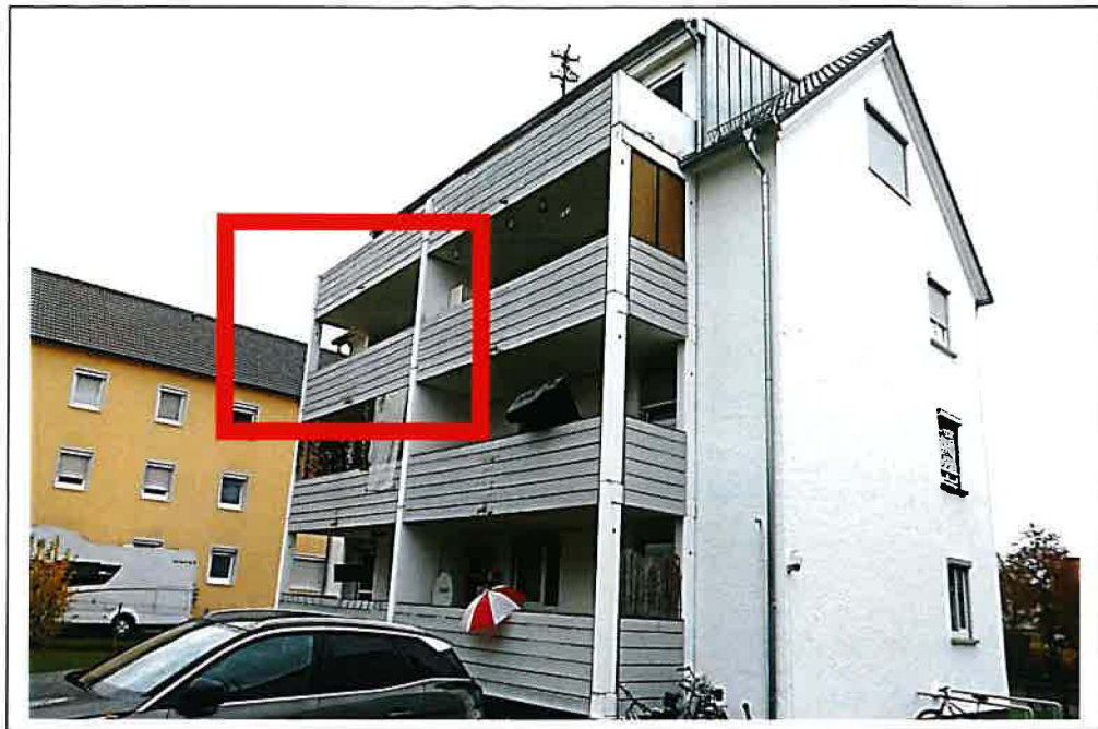
Foto 5: 89250 Senden, Ruländerstraße 17, Ansicht Südost
