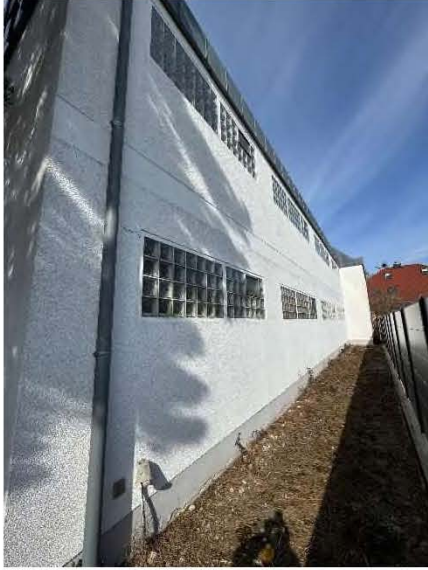
Bild 17 – Bürogebäude Süd von Süden
