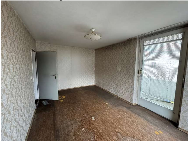
Bild 67 – Wohnung OG: Balkon
