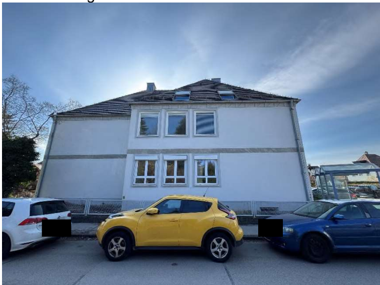
Bild 3 – Bürogebäude Ost von Osten
