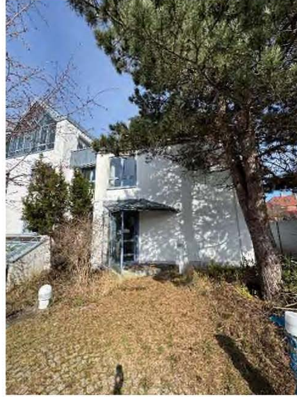
Bild 18 – Bürogebäude Süd von Westen
