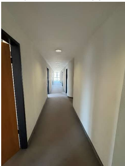
Bild 161 – Flur Nord 2. OG
