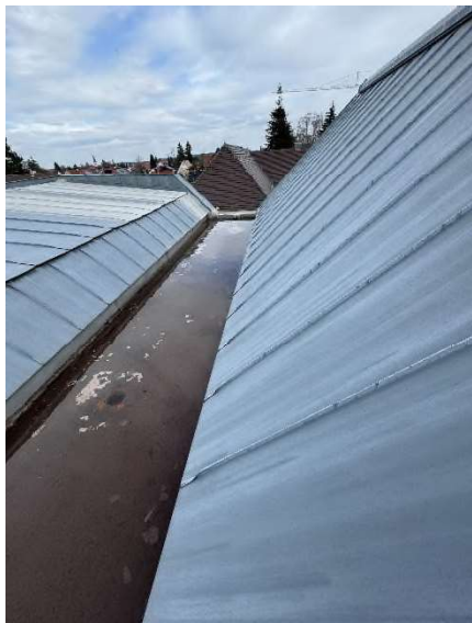
Bild 182 und Bild 183 – Blick auf Kastenrinnen mit verstopftem Ablauf
