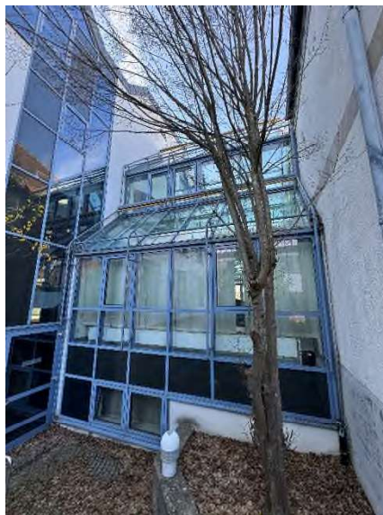
Bild 14 – Eingangshalle von Süden
