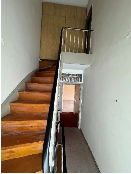
Bild 71 – nicht ausgebauter Dachboden über Wohnung
