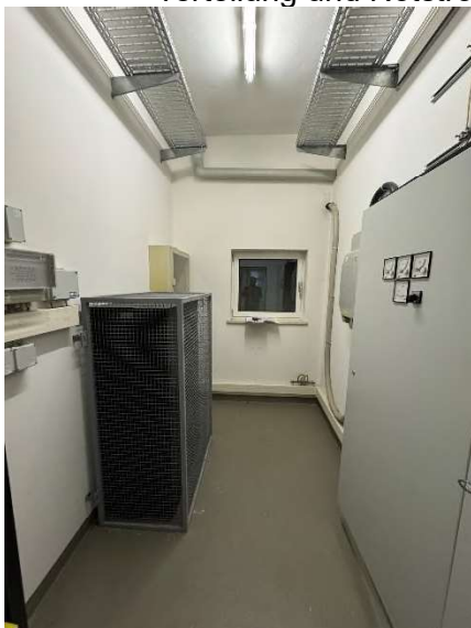
Bild 107 – Hausanschlussraum mit Elektrohaupt- verteilung und Notstromakku
