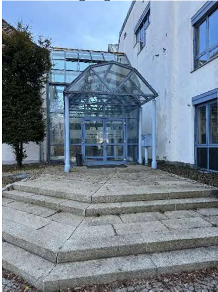
Bild 8 – Bürogebäude West von Osten
