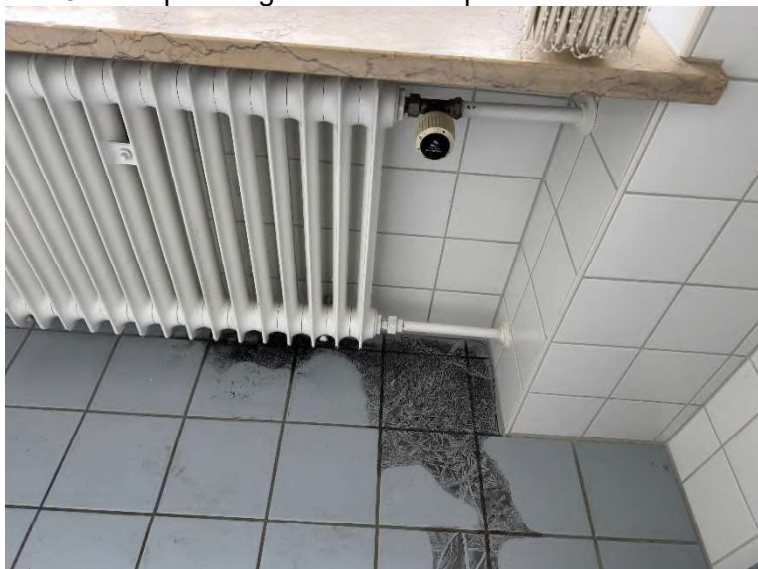
Bild 31 – Abplatzungen am Heizkörper Büro 2
