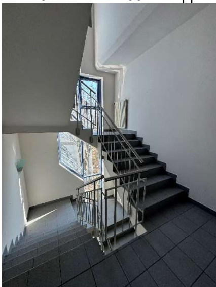
Bild 134 und Bild 135 – Treppenhaus 1. OG
