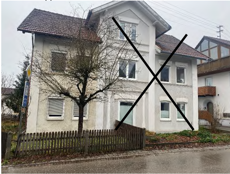
Bild 2 – Doppelhaushälfte von Süden
