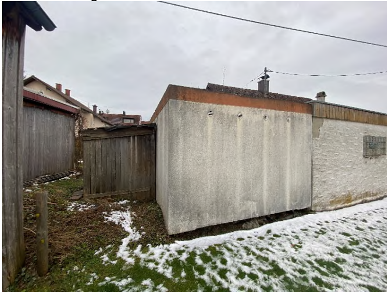
Bild 7 – Garage von Norden
