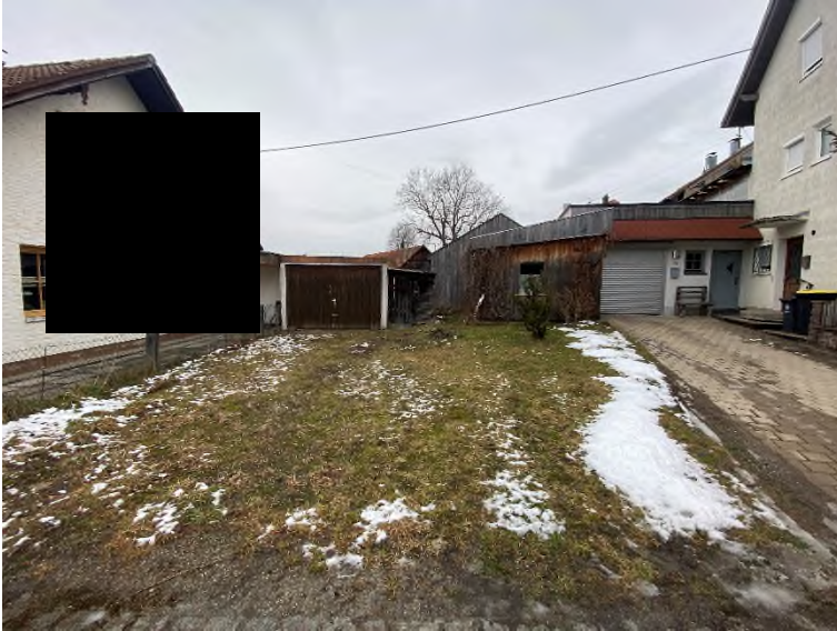
Bild 5 – Garage von Süden und Osten
