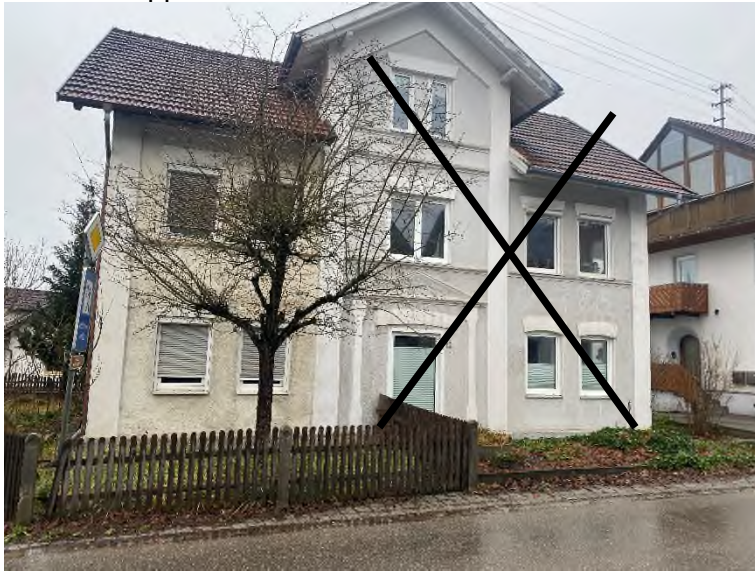
Bild 2 – Doppelhaushälfte von Süden
