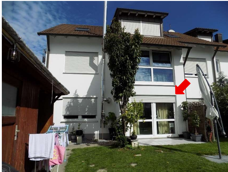
Ansicht von Süden, Pfeil: Whg. Nr. 1 mit vorgelagertem Garten zur Sondernutzung
