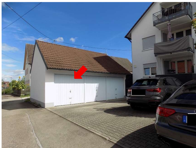
Garagegebäude 4.4.2, Pfeil: Garage Nr. 1
