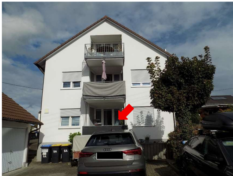
Ansicht von Westen, Pfeil: Loggia der Wohnung Nr. 1
