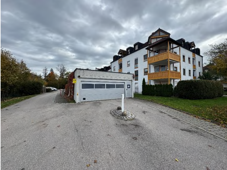
Bild 7 – Blick auf nördliche Zufahrt und auf Tiefgarageneinfahrt
