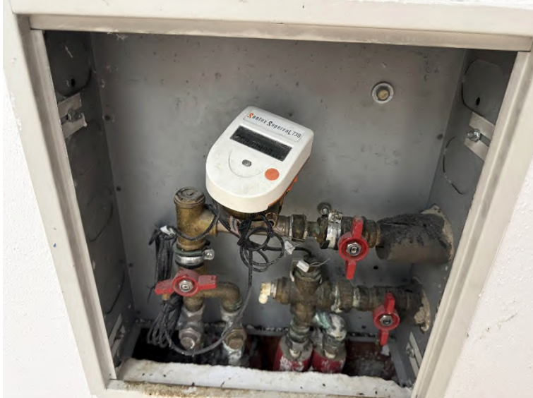
Bild 29 – Blick auf Kellerraum Nr. 22
