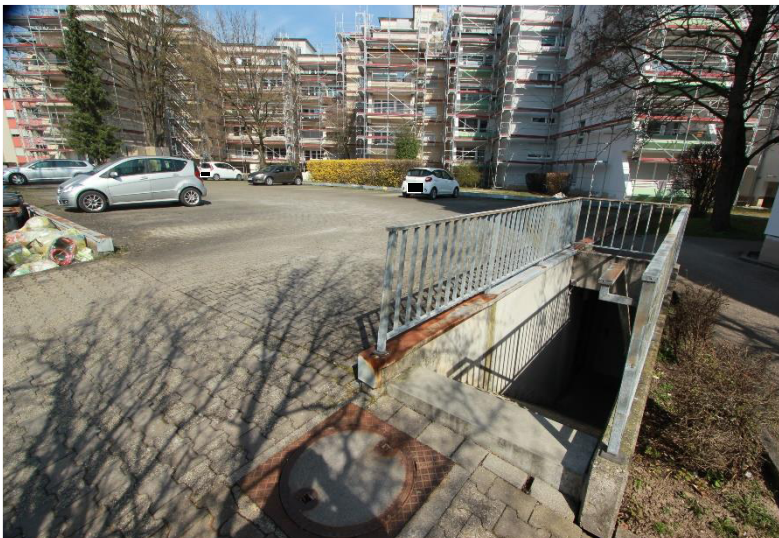
Parkplatz mit Abgangstreppe zur Tiefgarage von Süden
