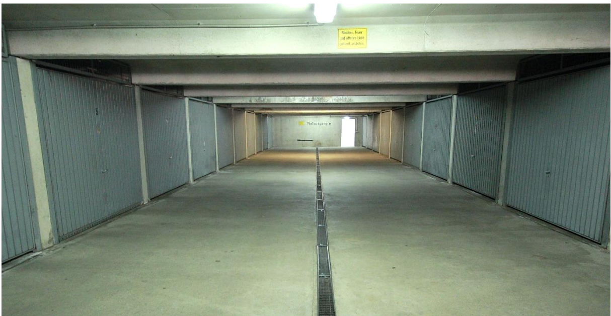
Garagen in der Tiefgarage
