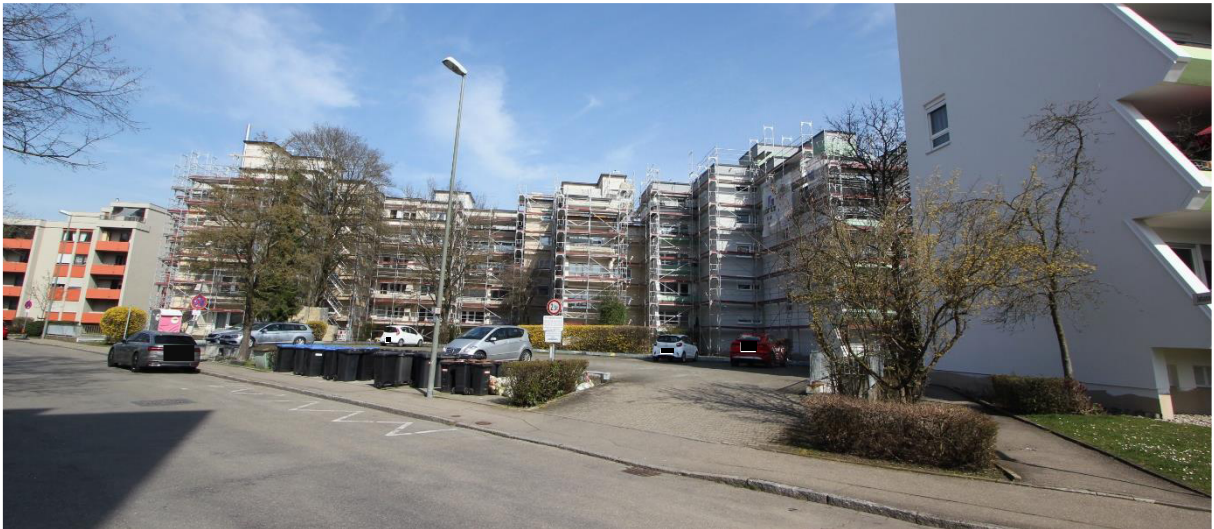
Eigentumsanlage mit Gebäuden Johann-Strauß-Str. 13 - 19 und Parkplatzzufahrt von Süden
