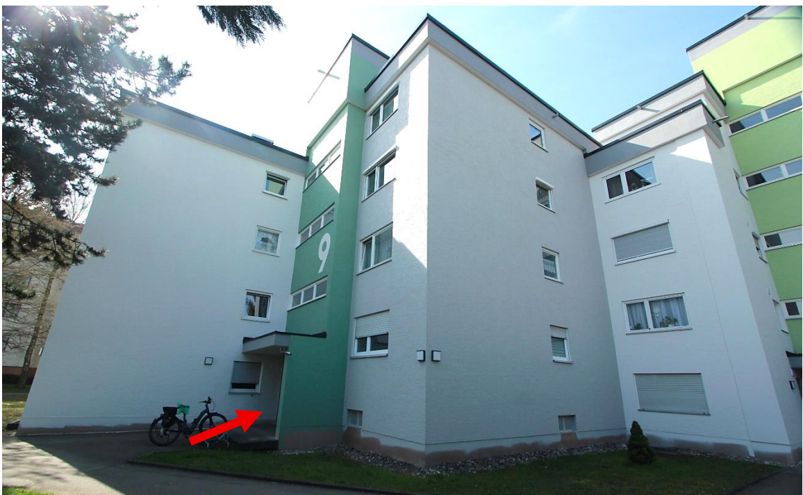
Gebäude Johann-Strauß-Str. 9 von Nord/Nordosten, Pfeil Hauseingang
