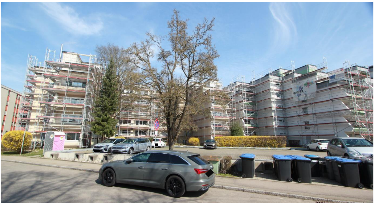
Eigentumsanlage mit Gebäuden Johann-Strauß-Str. 13 - 19 und Parkplatz von Süd/Südwesten
