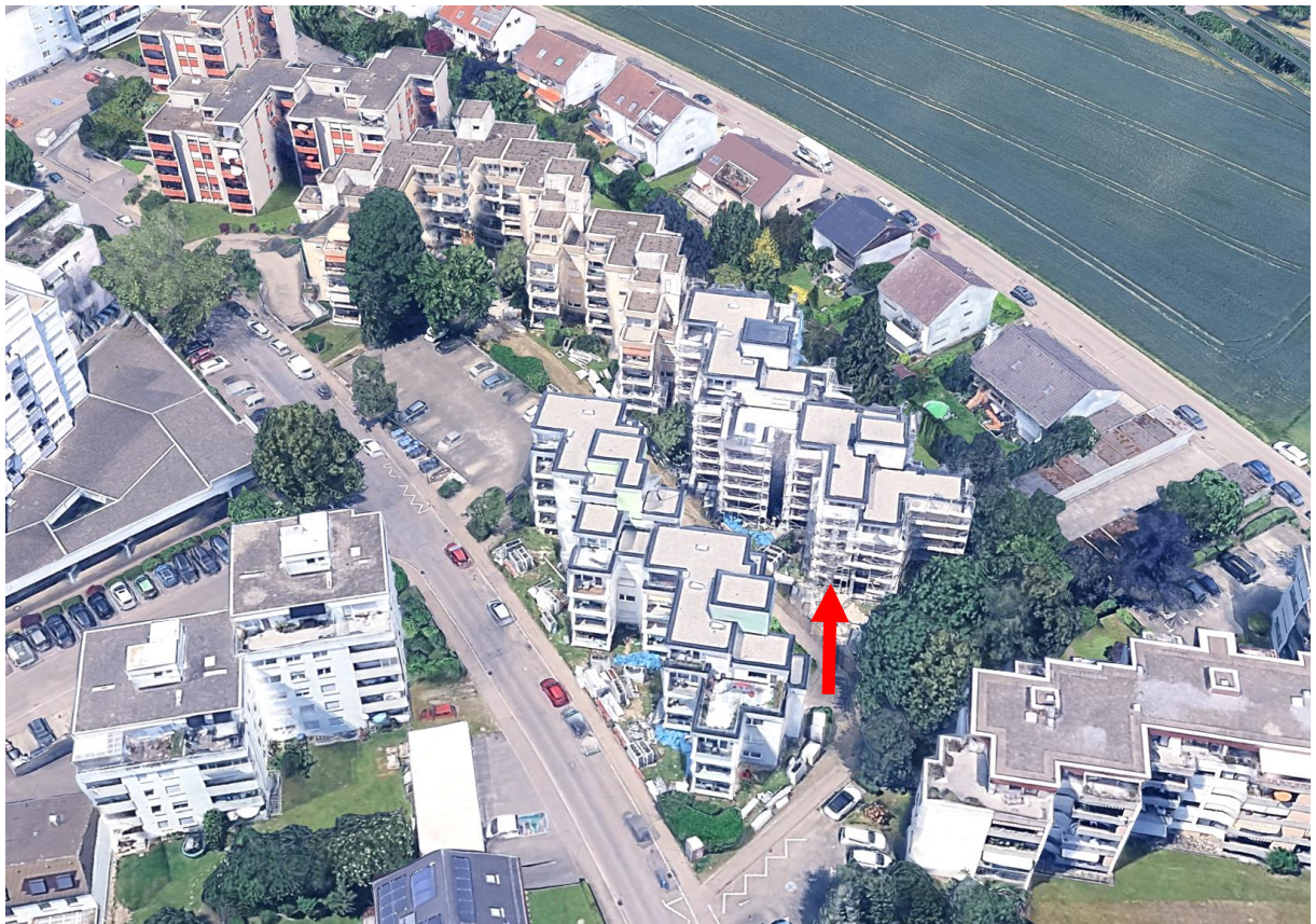
Eigentumsanlage von Süden, roter Pfeil EG-Wohnung ATP Nr. 2 in Haus 9
