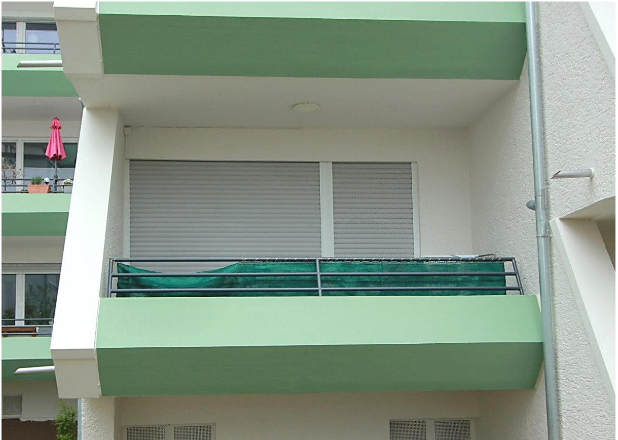
Balkon der Wohnung ATP Nr. 2 im EG nach Süden, dahinter Wohnzimmerfenster mit Balkontür
