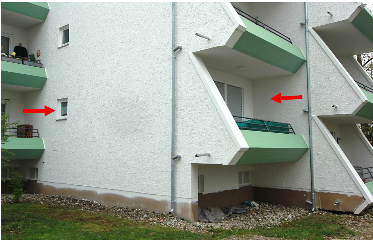
Wohnung ATP Nr. 2 im EG von Haus 9 von Südwesten, links Küchenfenster
