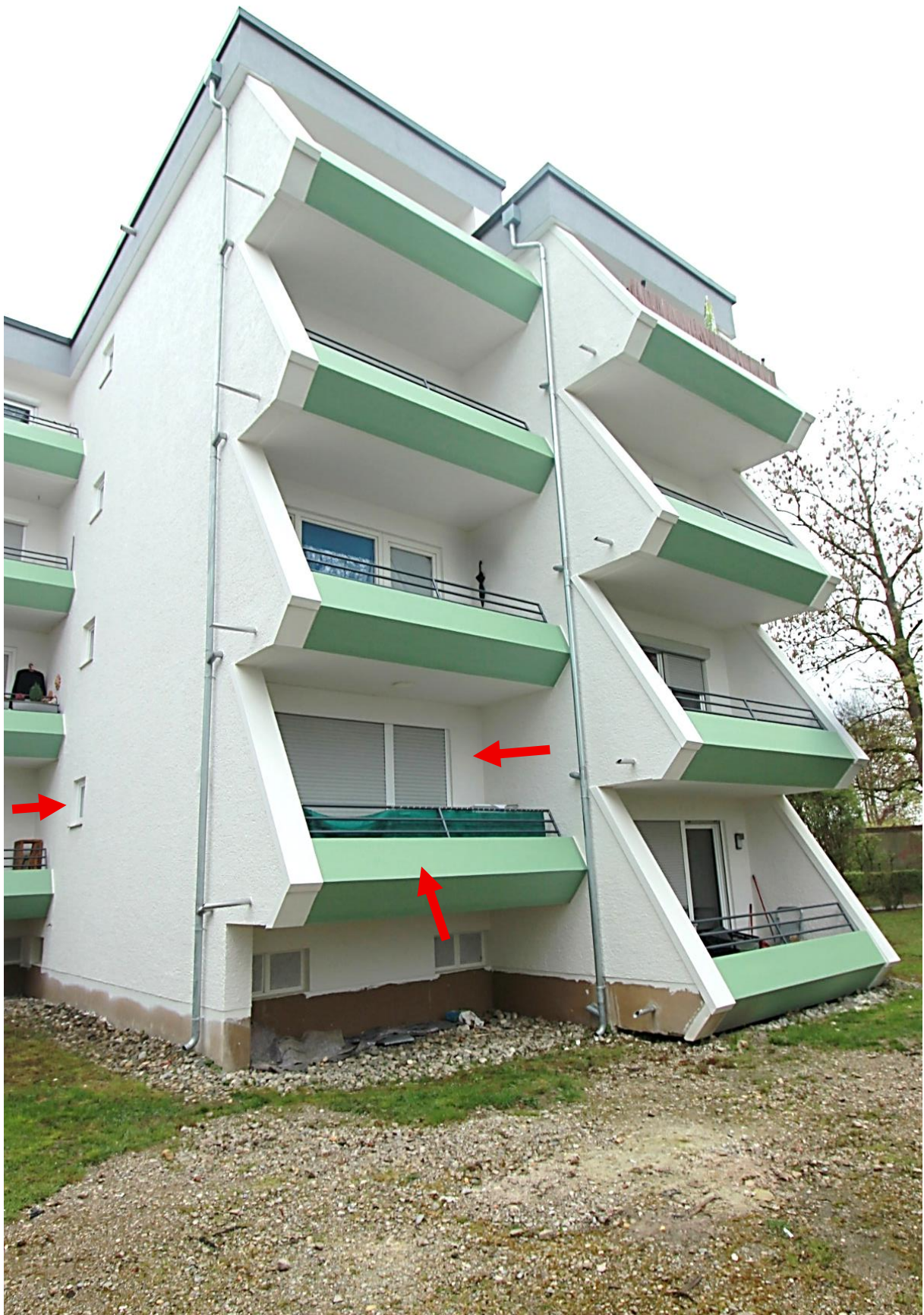
Südwestseite Gebäude 9, Pfeile Wohnung ATP Nr. 2 im halb hoch versetzten EG
