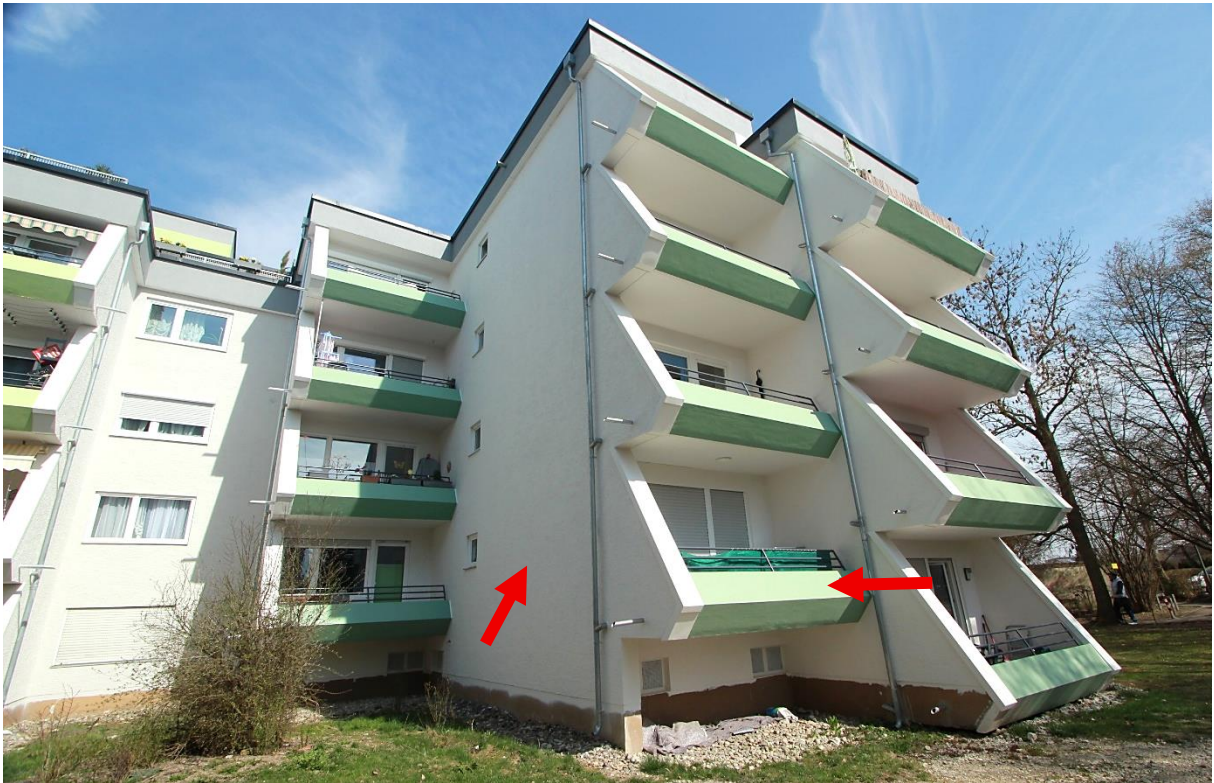
Haus Nr. 9 von Südwesten, Pfeile Wohnung ATP Nr. 2 im EG
