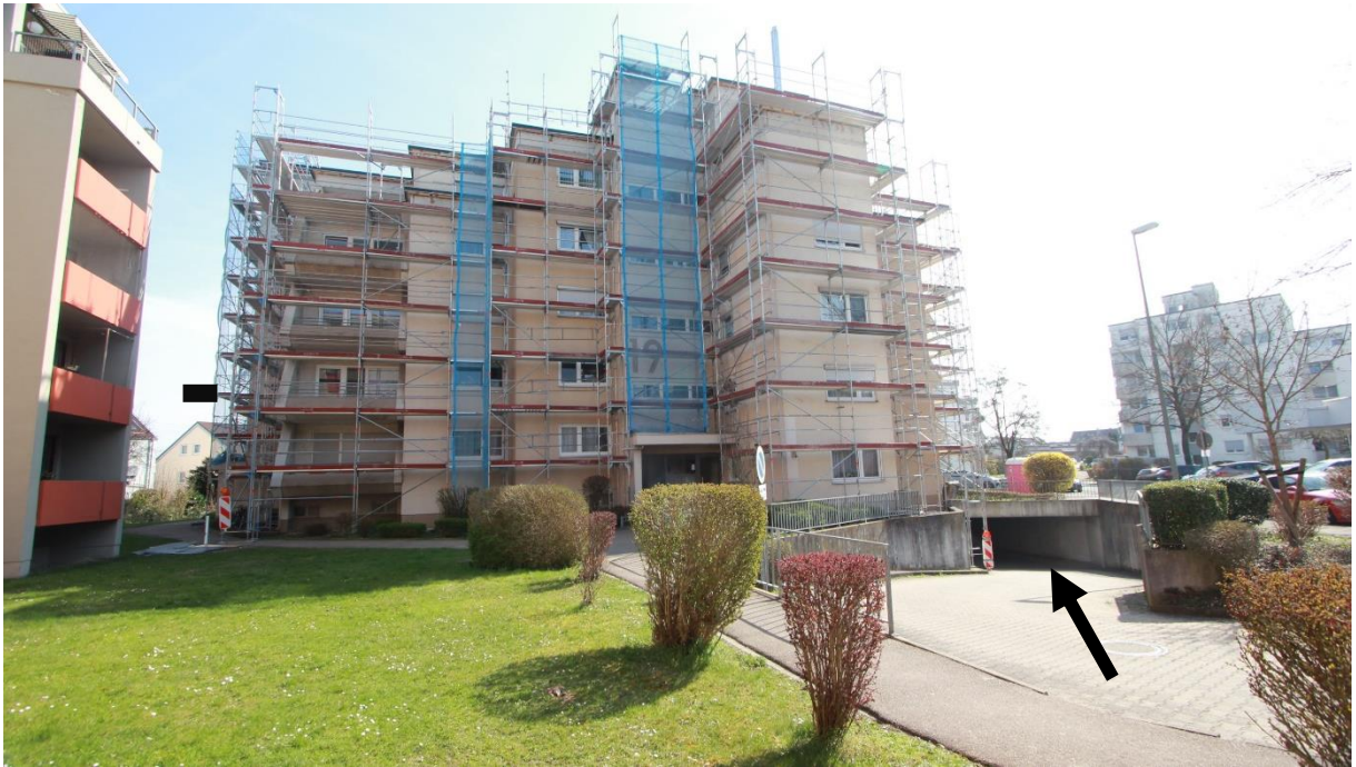
Eigentumsanlage mit Gebäude Johann-Strauß-Str. 19 von Westen, Pfeil Tiefgaragenzufahrt
