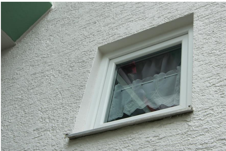
Küchenfenster Wohnung ATP Nr. 2 nach Westen
