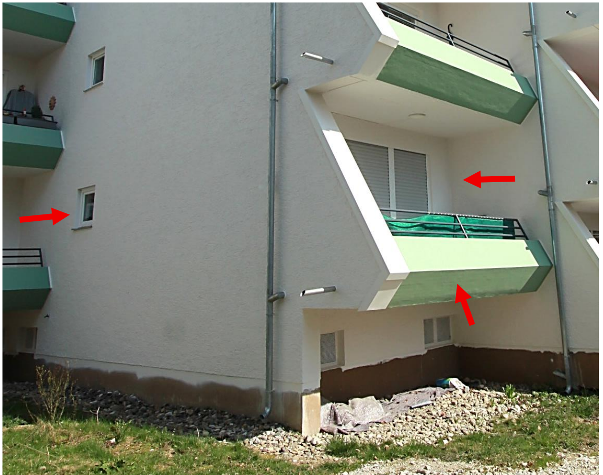
Wohnung ATP Nr. 2 im EG von Haus 9 von Südwesten, links Küchenfenster
