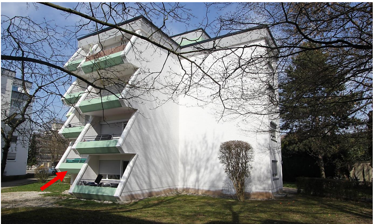
Gebäude Johann-Strauß-Str. 9 von Südosten, Pfeil Balkon ATP Nr. 2
