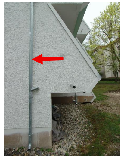
Neue außenliegende Fallrohre
