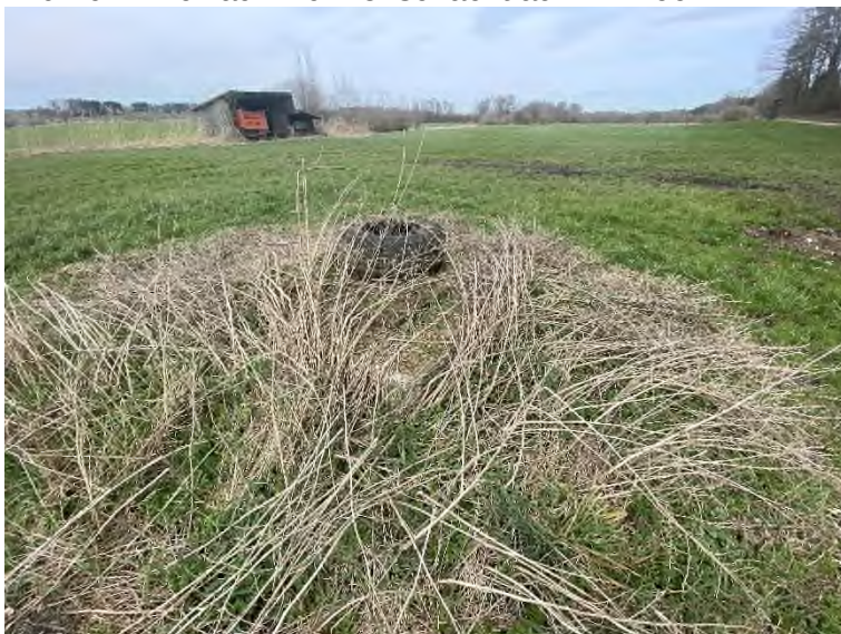
Bild 10 – Blick auf Brunnenschacht auf FINr. 99
