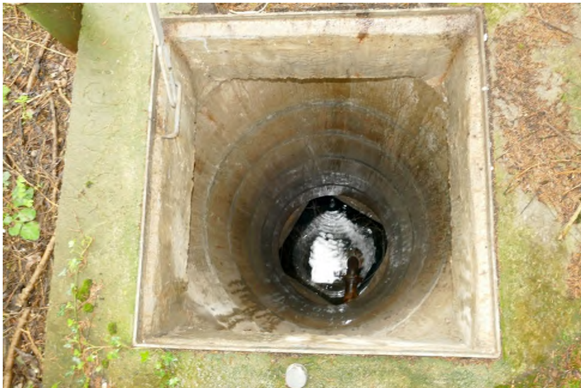
Bild 7 – Blick in Brunnenschacht auf FINr. 96
