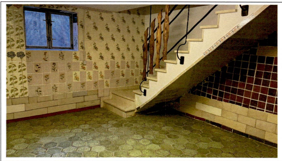
Foto 29: Gang und Treppe im Kellergeschoss
