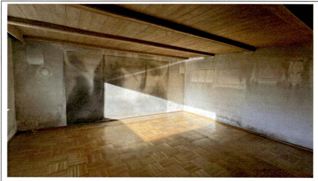
Foto 18: Blick in das Wohnzimmer
