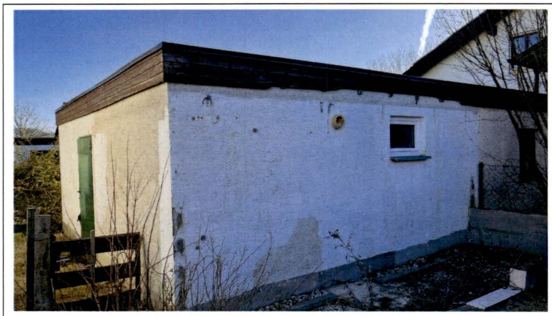
Foto 8: Garage - Ansicht von Westen
