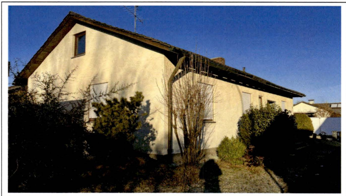
Foto 2: Ansicht von Südosten
