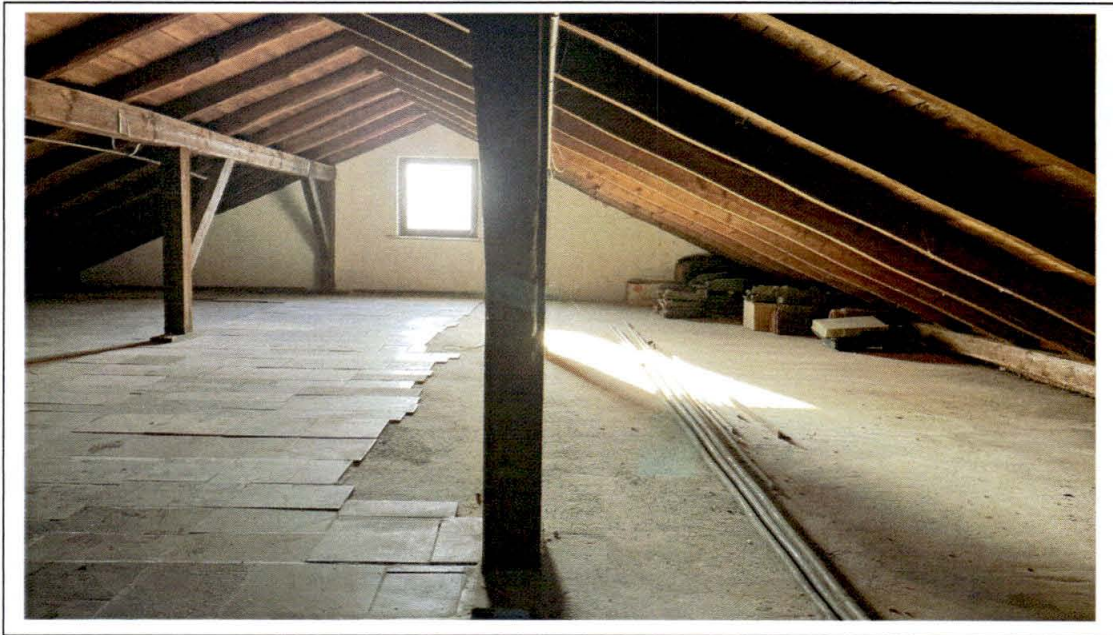
Foto 28: Blick in das Dachgeschoss
