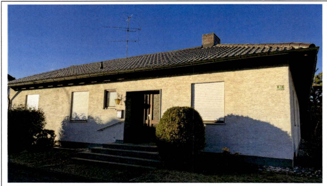
Foto 1: Ansicht von Osten
