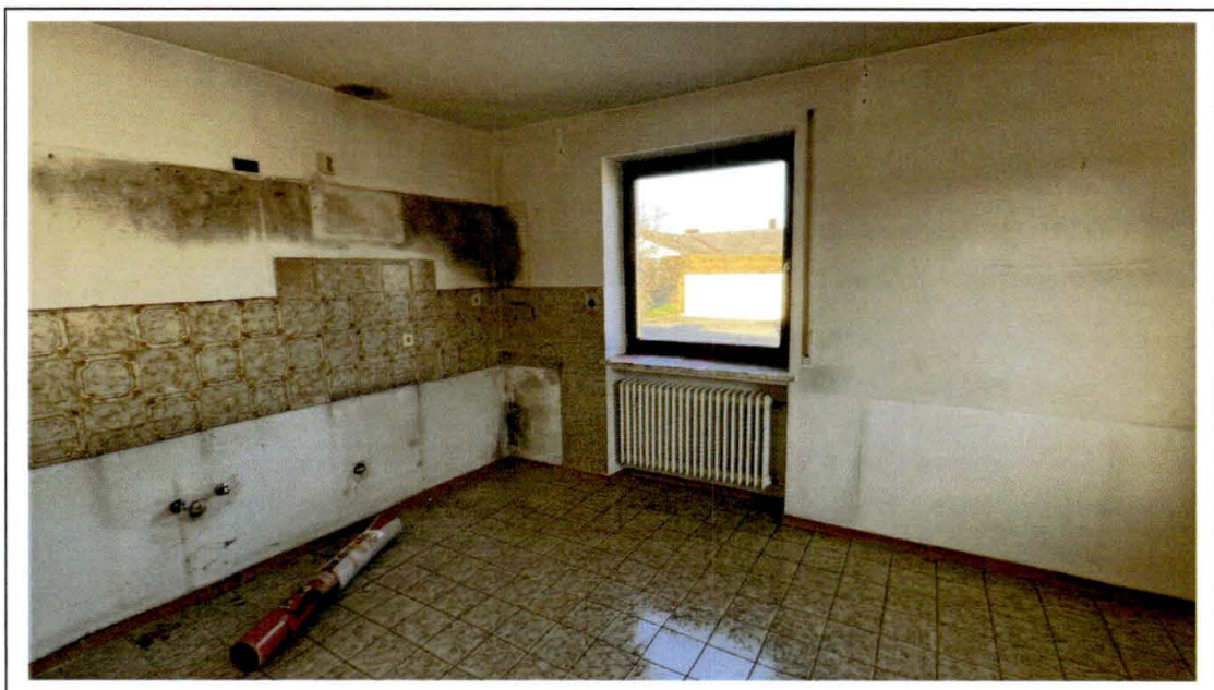
Foto 15: Blick in die Küche
