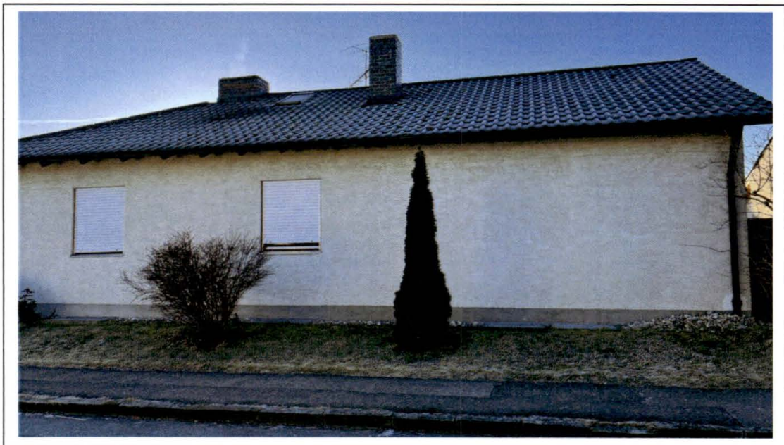
Foto 4: Ansicht von Norden
