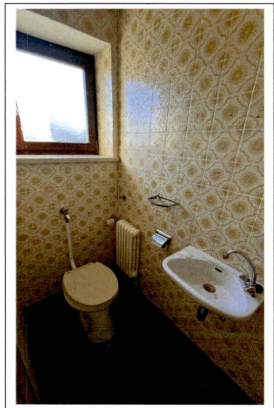
Foto 14: Blick in das WC
