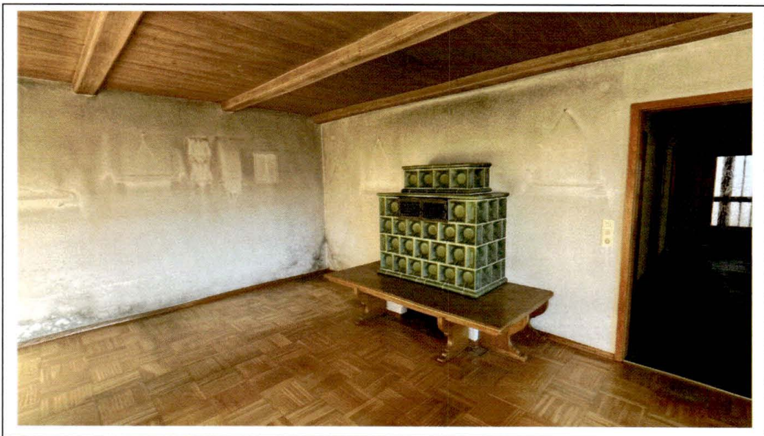
Foto 17: Blick in das Wohnzimmer
