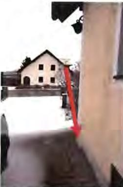
beispielhafte Ansicht der Ablätterung des Sockelputzes an der Fassaden-Nordseite
