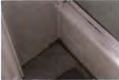
beispielhafte Ansicht der unterschiedlichen Fugenbreite im Bereich der Eckdusche im Bad des Erdgeschosses – Aufnahme 01.12.2020
