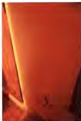
beispielhafte Ansicht des vertikalen Mauerwerksrisses zwischen der Unterkellerung des Wohnhauses und der Unterkellerung der Doppelgarage mit Verfärbungen im unteren Wandbereich – Aufnahme 01.12.2020
