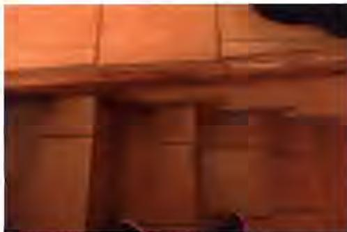
beispielhafte Ansicht der abgeschlagenen Fliesen an der Trittstufe der Verbindungstreppe zwischen der Unterkellerung des Wohnhauses und der Unterkellerung der Doppelgarage – Aufnahme 01.12.2020
