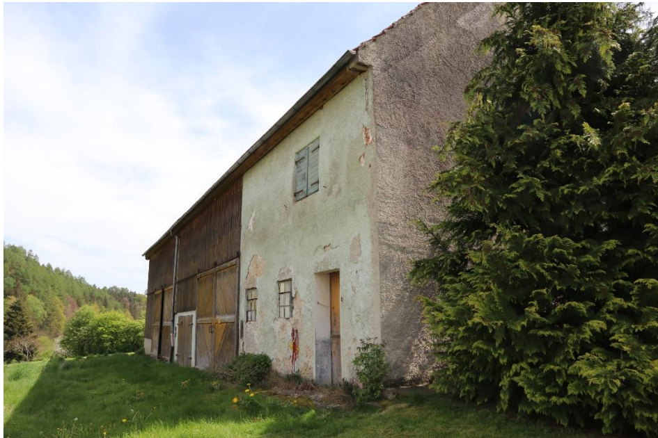
Außenansicht: ehemalige landwirtschaftliche Hofstelle von Westen
