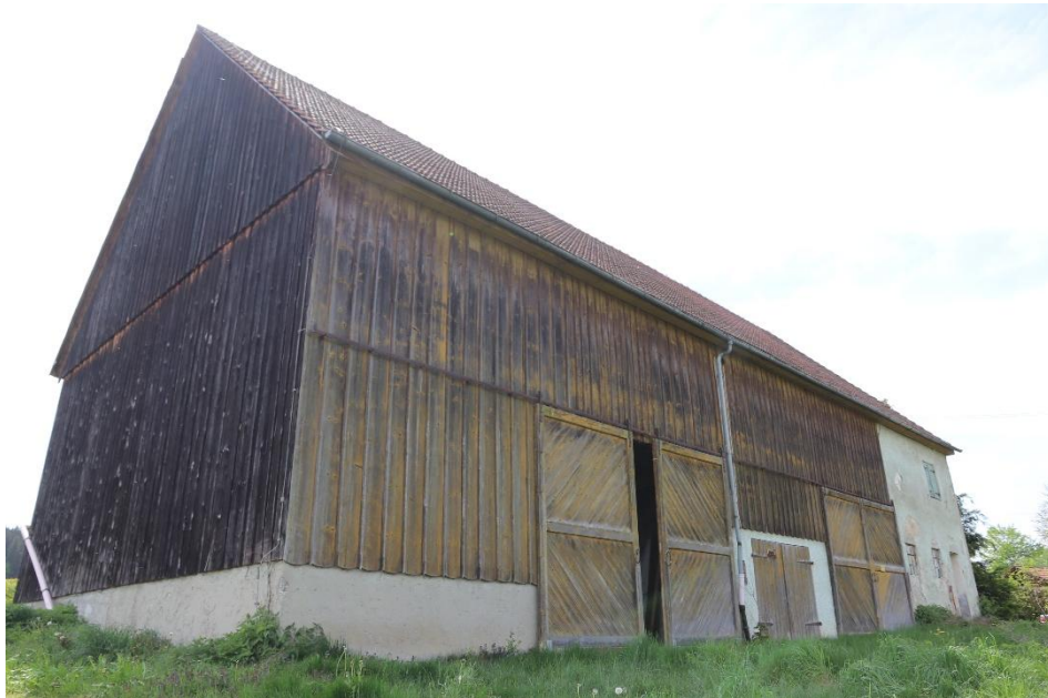
Außenansicht: ehemalige landwirtschaftliche Hofstelle von Osten
