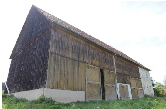
Ansicht von Osten
