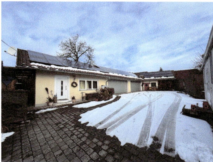
Südostansicht Garagen-/Nebengebäude mit Büroanbau
