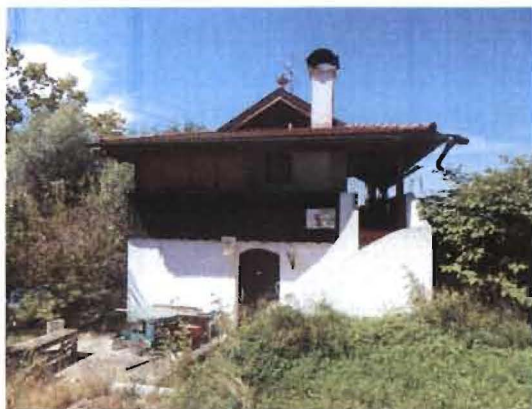
Ostseite des Gebäudes
