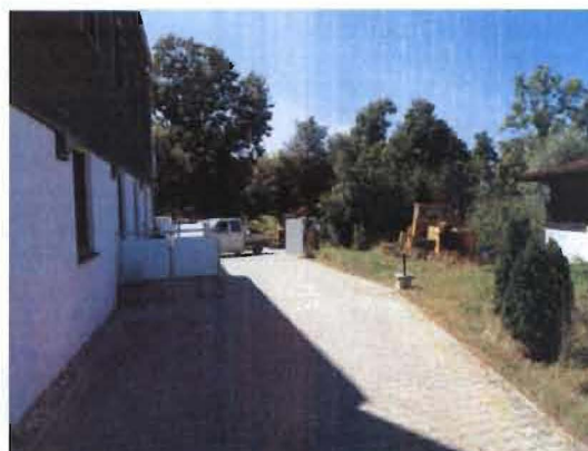
Zufahrt zur Tiefgarage
