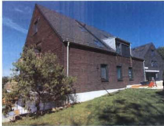
Süd- und Ostseite des Gebäudes Haus-Nr. 11
