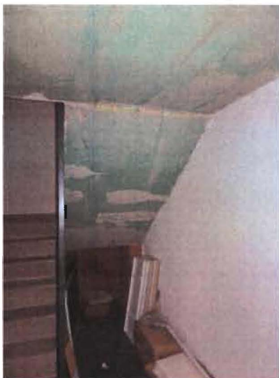
Untersichten Treppe und Decke UG nicht fertiggestellt
