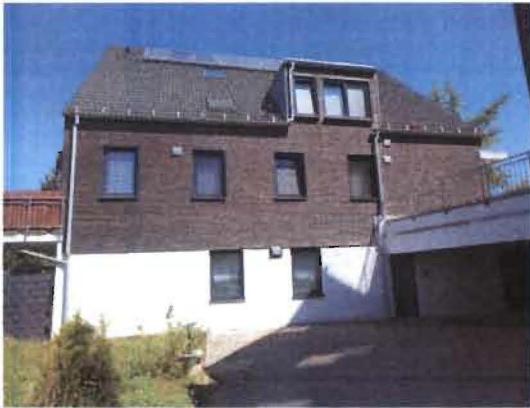
Südseite des Gebäudes Haus-Nr. 11
