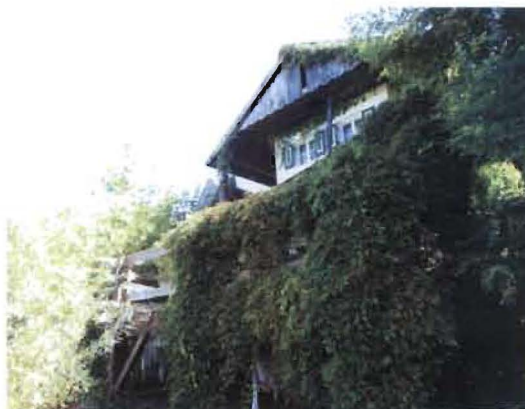
Westseite des Gebäudes
