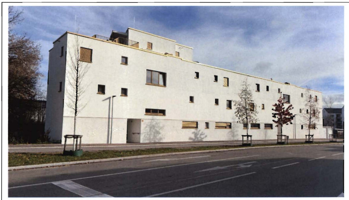
Foto 2: Wohnanlage - Ansicht von Westen
