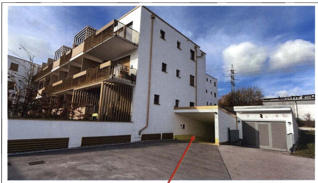
Foto 4: Wohnanlage mit Tiefgaranzufahrt - Ansicht von Südosten
