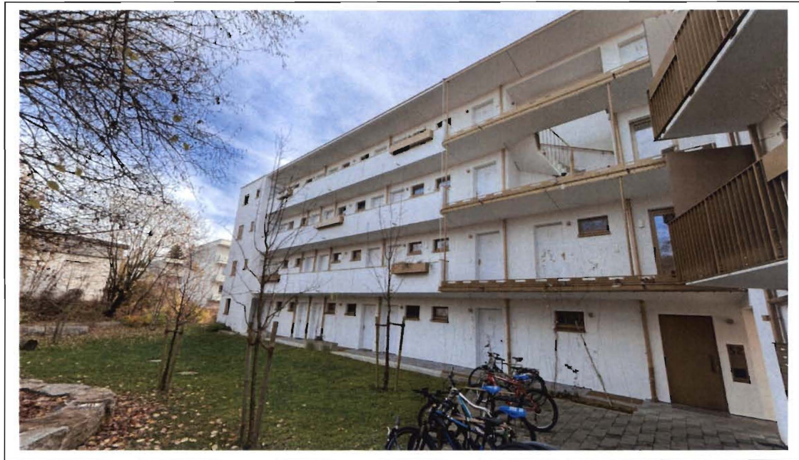
Foto 1: Wohnanlage Haus Nr. 52 - Ansicht von Nordwesten
